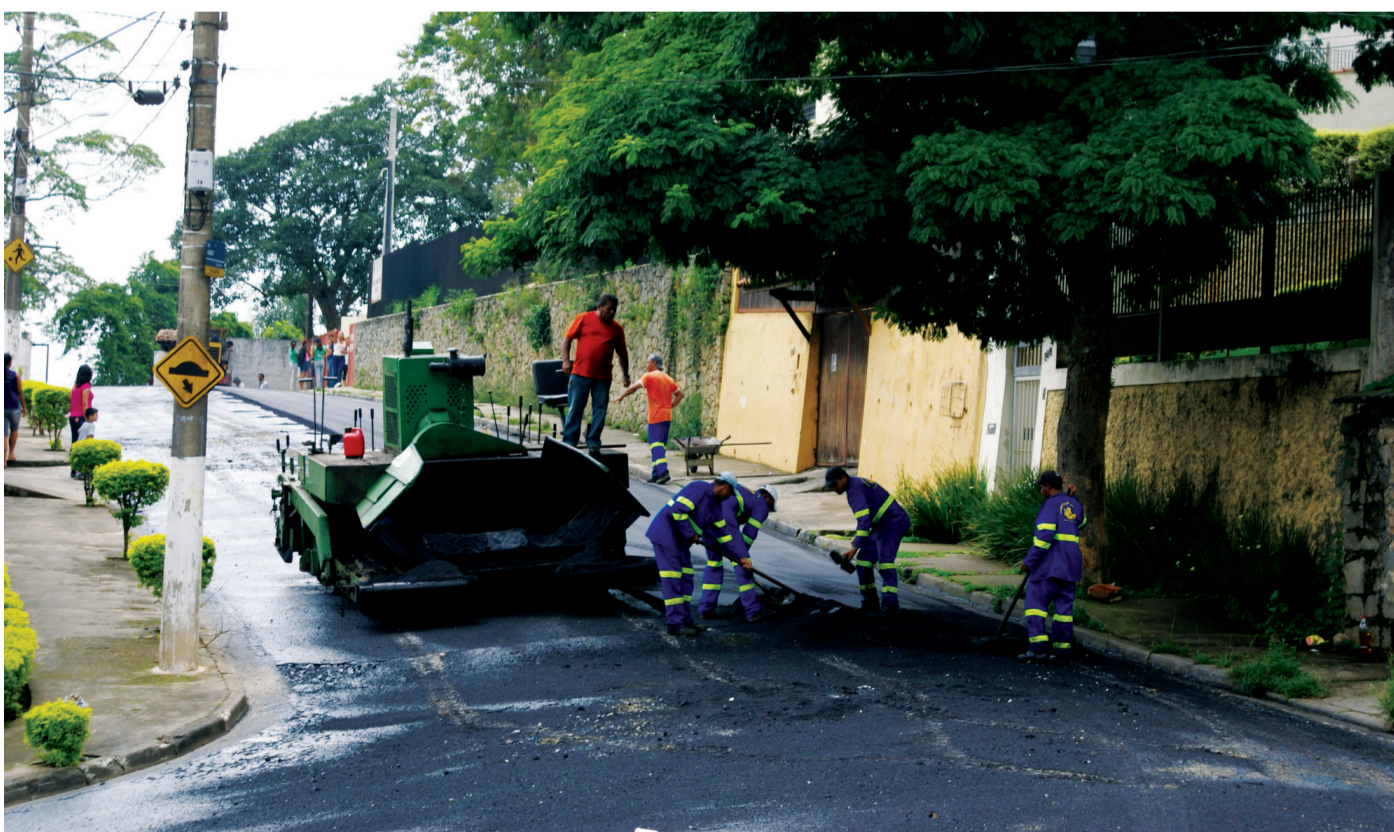
Ruas do bairro receberam completo recapeamento
