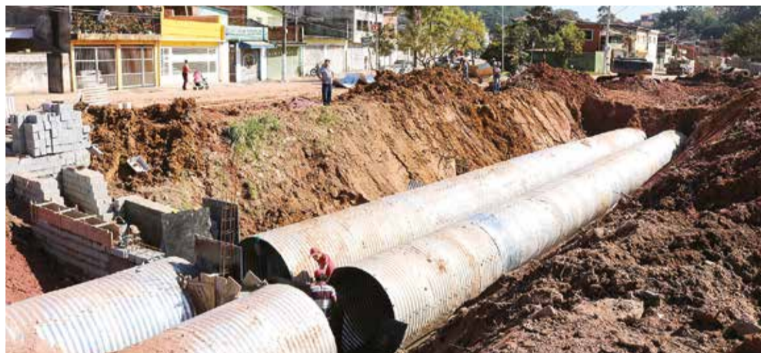
Importante obra de canalização no bairro do Parque Paraíso entra na etapa final
