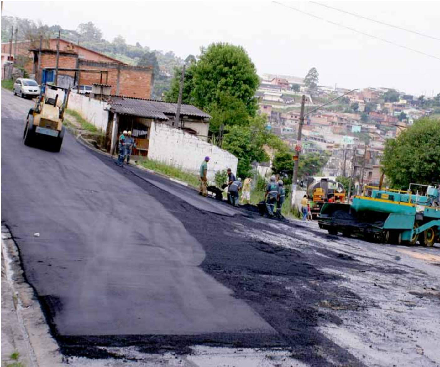
Ruas do Parque Paraíso recebem nova camada de asfalto nas obras de recapeamento da Prefeitura
