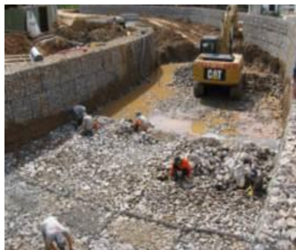
Figura 7. Obras de canalização do Rio Cachoeira.
