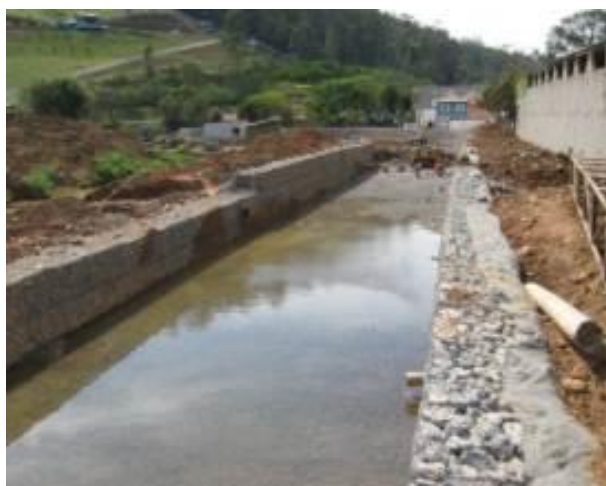
Figura 6. Obras de canalização do Rio Cachoeira.
