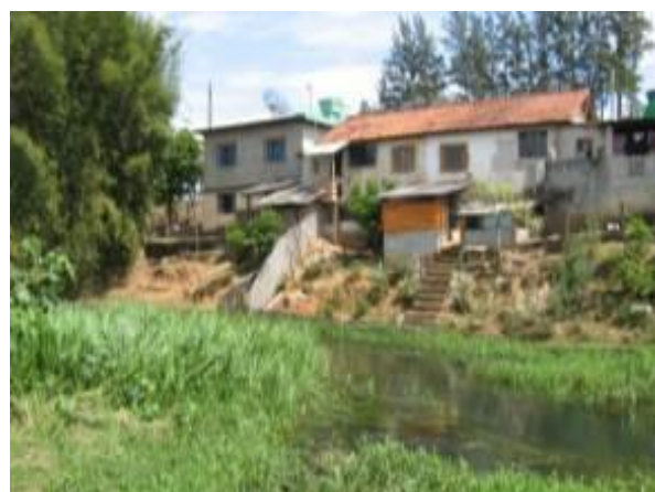
Figura 9. Edificações localizadas às margens do Rio Cachoeira.
