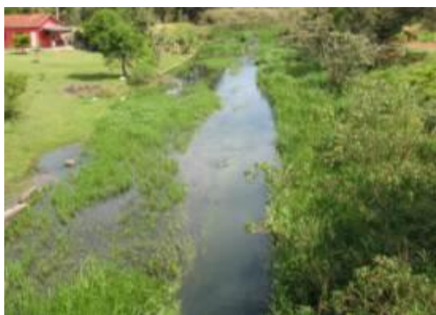
Figura 8. Indícios de assoreamento, comprometendo a calha normal do rio.
