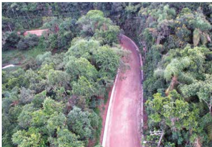
Trabalho estrutural envolveu colocação de tubos, motonivelamento e cascalhamento
