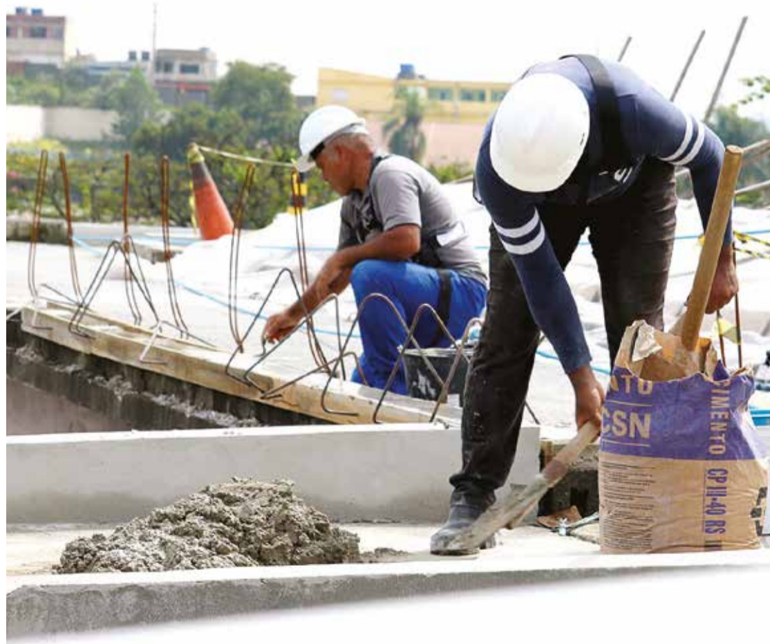
Equipe trabalha na preparação do alambrado de proteção
