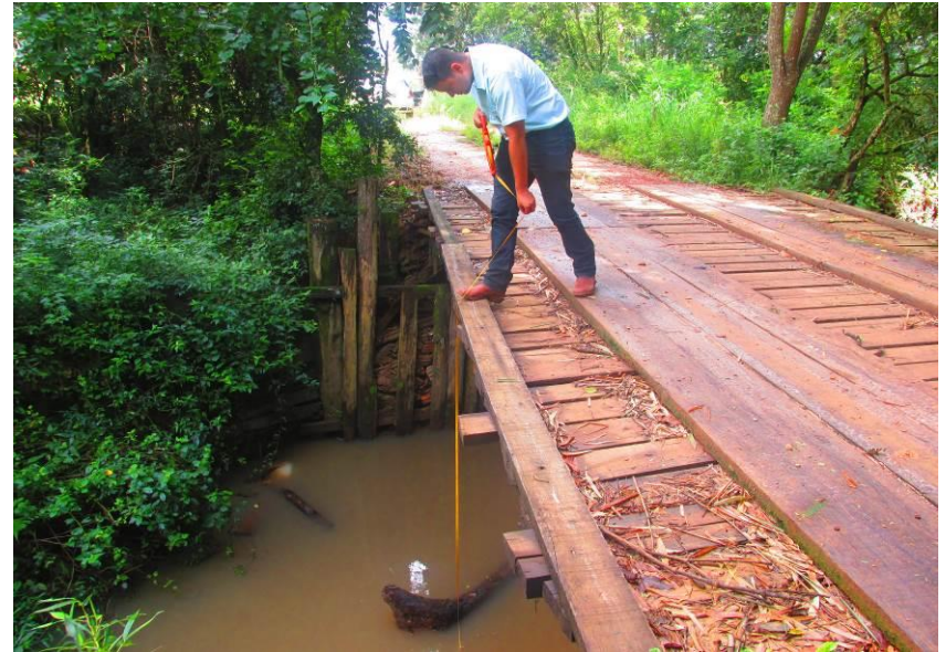
Figuras 55 e 56 – Ponte de madeira, mata ciliar bem vegetada. dimensões 9,10m de comprimento x 4,00 de largura x 3,00m altura.
