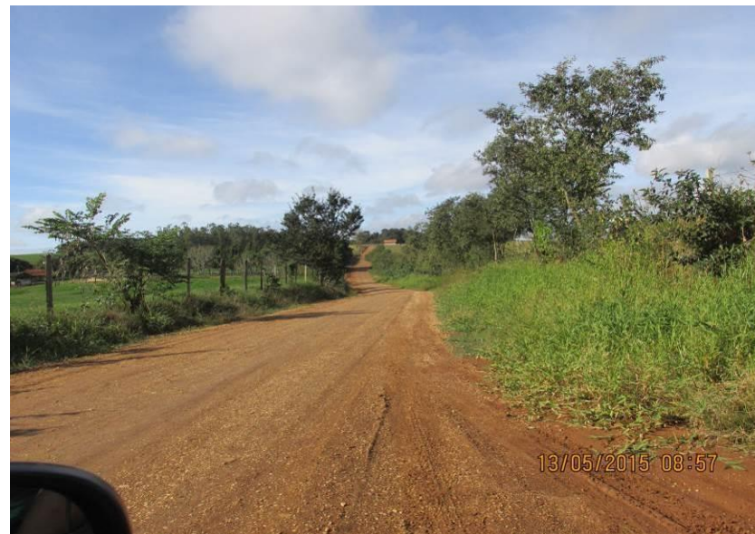
Figuras 180 e 181– Trecho encaixado entre barrancos e ausência de sistema de drenagem.
