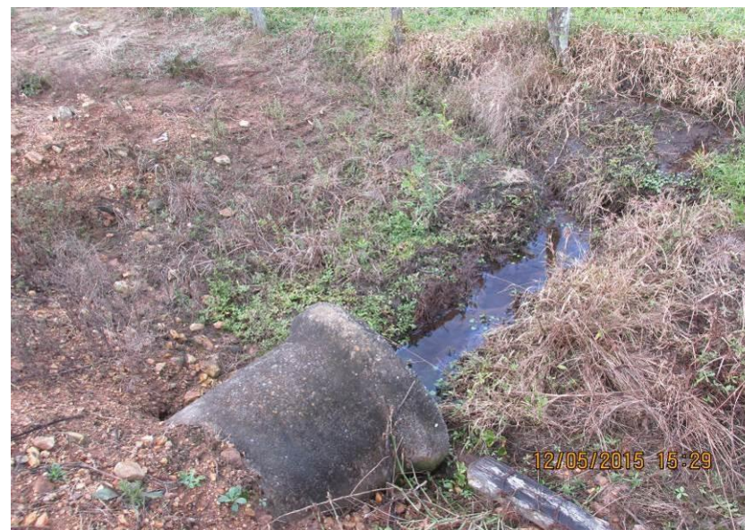
Figuras 151 e 152– Tubulação de concreto com diâmetro de 800mm e tubulação de concreto com diâmetro de 600mm.
