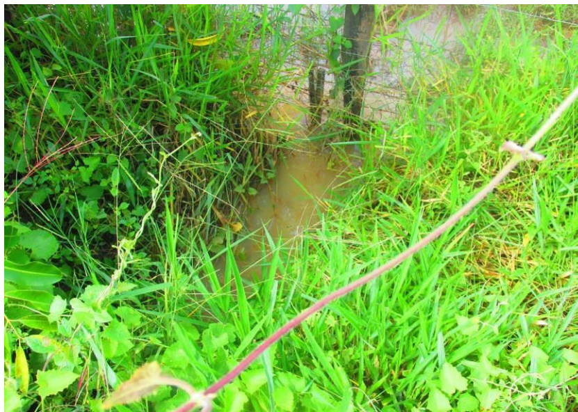
Figura 97 – Tubulação de afogada de concreto de 600mm.
