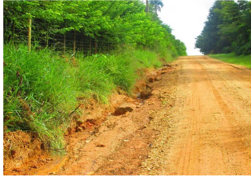
Figuras 77 e 78 – Início da estrada e processo erosivo na lateral da estrada.
