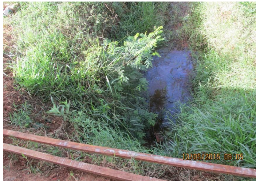
Figura 191 – Tubulação não visível, APP vegetada com nativas isoladas.
