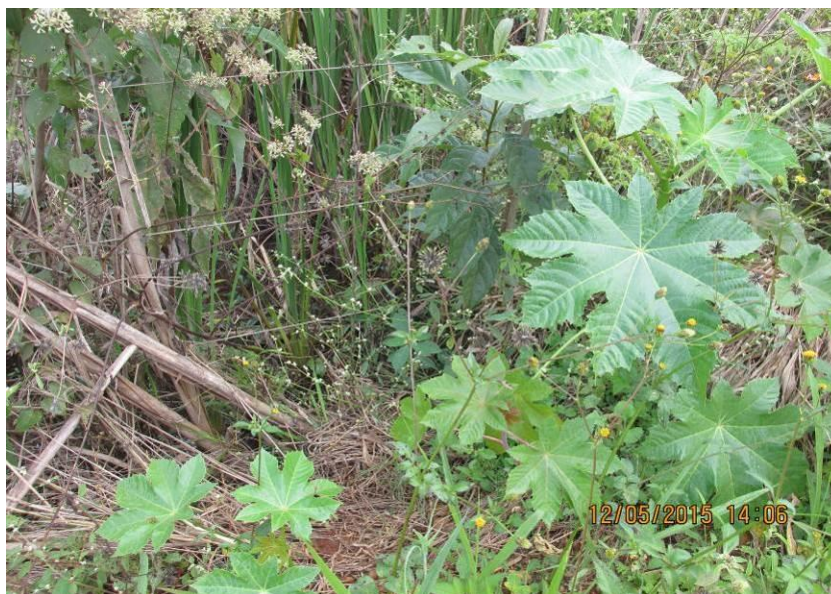
Figura 135– Tubulação completamente vegetada por gramíneas e taboas.
