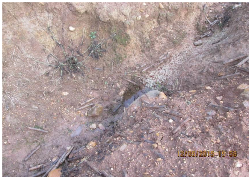
Figura 157 – Tubulação de concreto com diâmetro de 300mm, parcialmente assoreada.
