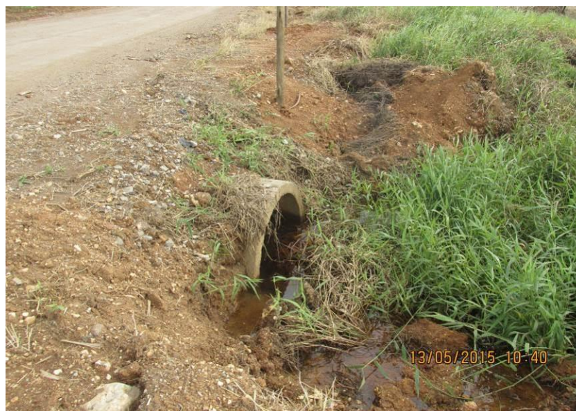
Figura 215 – Tubulação de 800mm, APP não vegetada.
