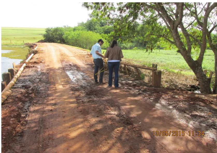
Figuras 228 e 229– Ponte de madeira sobre o Rio Pederneiras, 4,50m de comprimento, 5,20m de largura e 1,40m de altura.
