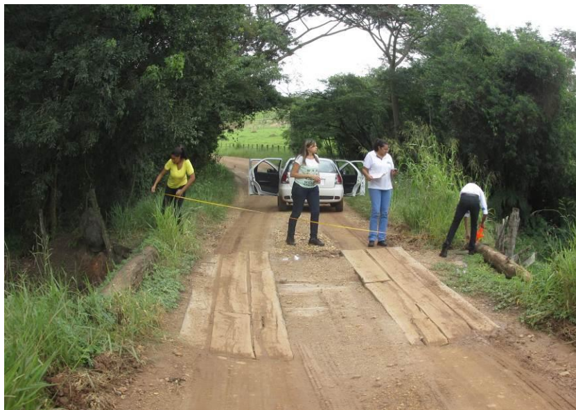
Figura 23 – Ponte de madeira. Dimensões 6,10m de comprimento x 5,20m de largura x 3,80m de altura.
