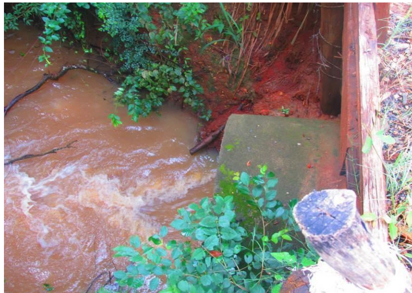
Figura 102 – Tubulação de 1500mm de concreto..
