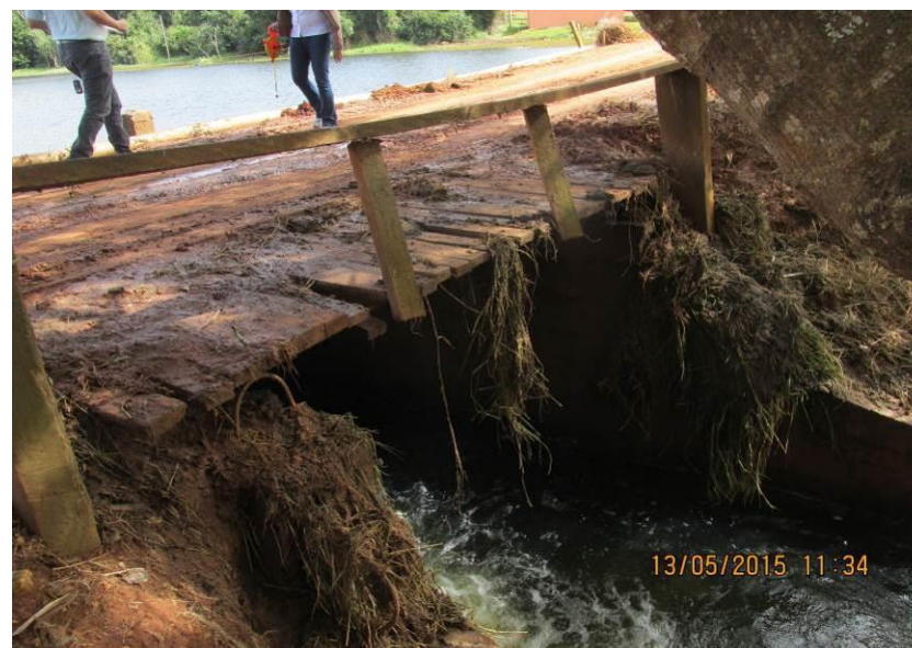
Figuras 228 e 229– Ponte de madeira sobre o Rio Pederneiras, 4,50m de comprimento, 5,20m de largura e 1,40m de altura.
