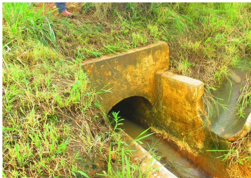
Figura 96 – Tubulação de concreto de 800mm.
