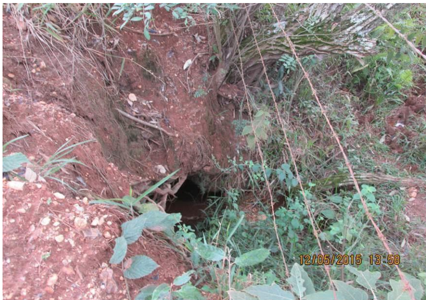
Figuras 133 e 134 – Tubulação parcialmente assoreada e tubulação de concreto de 400mm.
