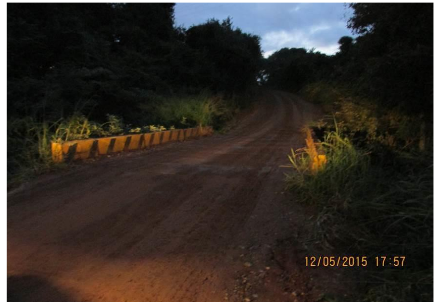
Figuras 175 e 176– Ponte de madeira com 8,10m de comprimento x 4,20 de largura x 3,80 de altura.
