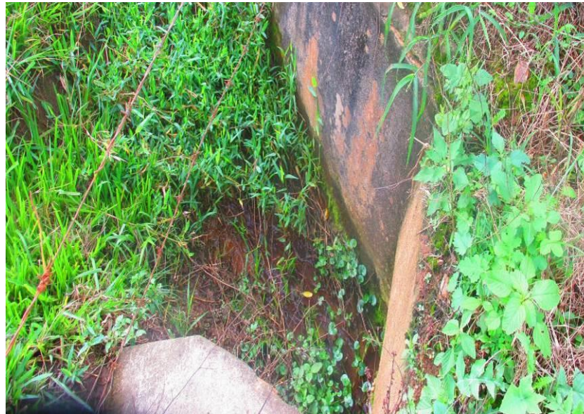
Figura 44 – Tubulação de concreto de 600mm, APP composta por pastagem.
