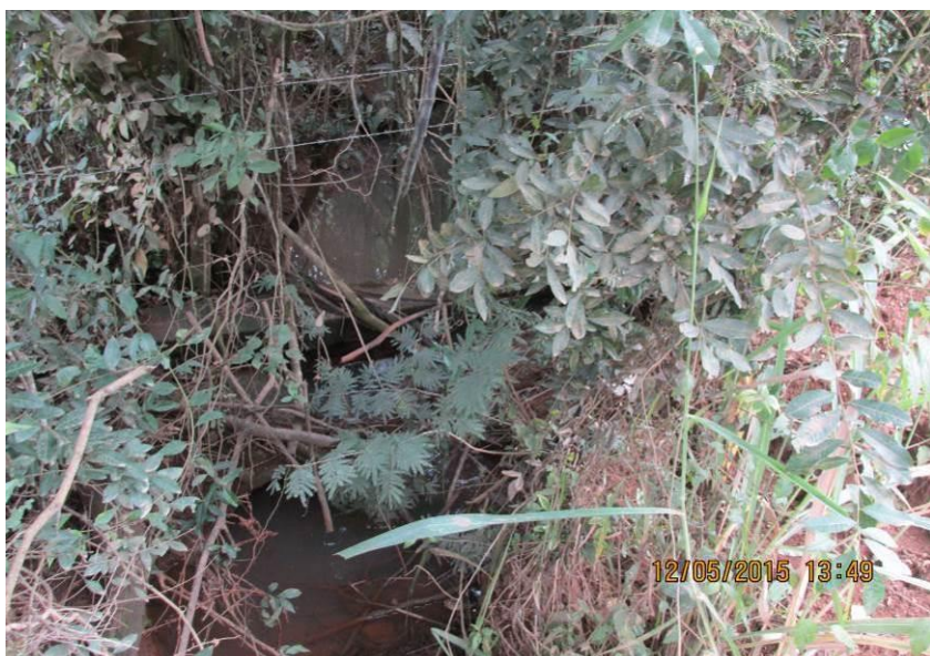
Figuras 131 e 132– Tubulação de concreto de 800mm e tubulação totalmente assoreado.
