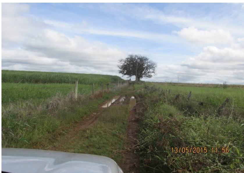
Figuras 233 e 234– Atoleiro, trecho com gramíneas no leito carroçável e ponte de madeira com 3,80 de comprimento x 4,70 de largura e 1,30 de altura.
