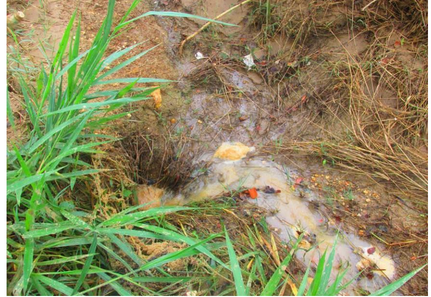
Figuras 86 e 87 – Estrada em seus aspectos gerais e tubulação assoreada.
