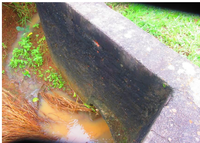
Figura 93 – Tubulação de concreto.
