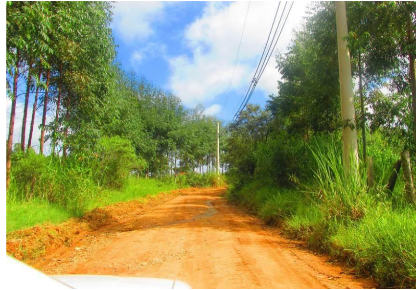
Figuras 100 e 101 – Processos erosivos na lateral da estrada e passagem d'água sobre o leito.
