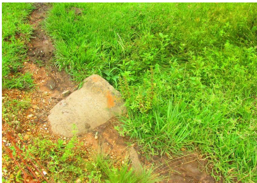
Figura 109 – Tubulação de concreto de 600mm.
