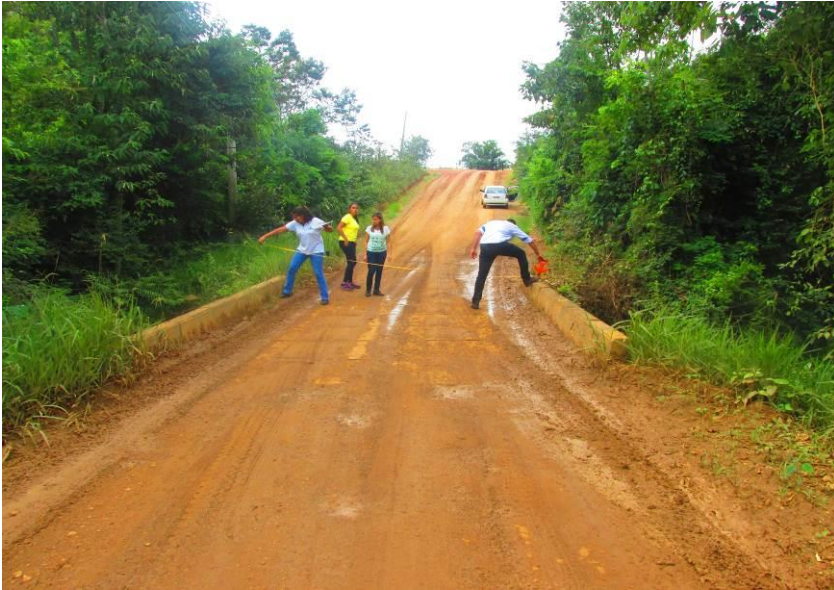
Figura 34 e 35– Ponte de concreto padrão Codasp, 6,60m de comprimento x 4,20m de largura x 5,00m de altura e tubulação não visível.
