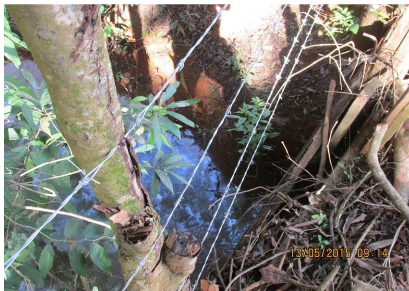
Figura 184 - Tubulação de concreto de 800mm com presença de mata ciliar.
