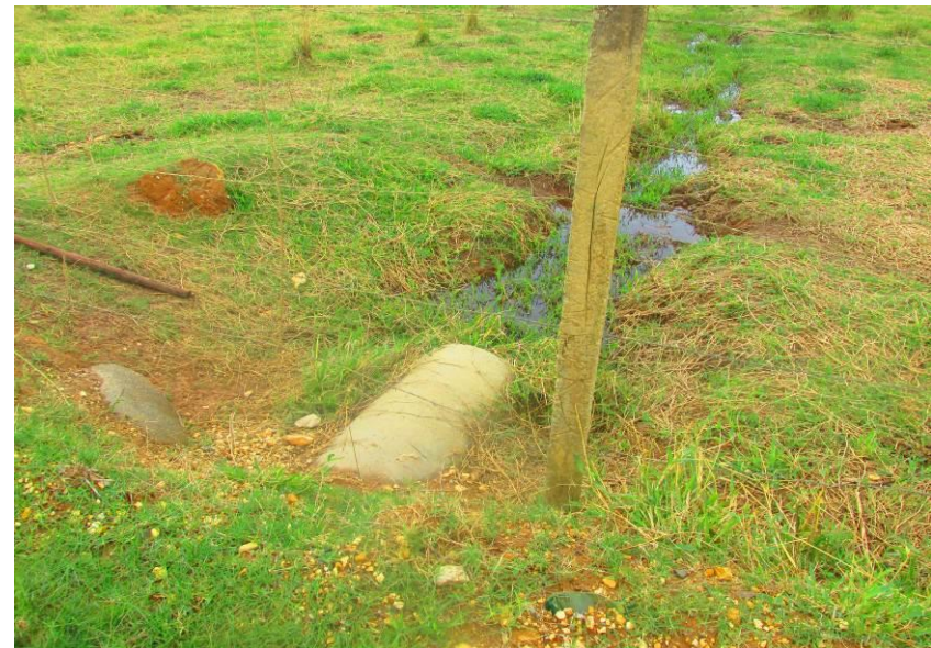
Figura 36 e 37– 2 Tubulações de concreto de 600 mm, parcialmente assoreada.
