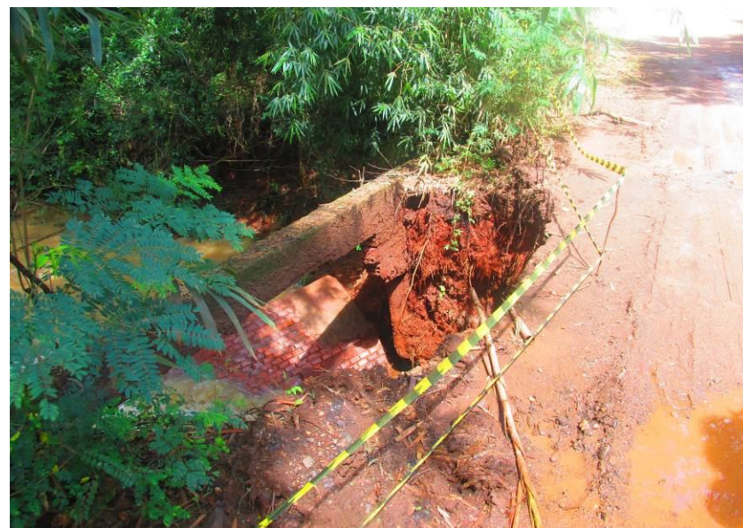
Figuras 98 e 99 – Tubulação de 1000mm de concreto, comprometida pois não atende a vazão.
