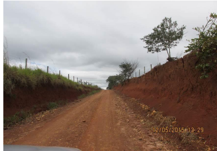
Figuras 121 e 122 – Erosão na lateral da estrada e trecho encaixado entre barrancos.
