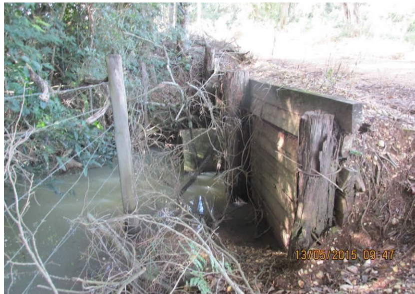
Figura 204– Tubulação de concreto de 800mm.
