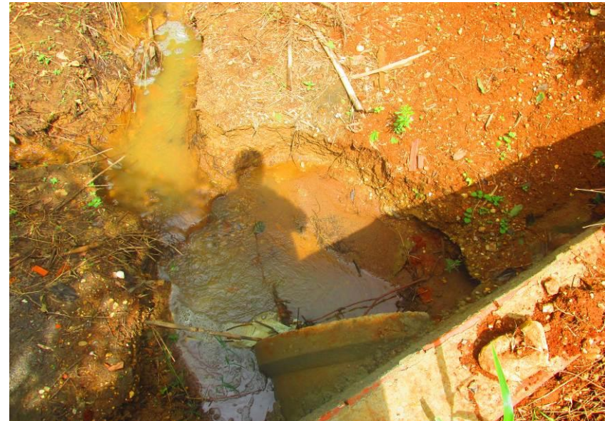
Figuras 59 e 60 – Tubulação de concreto de 600mm e tubo de concreto de 800mm..
