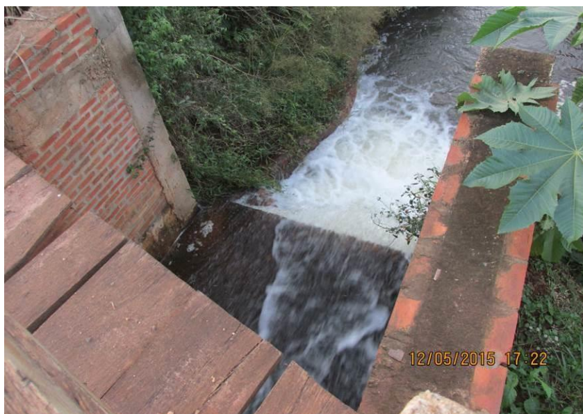
Figuras 167 e 168– Extravasor do barramento.
