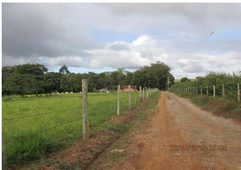
Figuras 147 e 148- Trecho da estrada sem sistema de drenagem e tubulação de concreto com diâmetro de 1500mm.
