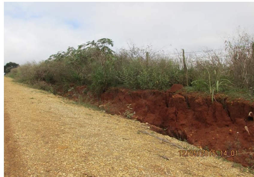
Figuras 123 e 124 – Trecho sem revestimento e erosão na lateral da estrada.
