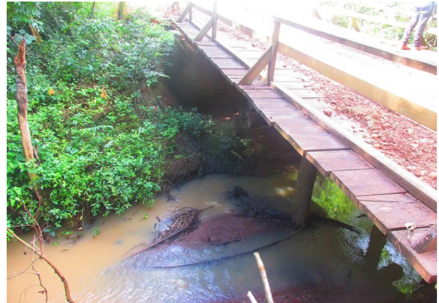
Figuras 51 e 52 – Ponte de madeira com 11,40m comprimento x 5,00m de largura x 3,20m de altura.
