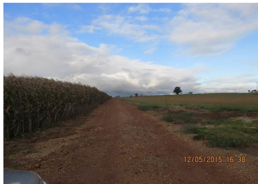
Figuras 161 e 162 – Trechos da estrada sem sistema de drenagem.
