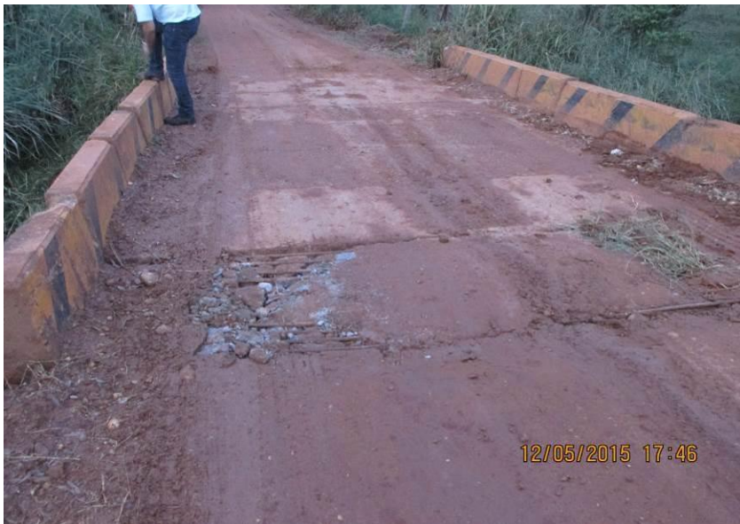
Figuras 175 e 176– Ponte de madeira com 8,10m de comprimento x 4,20 de largura x 3,80 de altura.
