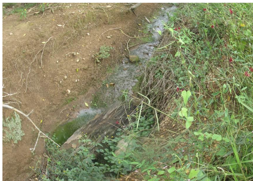
Figura 28 – Tubulação de concreto 600m.
