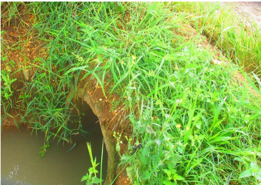
Figuras 47 e 48 - Tubulação de concreto de 600mme tubo de 300mm
