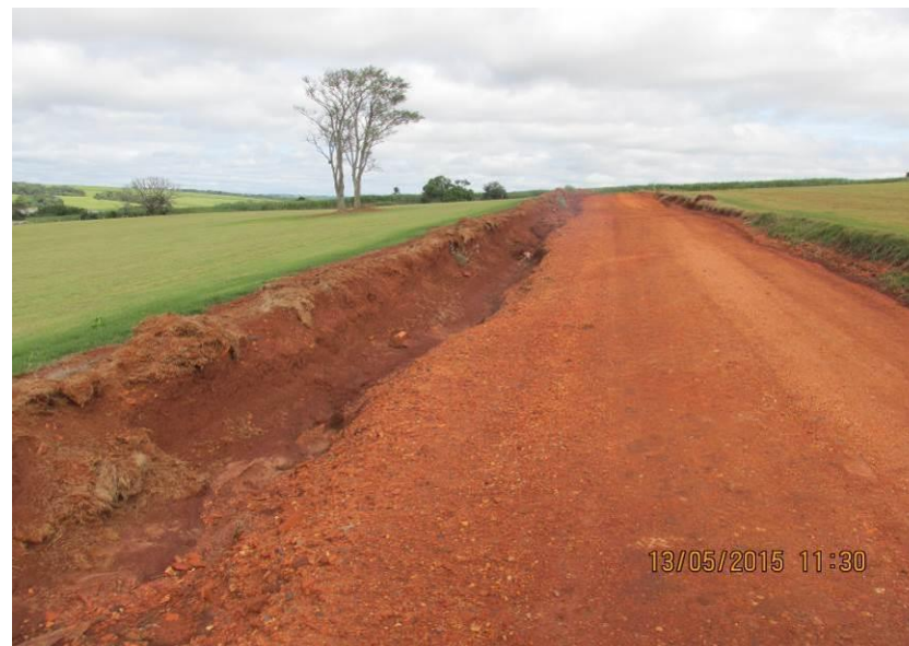
Figuras 226 e 227– Início da estrada e processo erosivo na lateral da estrada.
