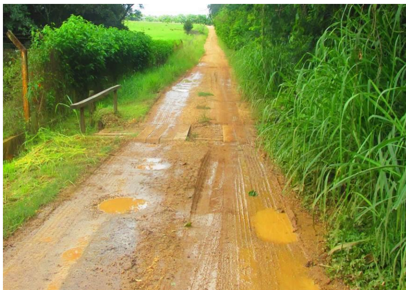
Figura 82 - Ponte de madeira a jusante com nativas isoladas e barramento a montante. Dimensões 2,80m de comprimento x 4,90m de largura x 1,30m de altura.
