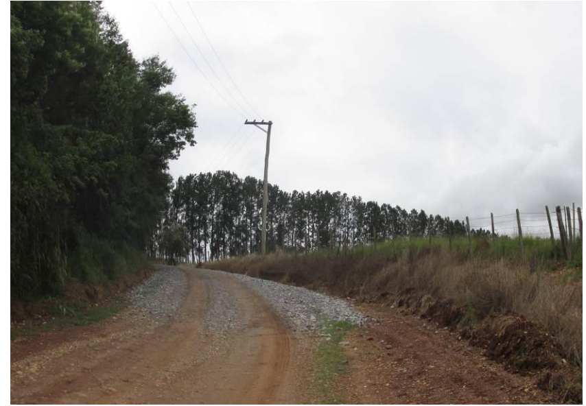
Figuras 15 e 16 – Trecho encaixado e revestimento parcial na extensão da estrada.
