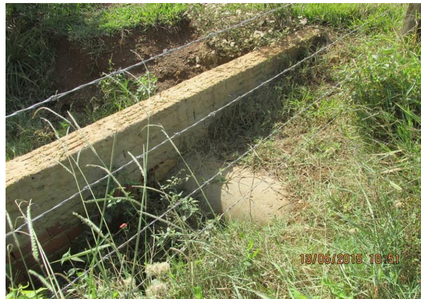
Figuras 216 e 217– Tubulação afogada, e tubulação de 600mm.
