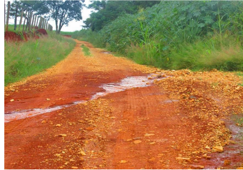
Figuras 117 e 118 – Início da estrada e trecho com passagem d'água sobre o leito carroçável
