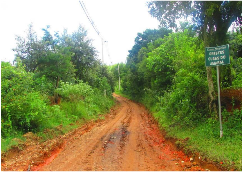
Figuras 100 e 101 – Processos erosivos na lateral da estrada e passagem d'água sobre o leito.
