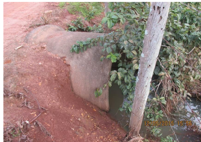
Figuras 155 e 156– Tubulação de concreto com diâmetro de 600 mm e tubulação de concreto com diâmetro de 1500mm.
