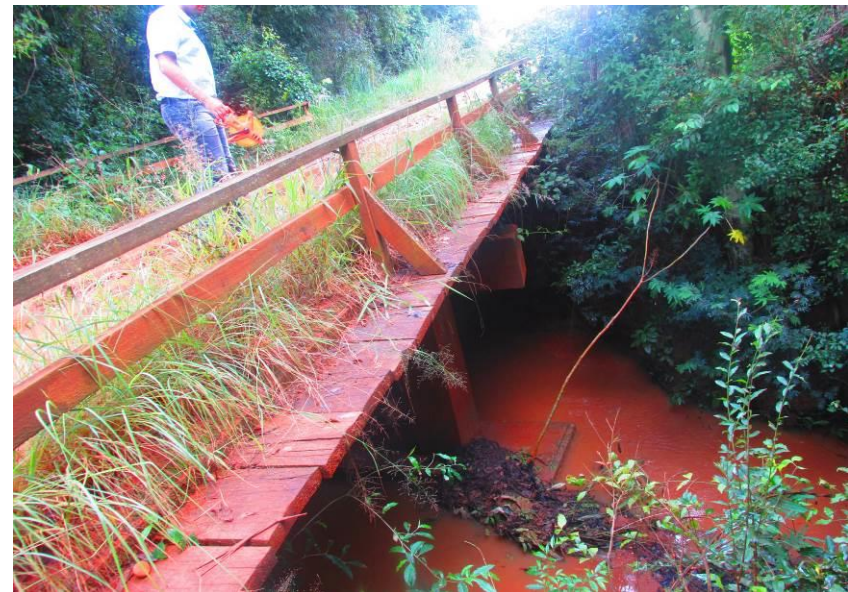
Figuras 119 e 120 – Ponte de madeira. Dimensões 12,20m de comprimento x 4,80m de largura x 3,30m de altura.
