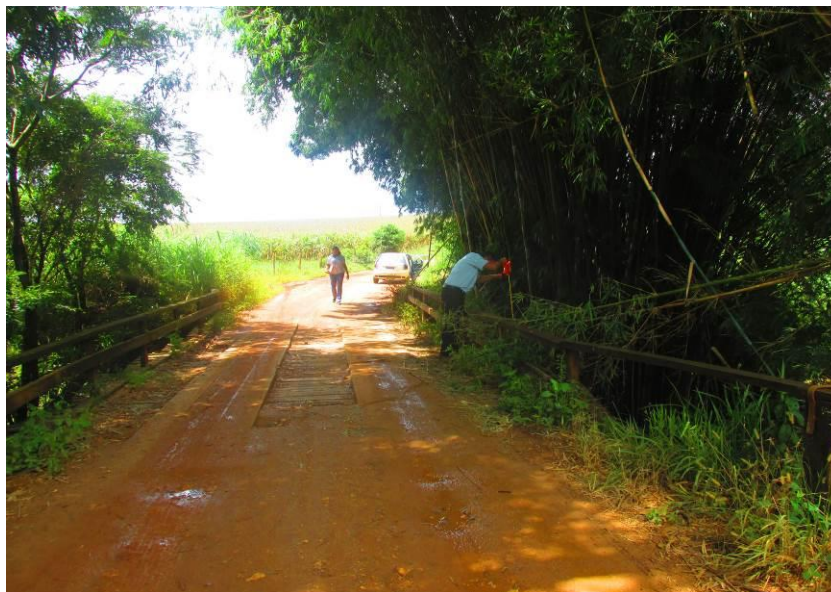
Figura 75 – Ponte de madeira. Dimensões 12,00m de comprimento x 4,80m de largura x 4,90m de altura.
