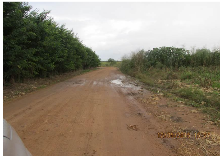
Figuras 149 e 150– Trecho sem saída d'água acarretando em formação de atoleiro na estrada.
