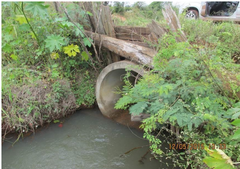
Figuras 127 e 128 – Tubulação de 1500mm e ponte com dimensões de 12, 40 de comprimento, 4,40 de largura e de profundidade.
