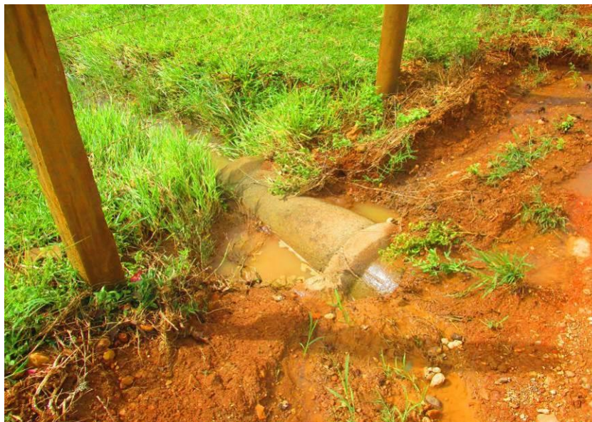
Figura 81 – Tubulação de concreto de 300mm.
