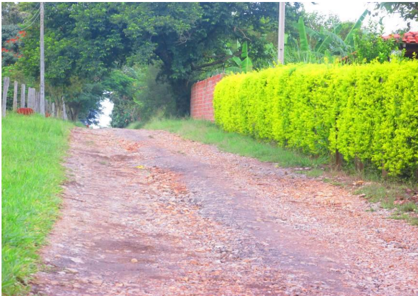
Figuras 65 e 66– Estrada com revestimento de cascalho.
