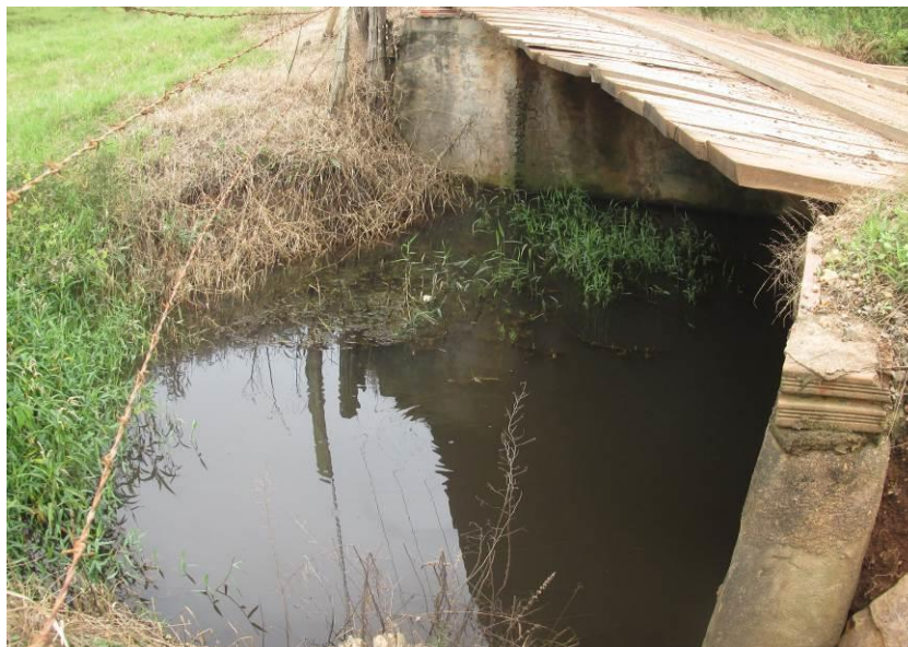
Figura 19 e 20 – Ponte de madeira, dimensões 7,10 comprimento x 4,90 m de largura. x 3,10m altura.
