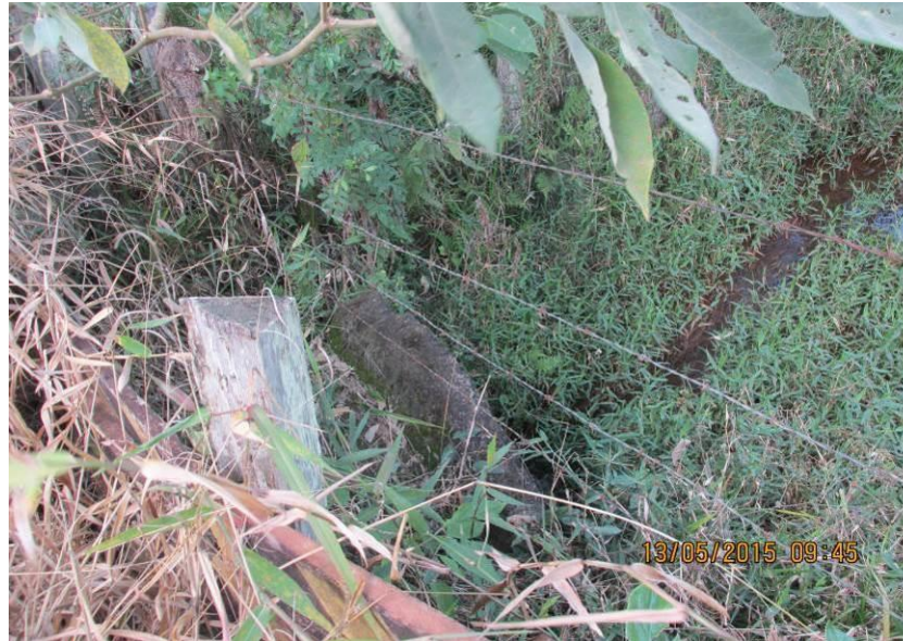
Figura 203– Tubulação de concreto de 1000mm.
