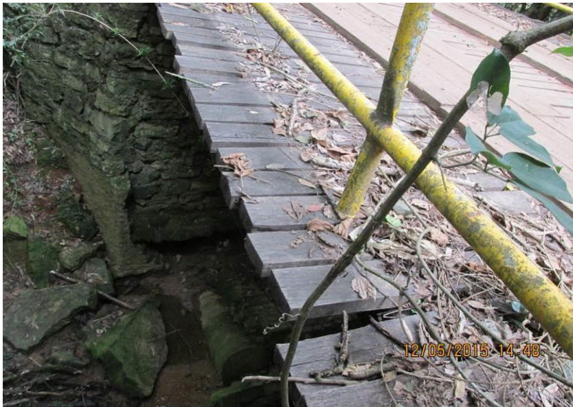
Figuras 143 e 144– Ponte de madeira com dimensões de: 8,50m de comprimento, 5,10m de largura e 4m de altura e ponte padrão defesa civil com dimensões de: 8,20m de comprimento, 4,20m de largura e 3,2m de altura.
