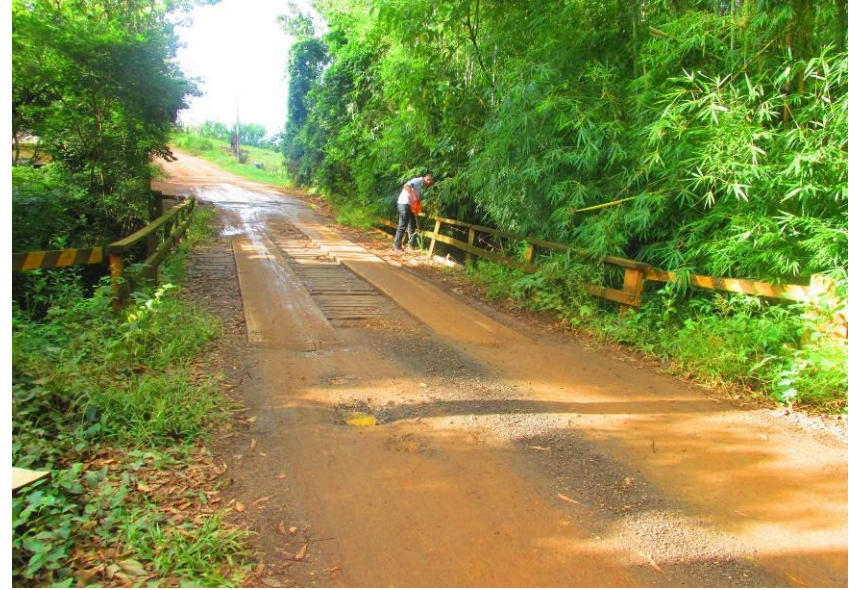
Figuras 38 e 39– Estrada em seus aspectos gerais e ponte de madeira, dimensões 15,10m comprimento x 4,60m de largura x 4,90m de altura. Mata ciliar bem vegetada.
