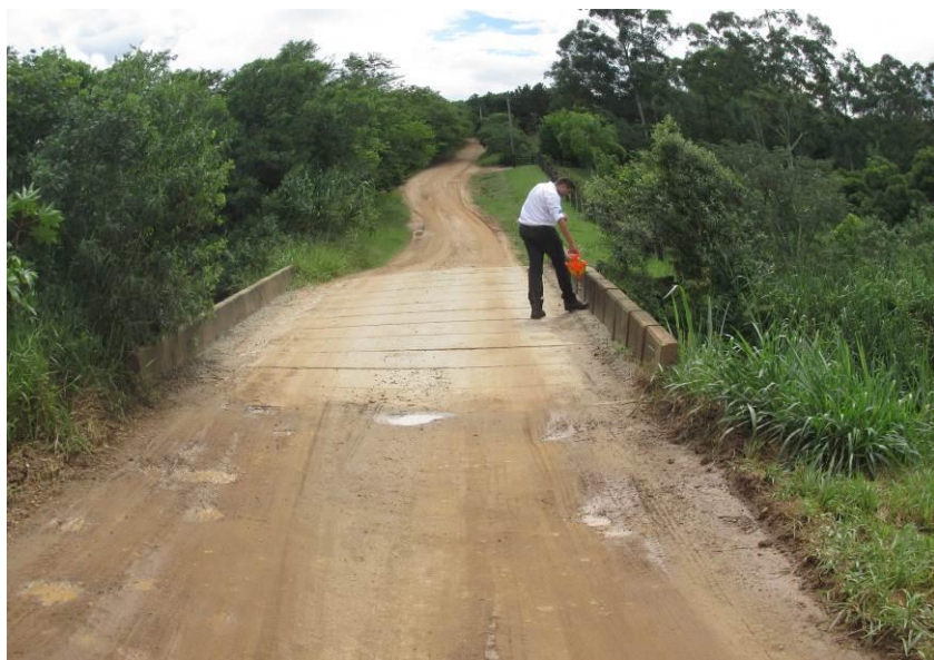
Figuras 21 e 22 – Ponte de concreto com 12,00m de comprimento x 4,20m de largura x 4,90m de altura.
