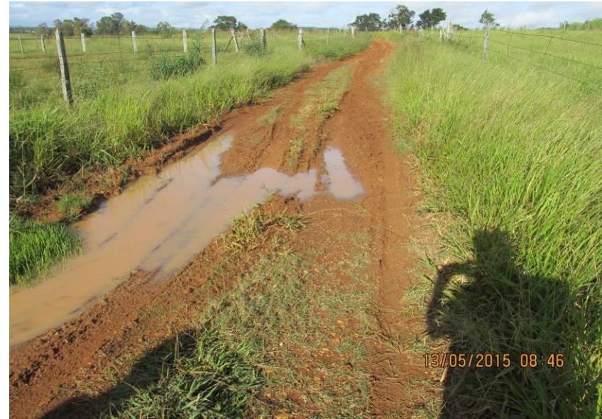
Figuras 185 e 186 – Erosão na lateral da estrada e trecho com atoleiro.
