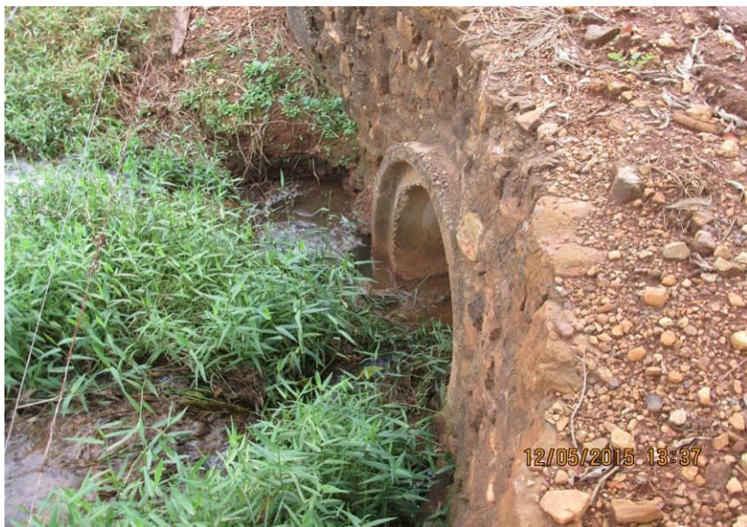
Figuras 129 e 130– Tubulação de concreto de 1000mm e tubulação não identificada por apresentar cobertura por gramíneas.
