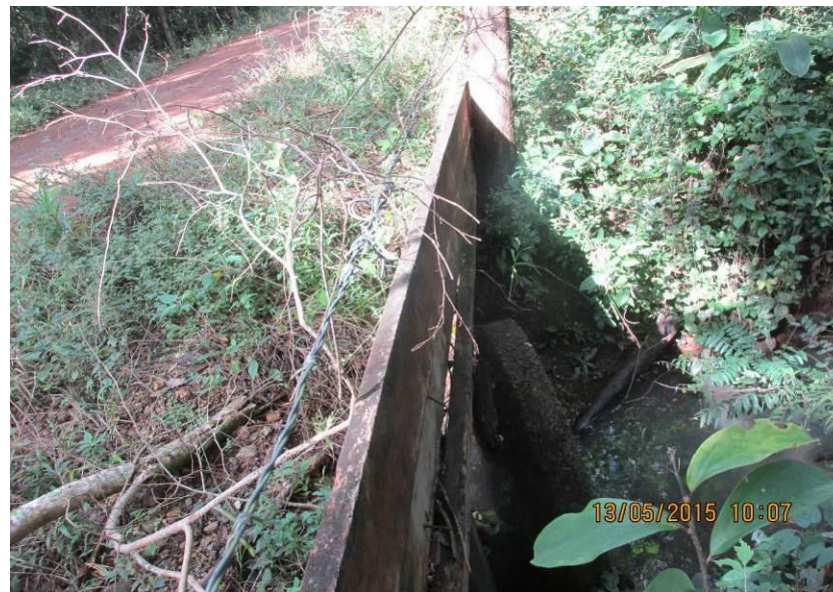
Figura 199 - Tubulação de concreto de 1000mm..
