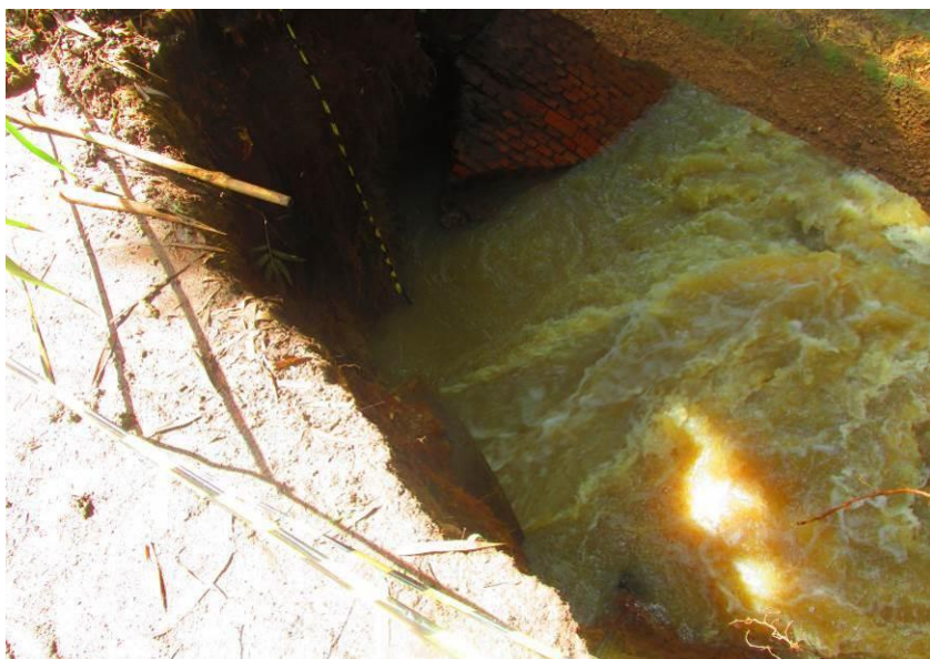
Figuras 98 e 99 – Tubulação de 1000mm de concreto, comprometida pois não atende a vazão.
