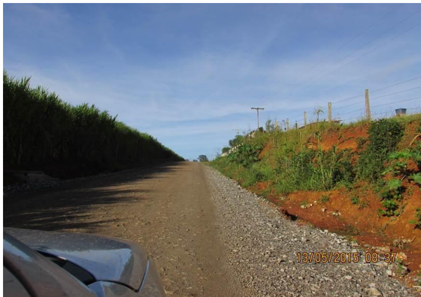
Figuras 180 e 181– Trecho encaixado entre barrancos e ausência de sistema de drenagem.
