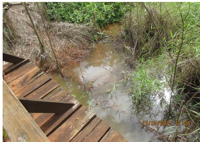
Figuras 233 e 234– Atoleiro, trecho com gramíneas no leito carroçável e ponte de madeira com 3,80 de comprimento x 4,70 de largura e 1,30 de altura.
