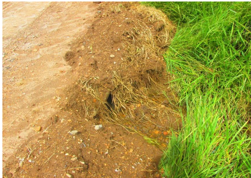
Figura 54 – Tubulação de concreto de 600mm.
