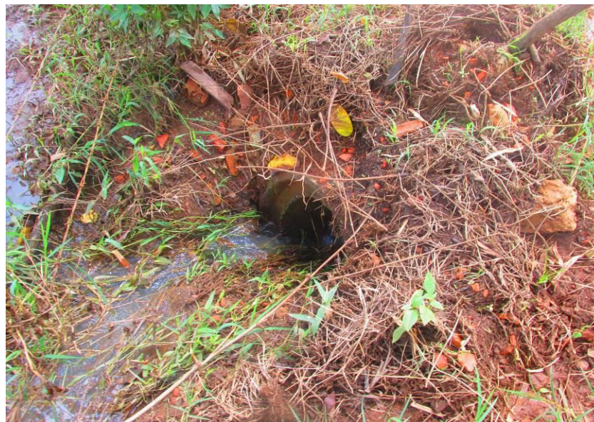
Figura 116 – Tubulação de concreto de 400mm.
