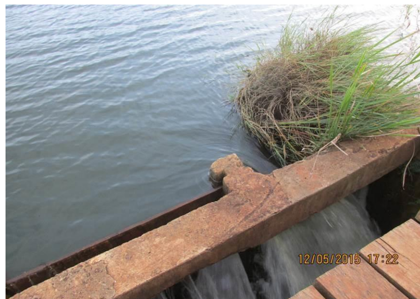
Figuras 167 e 168– Extravasor do barramento.
