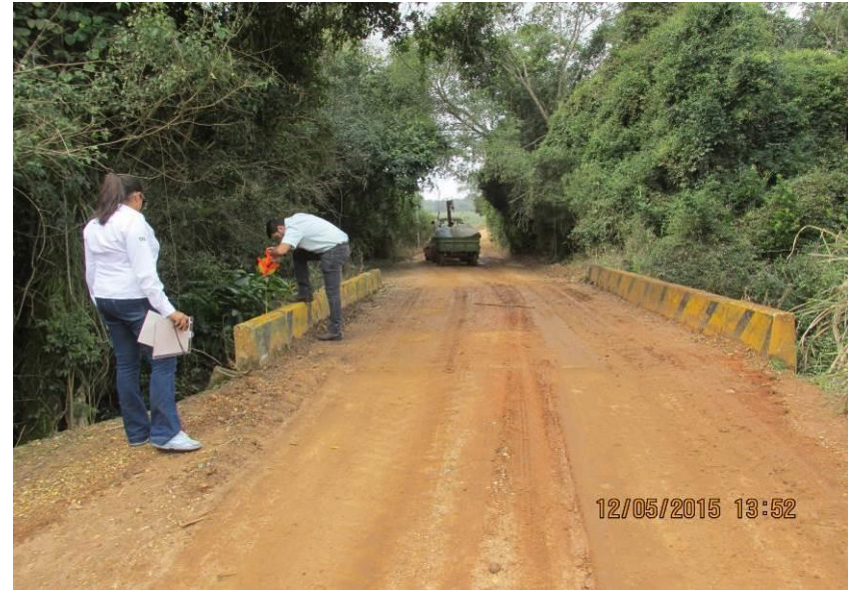
Figuras 125 e 126 – Ponte com dimensões de: Comprimento de 9,60m, largura de 4,90, altura de 3,30 e ponte com comprimento de 7,90m, largura de 4,20, altura de 3,50.
