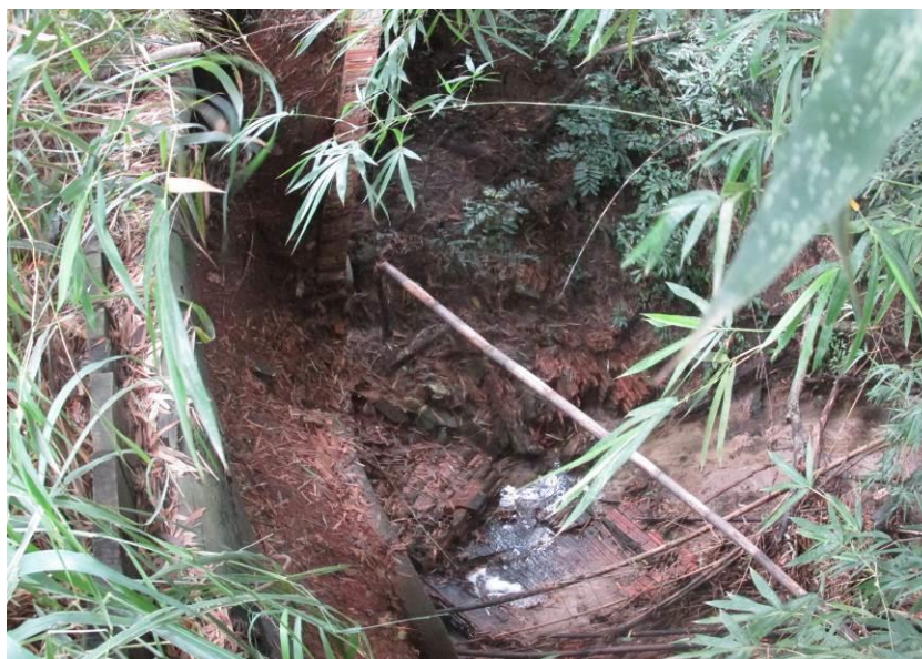
Figura 24 – Tubulação de concreto de 1500 mm, APP com nativas e bambu.24
