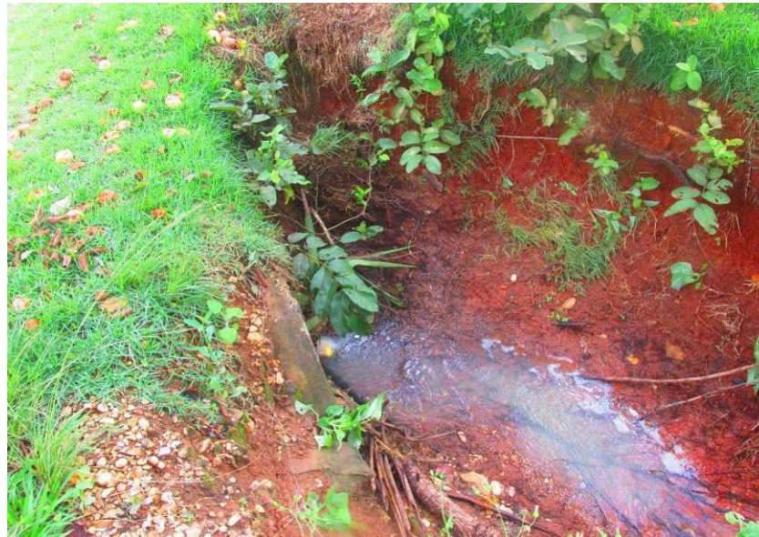
Figura 90 – Tubulação de concreto de 800mm
