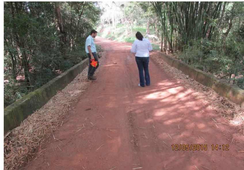
Figuras 127 e 128 – Tubulação de 1500mm e ponte com dimensões de 12, 40 de comprimento, 4,40 de largura e de profundidade.
