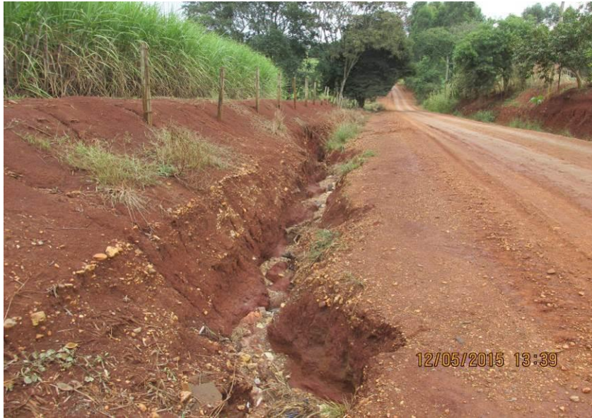
Figuras 121 e 122 – Erosão na lateral da estrada e trecho encaixado entre barrancos.
