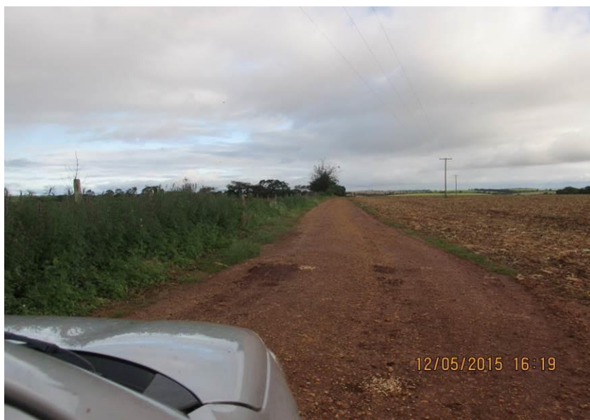
Figuras 161 e 162 – Trechos da estrada sem sistema de drenagem.
