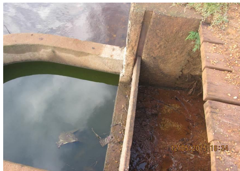
Figuras 163 e 164– Barramento na lateral e tubulação servindo com extravasor do barramento.
