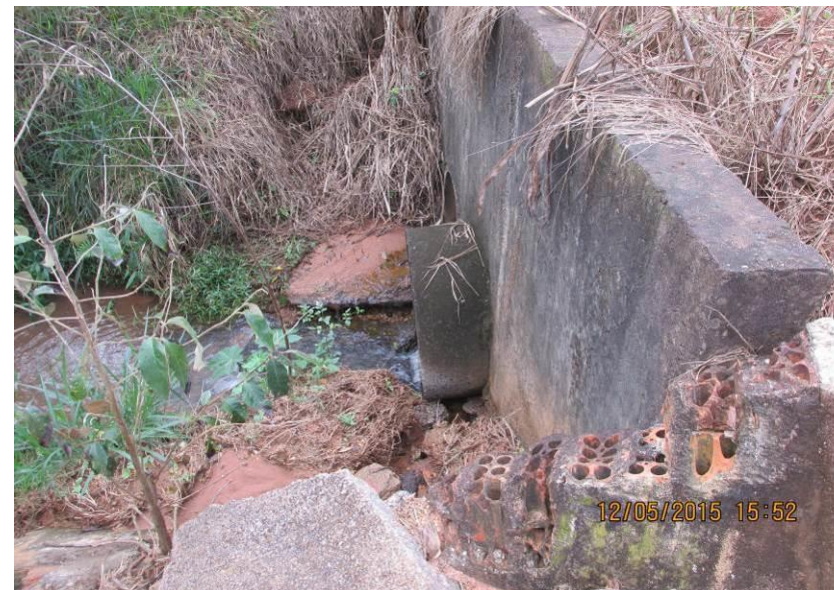
Figuras 153 e 154– Tubulação de concreto de 600mm com a ala de saia solapada e tubulação de concreto de 400mm.
