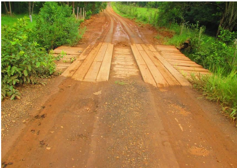
Figura 17 e 18 - Ponte de madeira com 10,00m comprimento x 4,00m largura x 2,70m altura.
