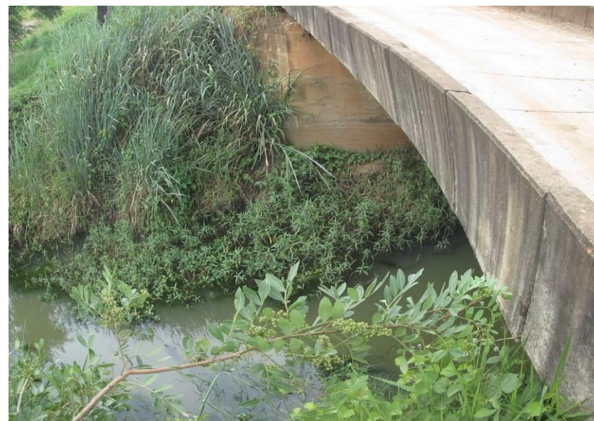
Figuras 21 e 22 – Ponte de concreto com 12,00m de comprimento x 4,20m de largura x 4,90m de altura.
