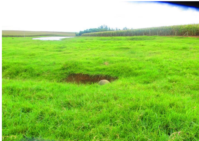
Figura 61 – Tubulação de concreto de 600mm..
