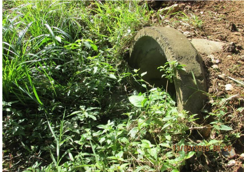
Figura 196 – Tubulação de 800mm.
