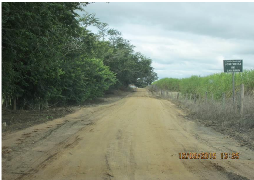
Figuras 123 e 124 – Trecho sem revestimento e erosão na lateral da estrada.
