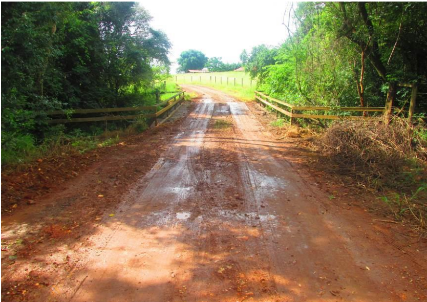
Figuras 51 e 52 – Ponte de madeira com 11,40m comprimento x 5,00m de largura x 3,20m de altura.
