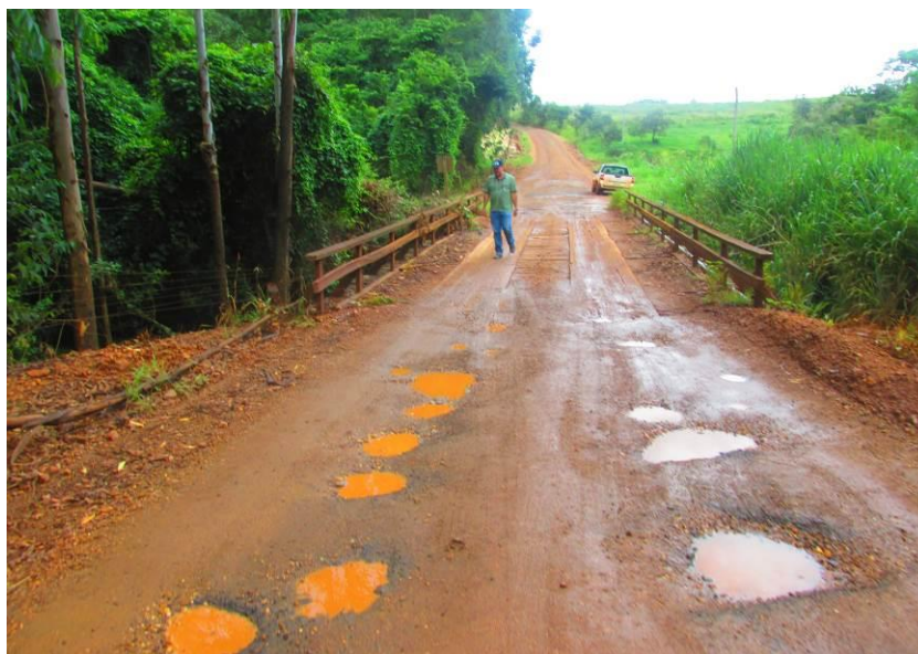
Figura 76 – Ponte de madeira com 17,00m de comprimento x 5,60 de largura x 3,30 de altura.
