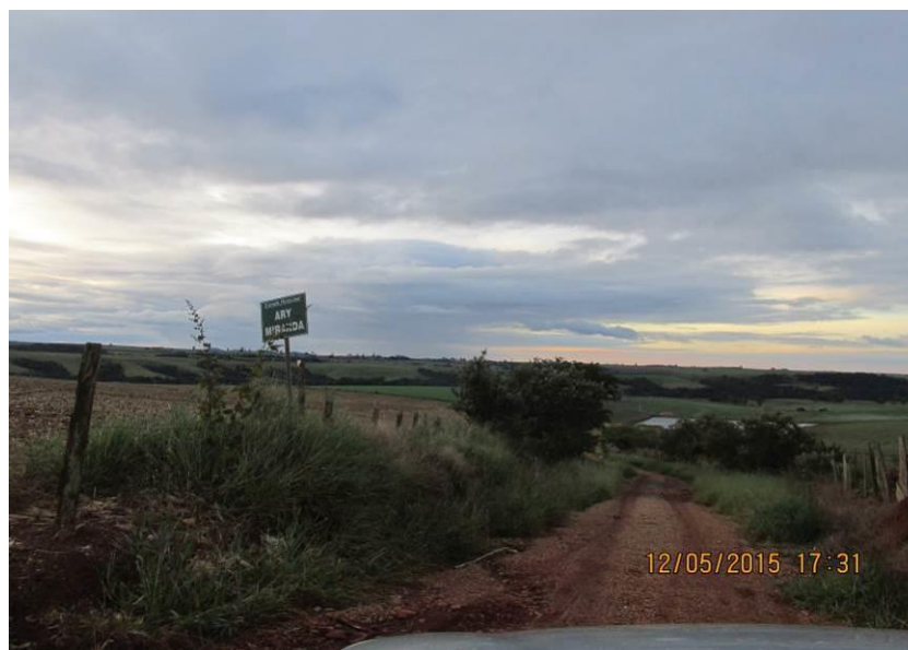
Figura 177 - Trecho da estrada em declive com ausência de sistema de drenagem.
