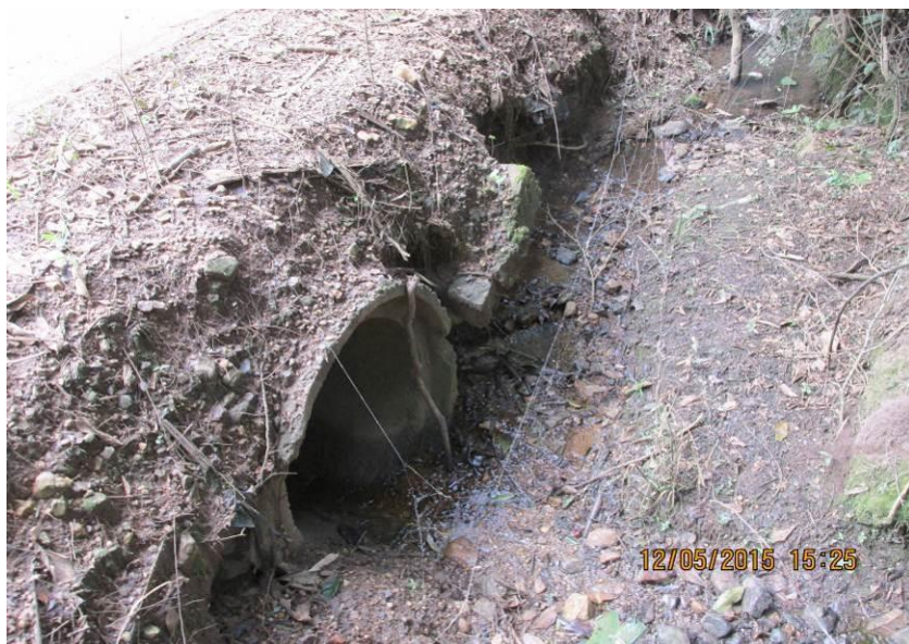
Figuras 151 e 152– Tubulação de concreto com diâmetro de 800mm e tubulação de concreto com diâmetro de 600mm.
