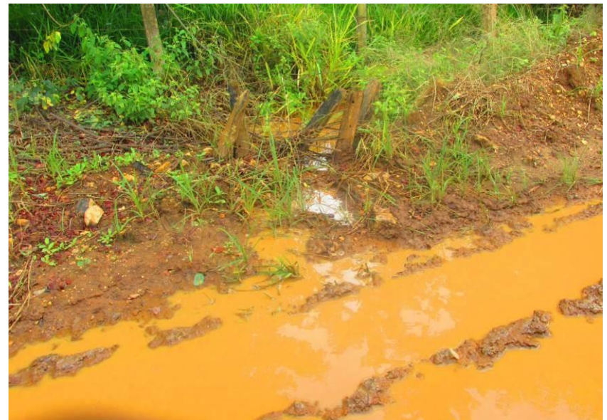
Figuras 40 e 41 – Tubulação afogada e tubulação intermitente.
