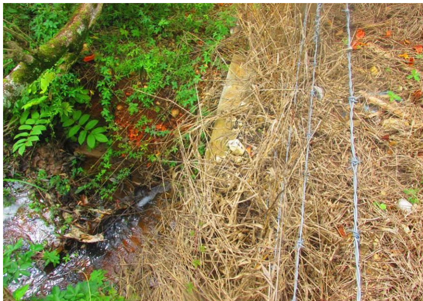
Figura 110 – Tubulação de concreto de 800mm.
