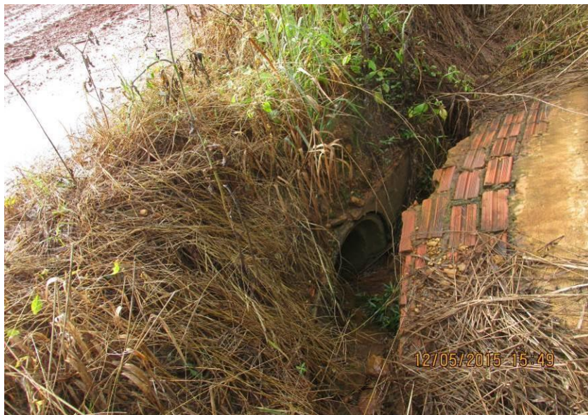
Figuras 153 e 154– Tubulação de concreto de 600mm com a ala de saia solapada e tubulação de concreto de 400mm.
