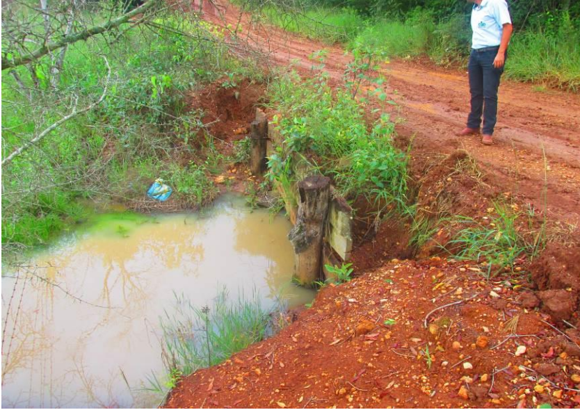
Figuras 49 e 50 - Tubulação assoreada e tubo de concreto de 400mm
