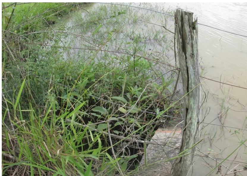
Figura 25 – Tubulação não identificada, a jusante com APP composta por nativas e gramíneas.
