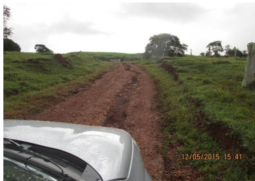
Figuras 158 e 159 – Trecho da estrada com presença de revestimento de cascalho e erosão no leito carroçável.
