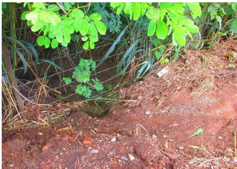
Figura 85 – Tubulação de 400mm..
