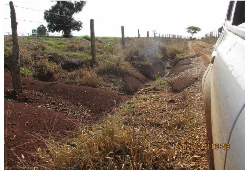
Figuras 205 e 206 - Início a estrada em aclave, processo erosivo na lateral da estrada.
