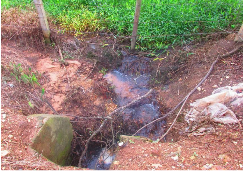
Figuras 42 e 43 – Tubulação de concreto de 600mm e tubulação assoreada.
