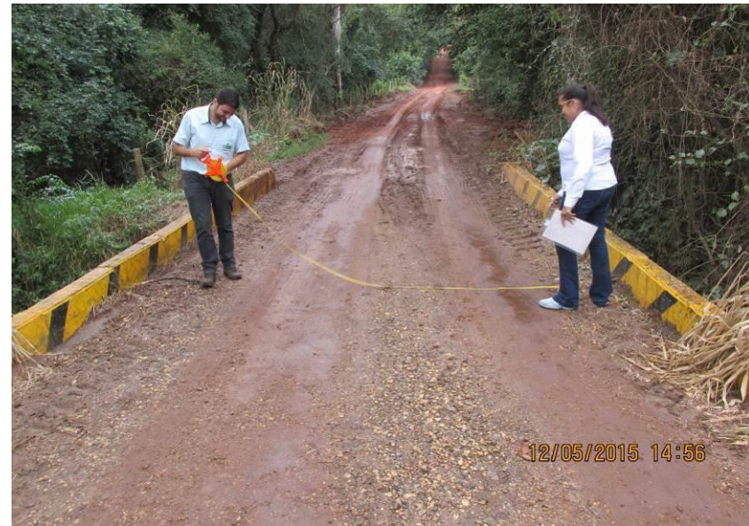
Figuras 143 e 144– Ponte de madeira com dimensões de: 8,50m de comprimento, 5,10m de largura e 4m de altura e ponte padrão defesa civil com dimensões de: 8,20m de comprimento, 4,20m de largura e 3,2m de altura.
