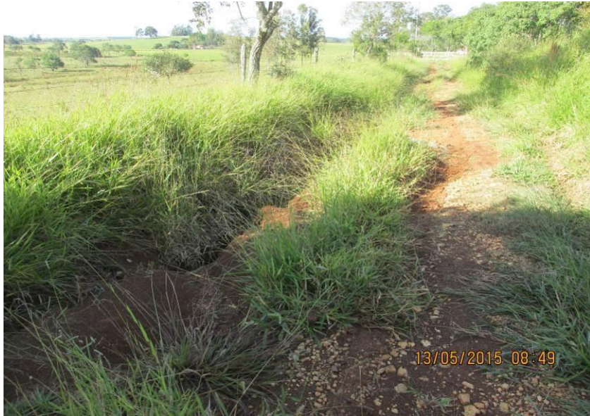
Figuras 185 e 186 – Erosão na lateral da estrada e trecho com atoleiro.
