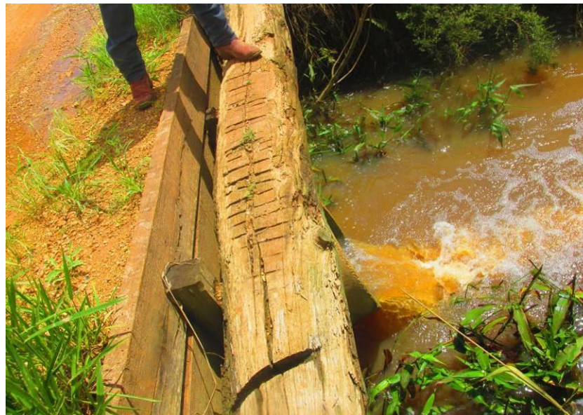
Figura 114 – Tubulação de 800mm de concreto.
