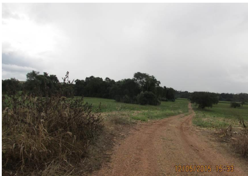
Figuras 158 e 159 – Trecho da estrada com presença de revestimento de cascalho e erosão no leito carroçável.
