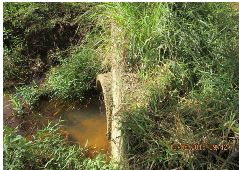
Figura 202– Tubulação de concreto de 1000mm.
