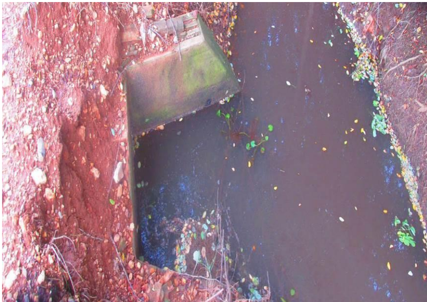
Figuras 40 e 41 – Tubulação afogada e tubulação intermitente.
