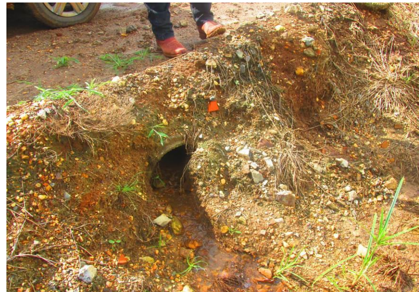
Figuras 47 e 48 - Tubulação de concreto de 600mme tubo de 300mm
