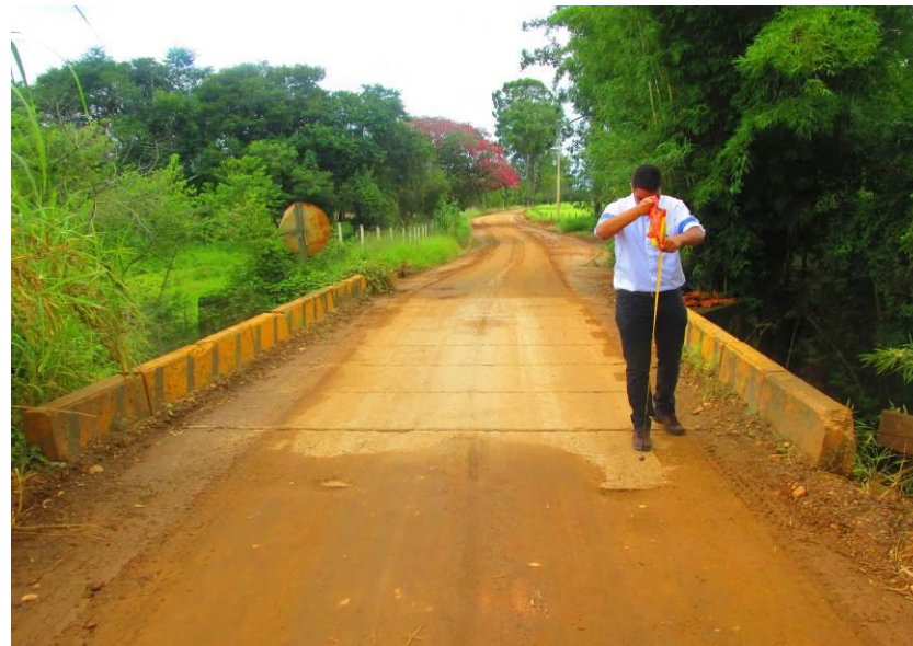
Figura 33 – Ponte de concretos com 6,00m de comprimento x 4,20m de largura e x 3,80m de altura..
