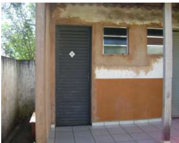
FIGURA 17: Local de acondicionamento de resíduos de saúde.
