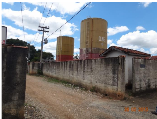
Foto 4.3 – EEAB Casa de Bombas e Reservatórios
