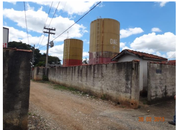
Foto 4.8 – Reservatórios Casa de Adução
