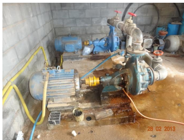
Foto 4.4 – EEAB – Conjuntos Motobomba
