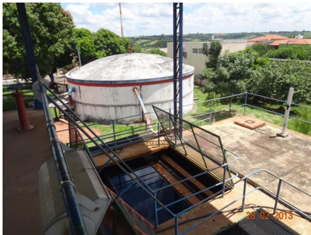
Foto 4.7 – Reservatório na ETA
