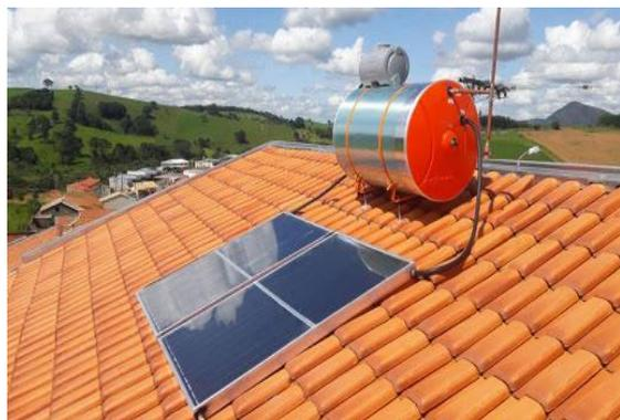
Nos painéis de aquecimento solar, há captação e transferência de calor a água, que é aquecida.
