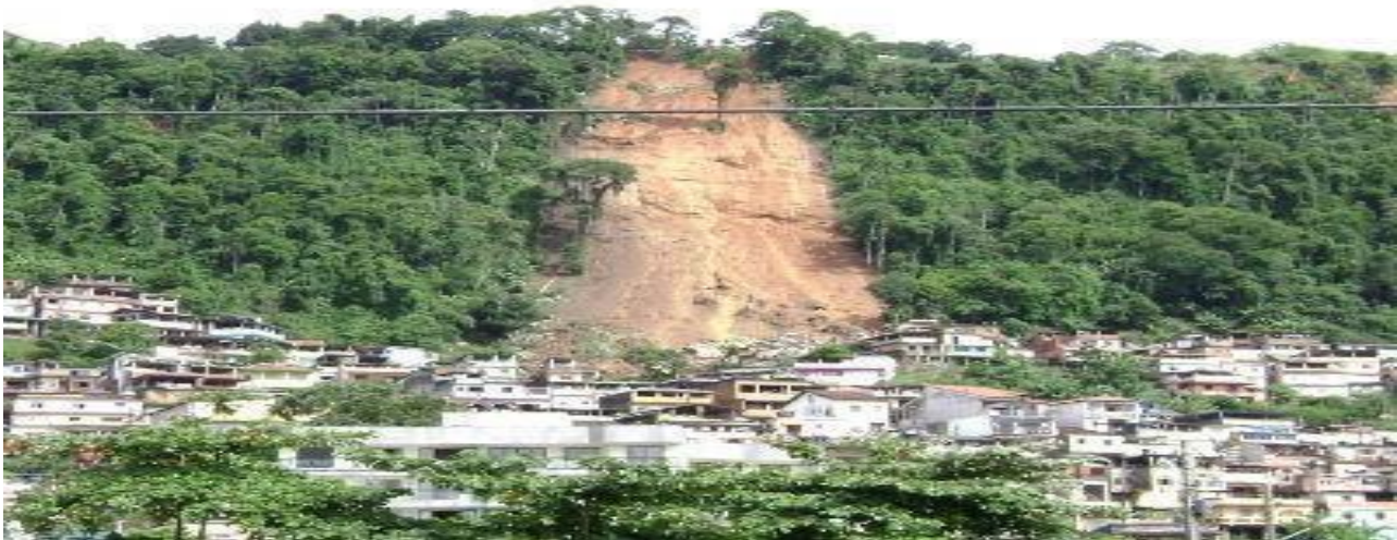
Deslizamento de Terra em Angra dos Reis, em 2010
