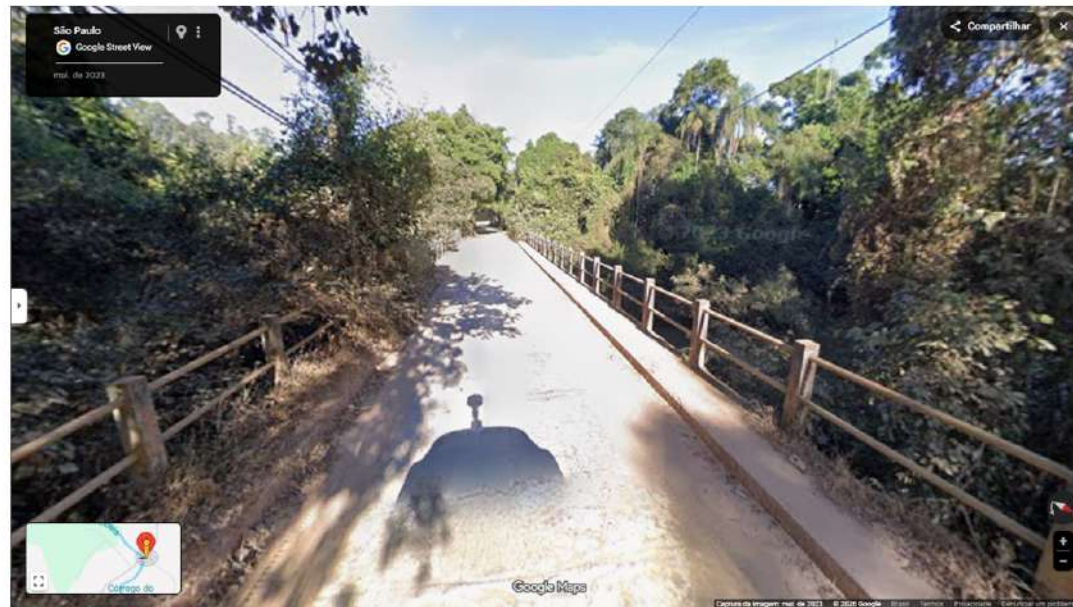
Imagem 002: Estrada Carlos Cavaleri, altura da Ponte do Rio Atibaia, em Maio de 2023 (Foto: Google Street View) – PLANCON.
