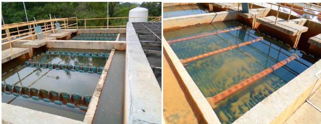
Figura 22 - Decantadores.
