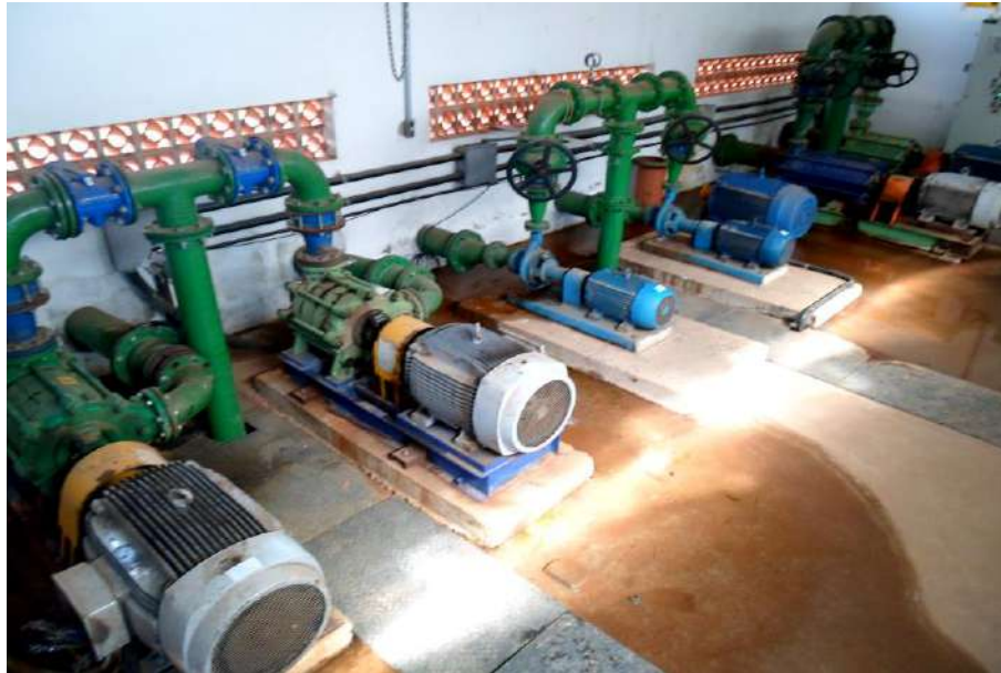
Figura 33 - Bombas de recalque do Reservatório 5 para distribuição.
