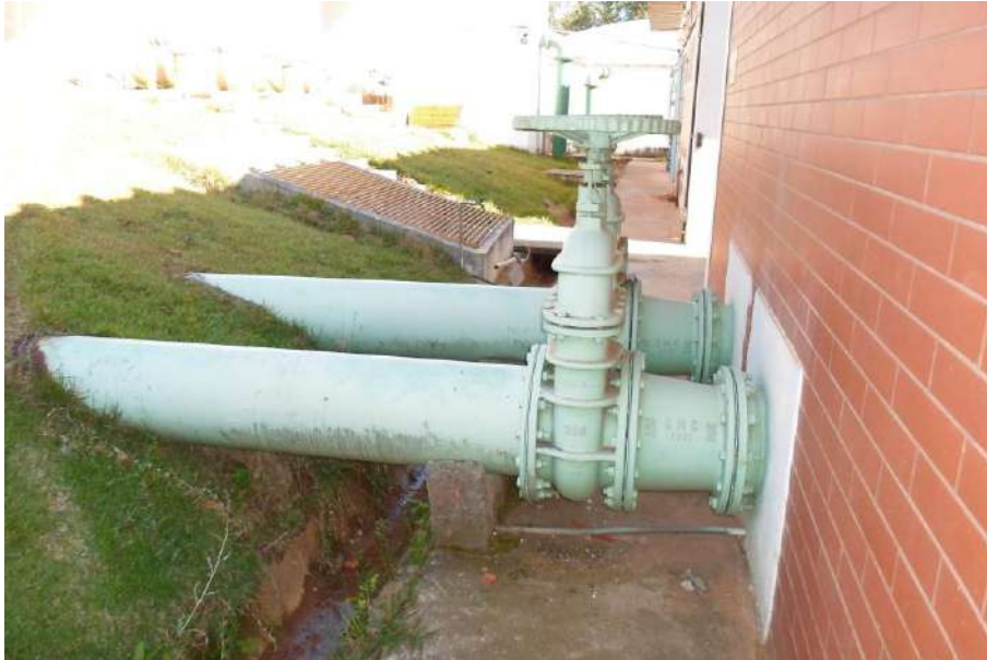
Figura 19 - Adução de Água Bruta - Chegada na ETA.
