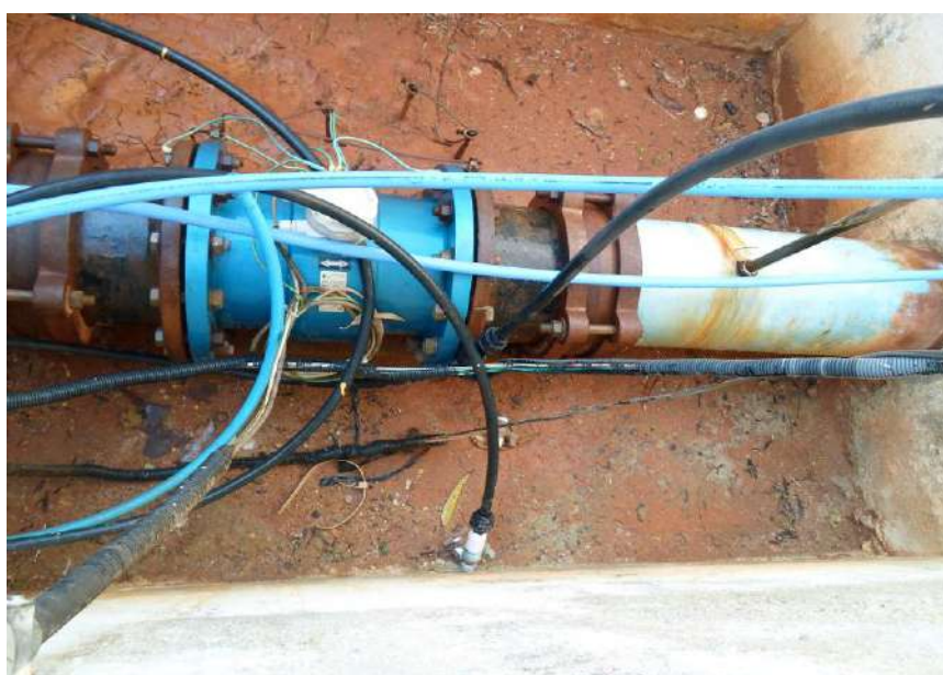
Figura 38 - Macromedidor de entrada da ETA.
