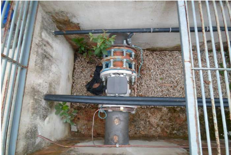
Figura 39 - Macromedidor de saída da ETA.
