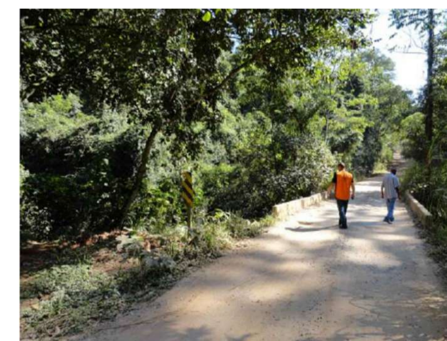
Fonte: Adaptado Relatório IPT. Ponte junto à estrada da Cruzança. Quando ocorre inundação, o acesso fica interrompido.
