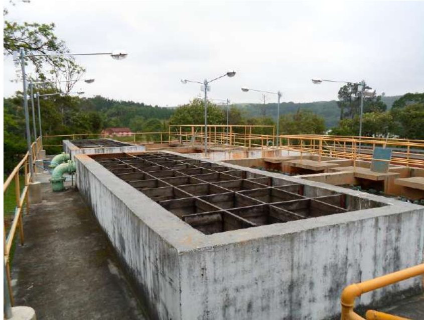
Figura 21 - ETA: Floculadores tipo chicana de madeira.
