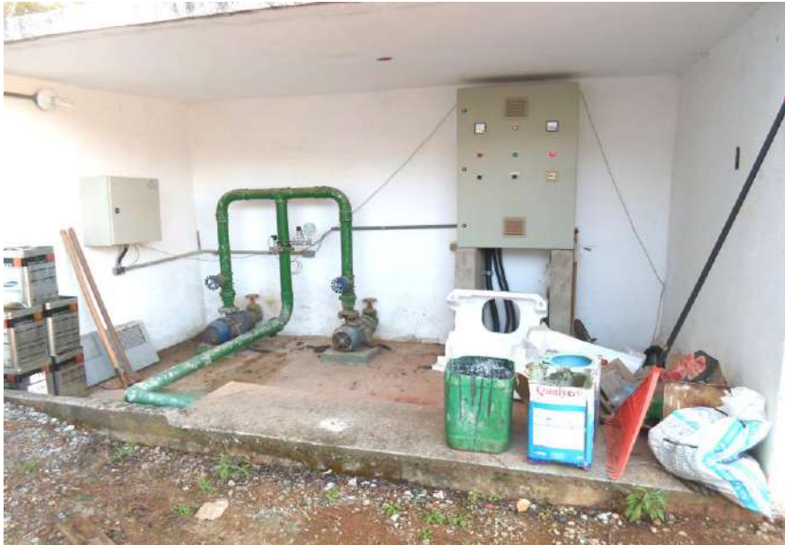
Figura 35 - Bombas de recalque dos Reservatórios R1A e R1 para Reservatório 2.
