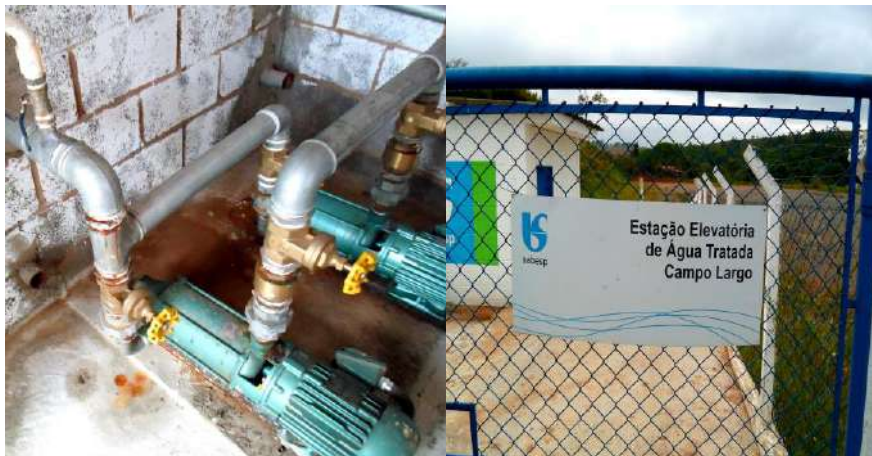
Figura 34 - Bombas de recalque do Reservatório 4 para bairro Campo Largo.
