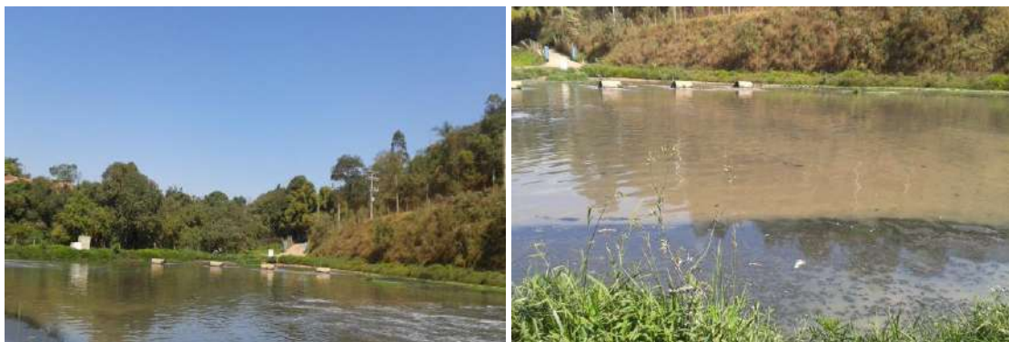
Figura 46 - Constatação de Assoreamento na Lagoa Anaeróbia.
