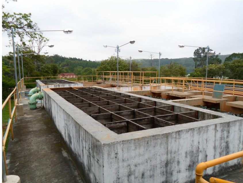
Figura 21 - ETA: Floculadores tipo chicana de madeira.
