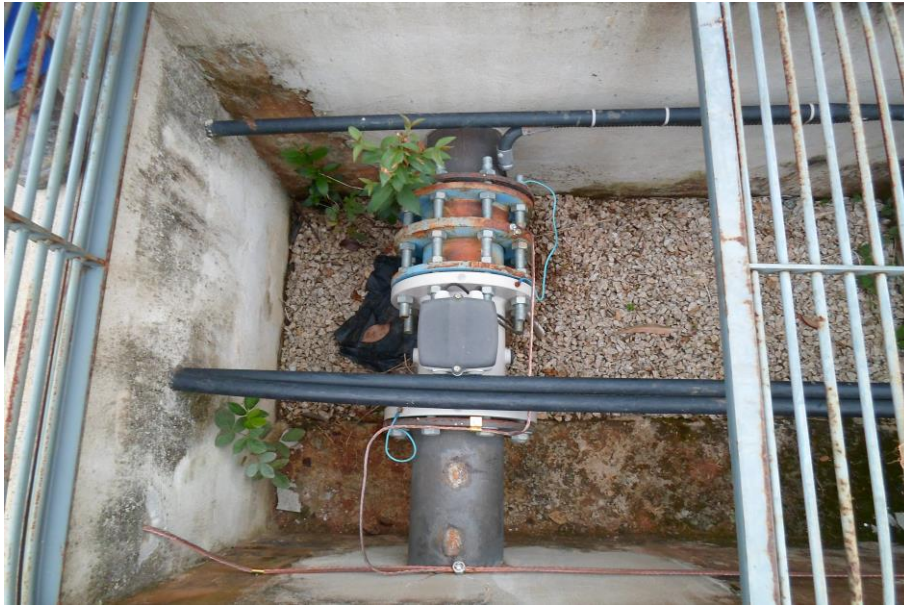
Figura 39 - Macromedidor de saída da ETA.
