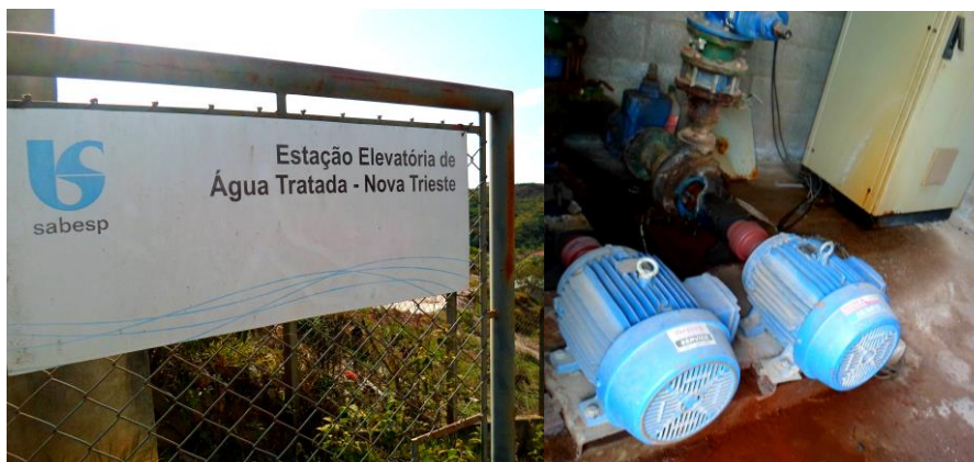
Figura 36 - Bombas de recalque dos Reservatórios R1A e R1 para Reservatório 2.
