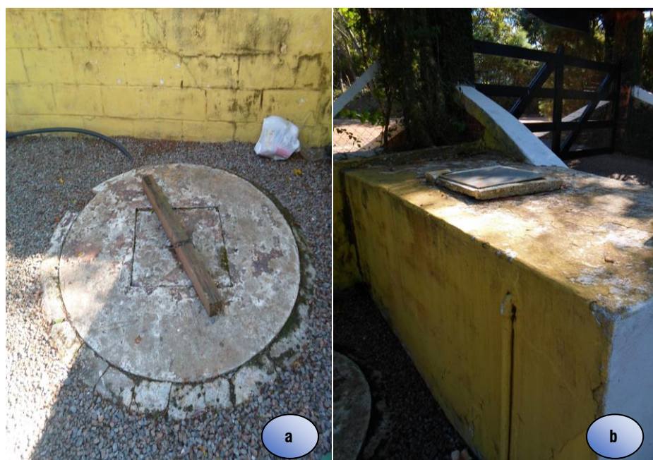
Figura 37 - Captação subterrânea para abastecimento de água na área rural do município de Jarinu: a) poço cacimba; b) Reservação.
