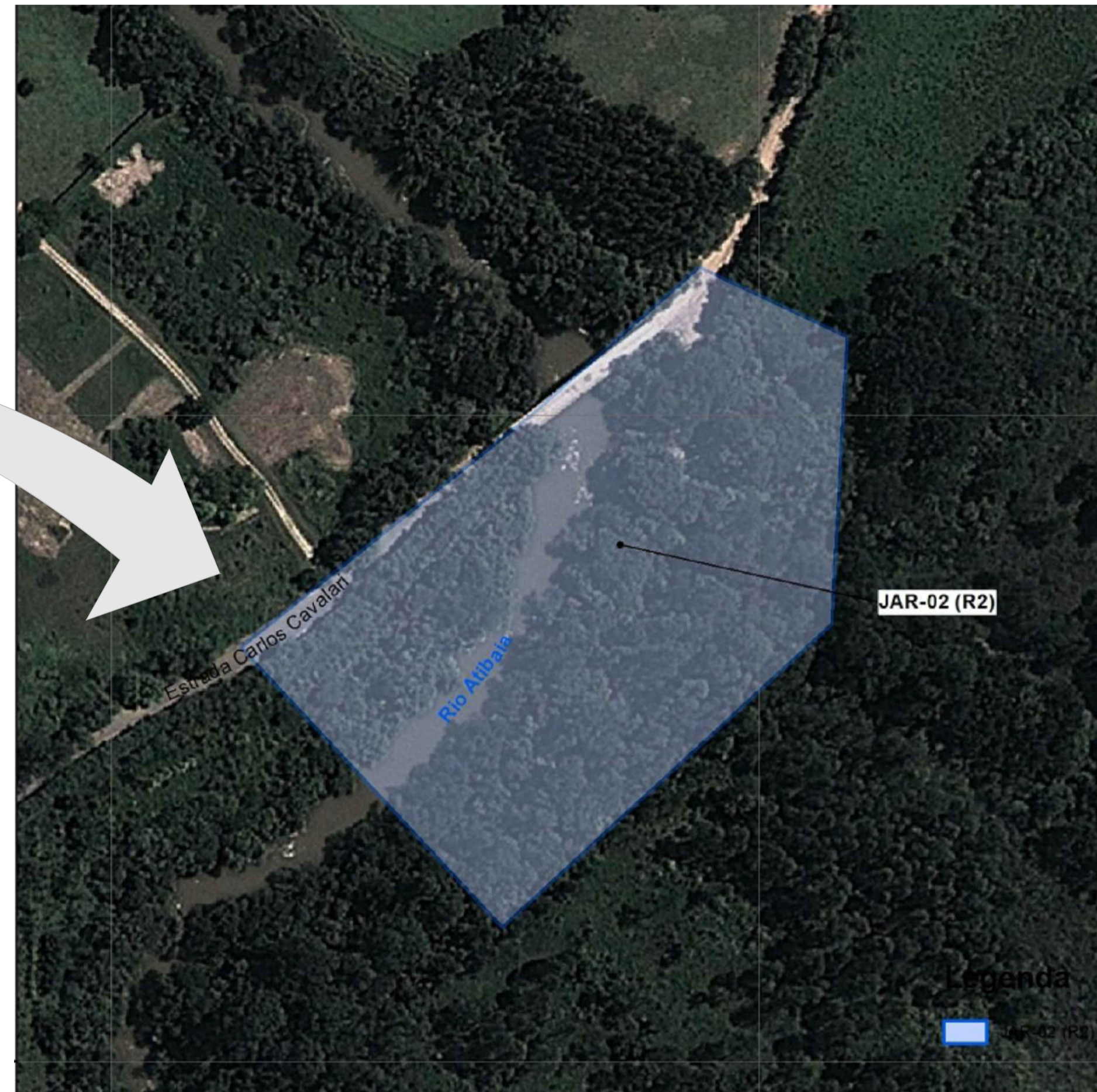
Fonte: Adaptado Relatório IPT. Vista aérea da área JAR 02 – Ponte Alta/Bairro São Joaquim – Estrada Carlos Cavalari.
