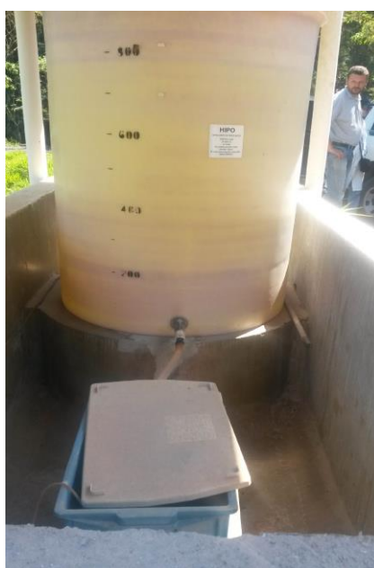
Figura 49 - Tanque de armazenamento e de adição de hipoclorito de sódio.
