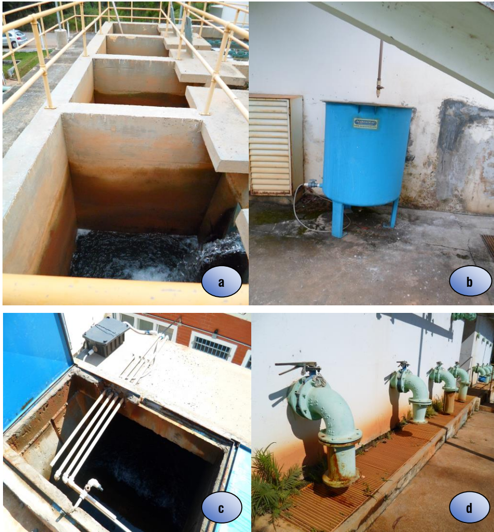
Figura 23 - ETA: : a) filtros; b) Polieletrólito; c) Tanque de contato ; d) Descarte de água de lavagem dos filtros.
