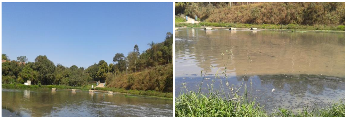
Figura 46 - Constatação de Assoreamento na Lagoa Anaeróbia.
