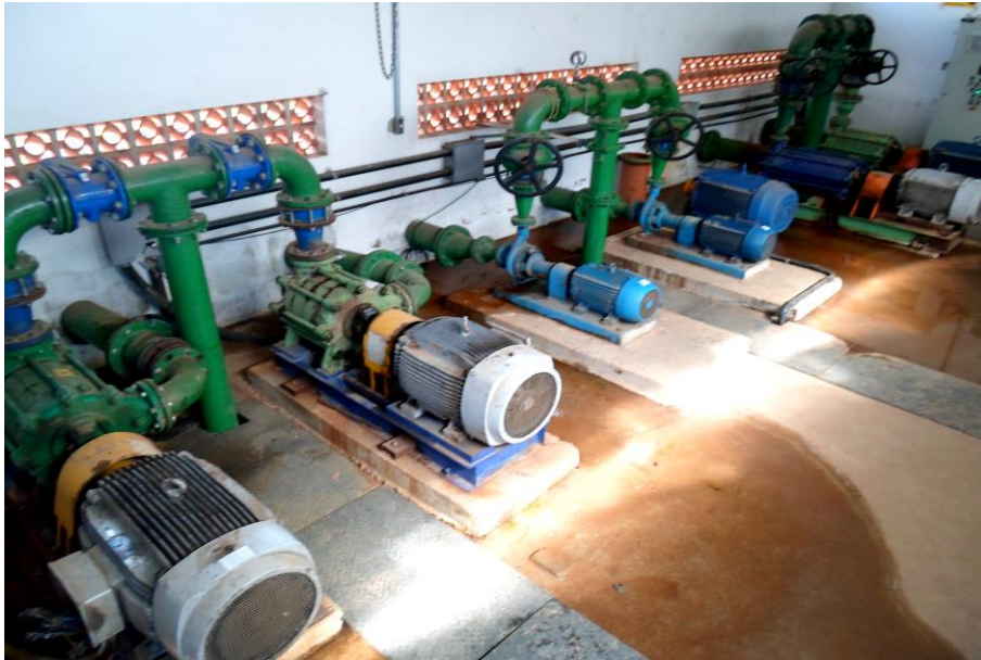
Figura 33 - Bombas de recalque do Reservatório 5 para distribuição.
