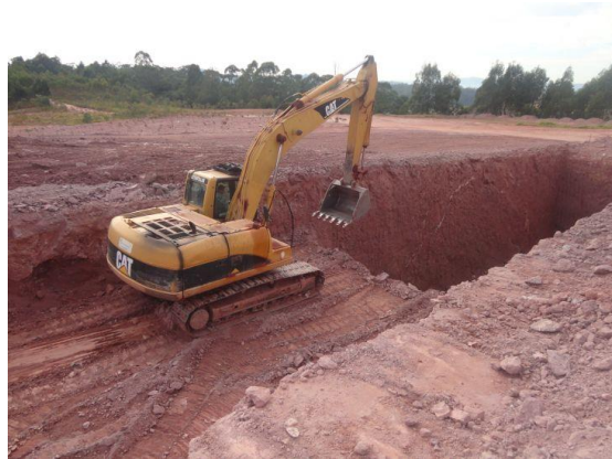
Figura 15 – Escavadeira preparando a vala para os resíduos excedentes serem destinados.
