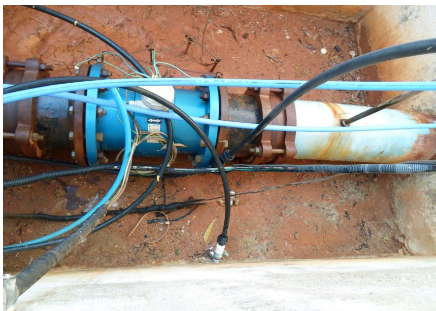
Figura 38 - Macromedidor de entrada da ETA.
