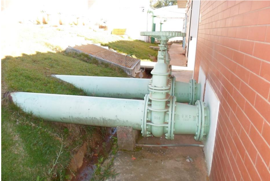
Figura 19 - Adução de Água Bruta - Chegada na ETA.
