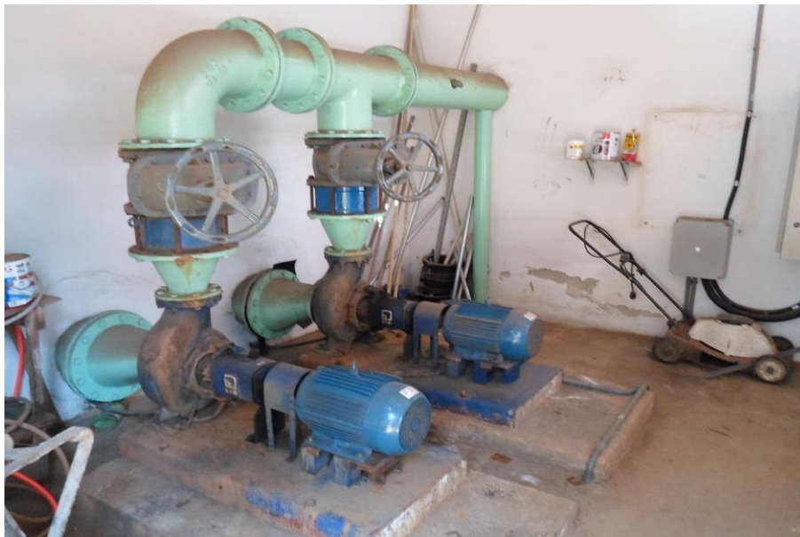
Figura 17 - EEAB: Captação para tratamento na ETA.
