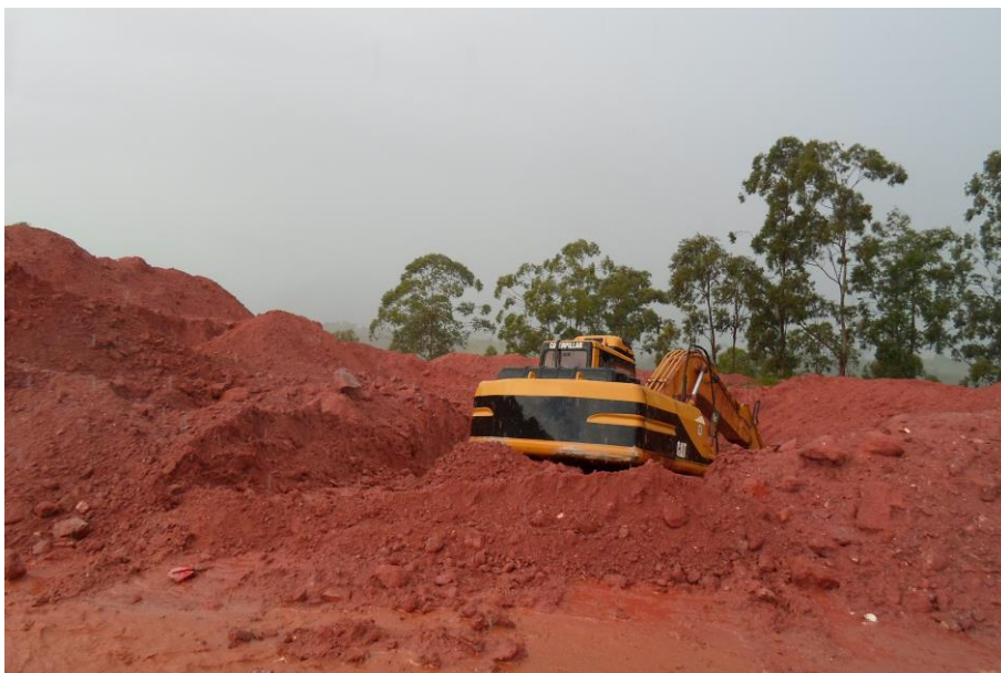
Figura 61 - Realização de abertura de nova vala.
