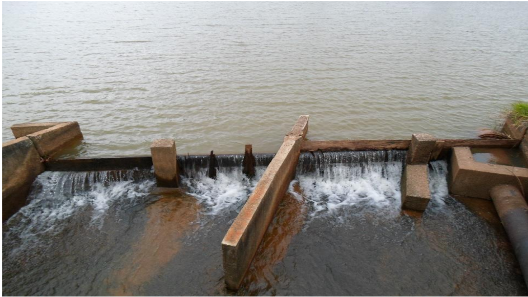
Figura 15 - Captação na Barragem de acumulação de água do Ribeirão Maracanã. Fonte: B&B Engenharia Ltda, 2014.
