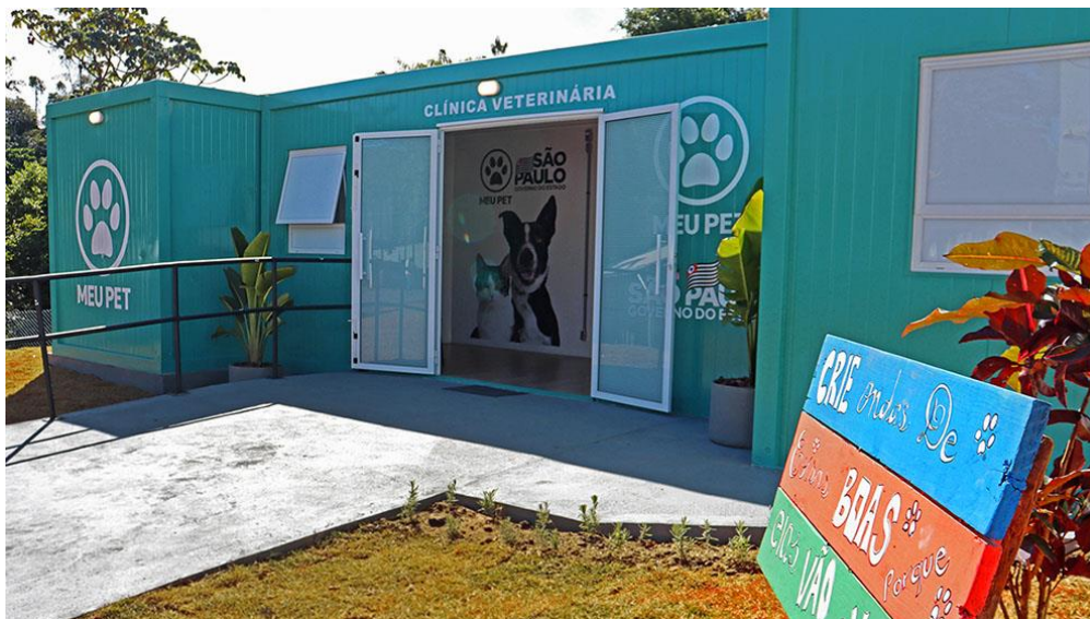
Figura 29 - Clínica Veterinária instalada em contêiner – Município de Jarinu/SP
