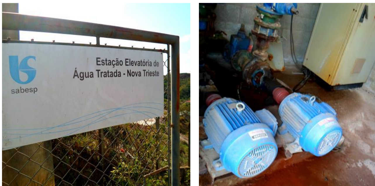
Figura 21 - Bombas de recalque dos Reservatórios R1A e R1 para Reservatório 2 Fonte: B&B Engenharia Ltda, 2014.
