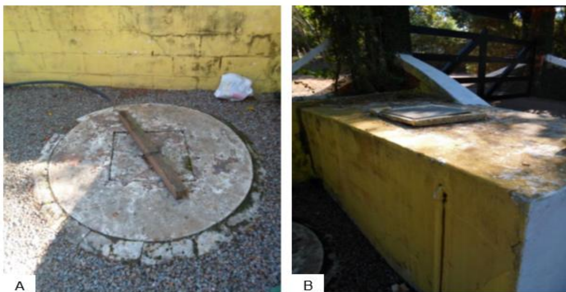
Figura 22 - Captação subterrânea para abastecimento de água na área rural do município de Jarinu: a) poço cacimba; b) Reservação.
