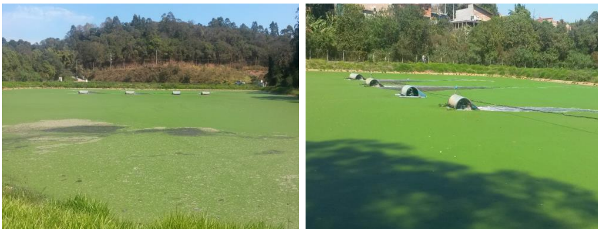
Figura 25 - Lagoa Facultativa com presença de Macrófitas – ETE Jarinu/SP Fonte: B&B Engenharia, 2014.
