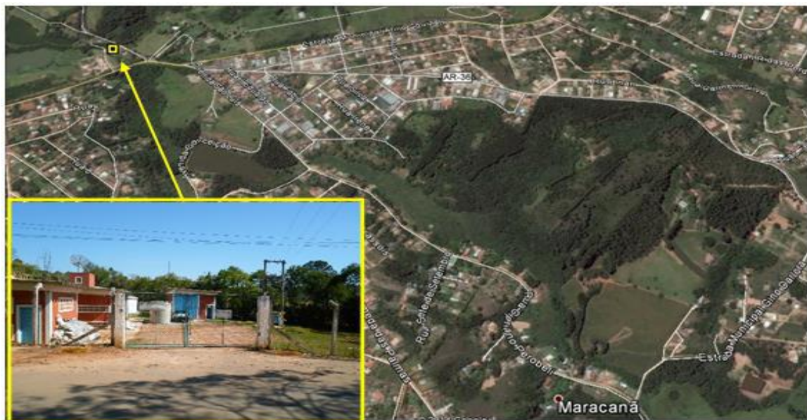
Figura 16 - Estação de Tratamento de Água de Jarinu/SP Fonte: Adaptado de Google Earth, 2014; SABESP, 2014 (apud B&B Engenharia Ltda, 2016).
