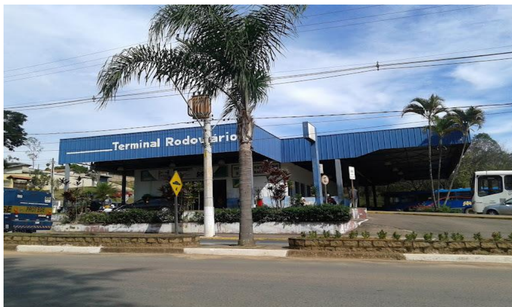
Figura 4 - Terminal Rodoviário de Jarinu
