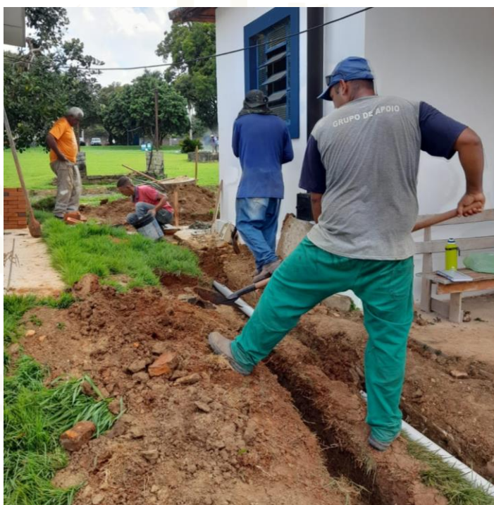
Imagem 1. Separação do encanamento do esgoto da bacia sanitária e de águas cinzas. Fonte: acervo prefeitura (oficina de saneamento ecológico realizado em março/2024 no Pq. Castelinho).
