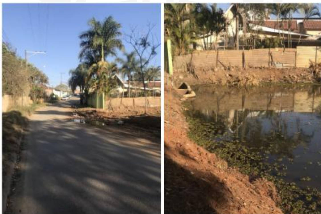
Figura 87 - Ponto de alagamento 1 (Rua José Paulino)
