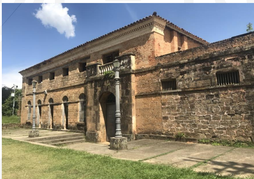
Figura 20 - Vista externa, Casa da Guarda
