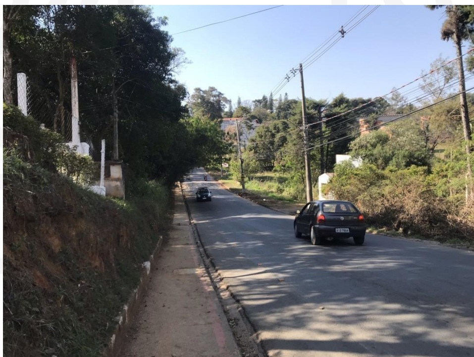
Figura 91 - Ponto de alagamento 10 (Avenida Antônio Vieira do Amaral)
