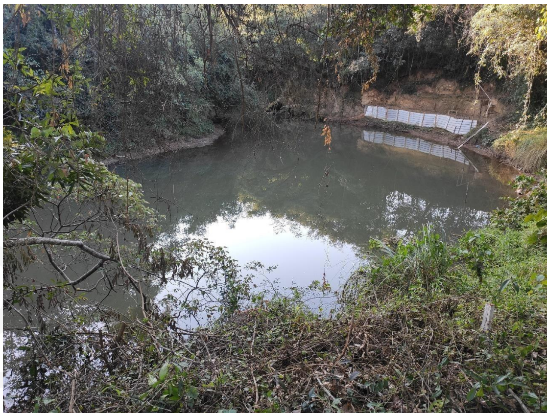
Figura 42 - Captação superficial do Rio Sarapuí
