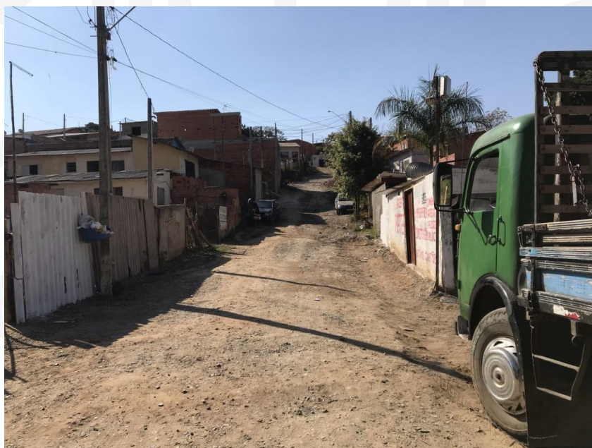
Figura 80 - Via sem pavimentação no Bairro Araçoiabinha
