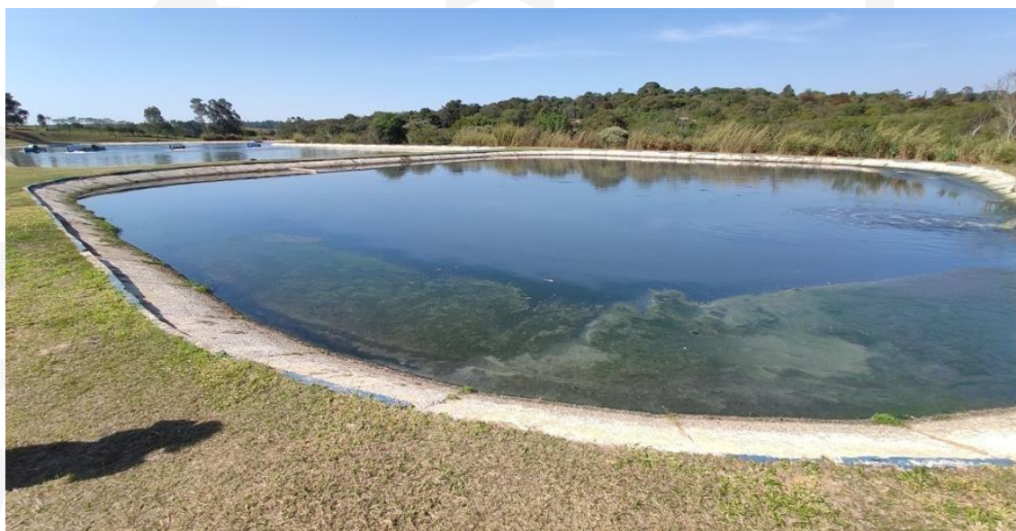
Figura 55 - Lagoa anaeróbia da ETE Vacariú
