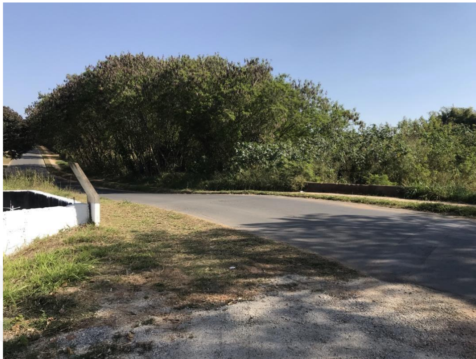
Figura 92 - Ponto de Alagamento 11 (Avenida Antônio Vieira do Amaral)
