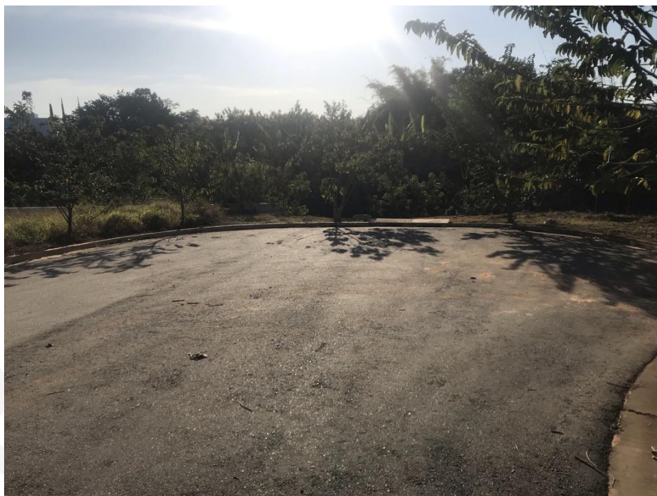
Figura 90 - Ponto de alagamento 9 (Próximo à Rua do Campo)
