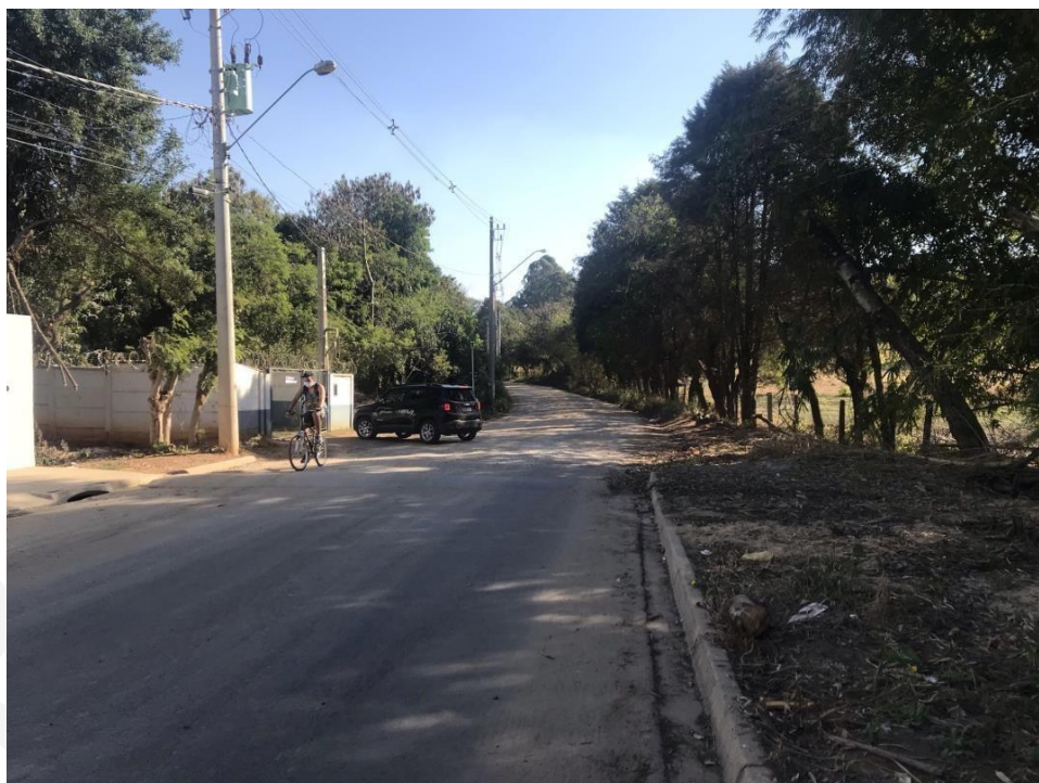
Figura 88 - Ponto de alagamento 2 (Rua Osvaldo de Antunes)
