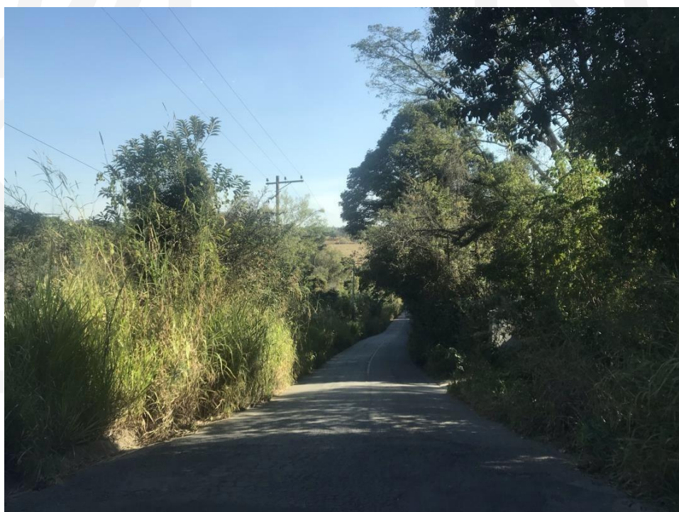
Figura 95 - Ponto de alagamento 18 (Estrada de Aparecida)
