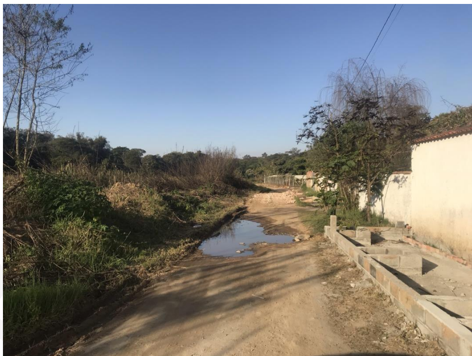
Figura 94 - Ponto de alagamento 16 (Alameda das Acácias)
