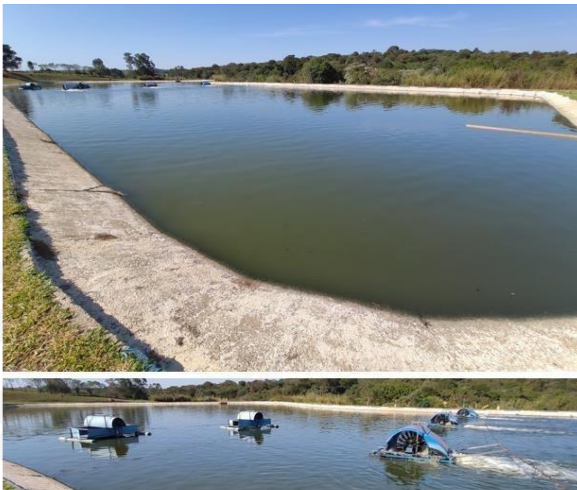
Figura 56 - Lagoa facultativa da ETE Vacariú
