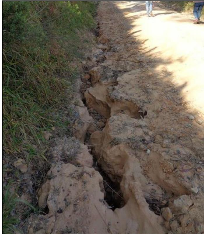
**Figura 46:** Processos erosivos (ravinas evoluindo para voçorocas) acompanhando a direção da estrada.
