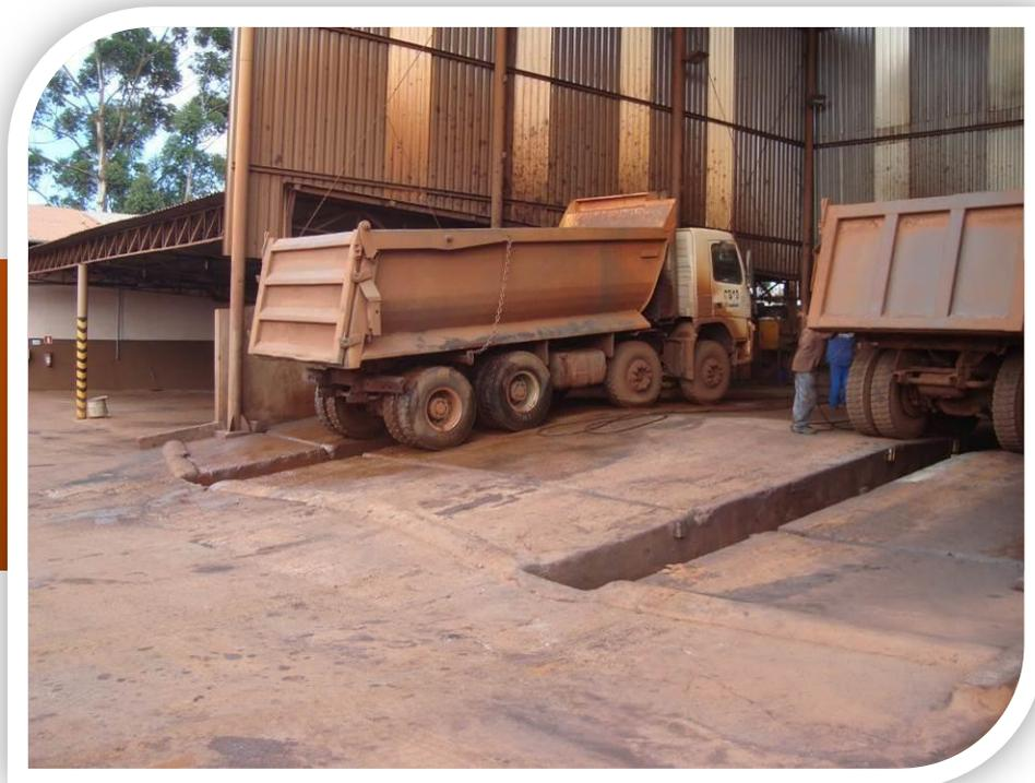
Rampa para lavagem de veículos cujos efluentes oleosos são direcionados para caixa separadora de água e óleo.
