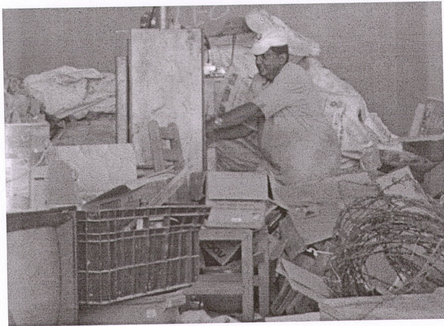
Materiais chegando ao galpão, que até então era acoplado ao barracão de obras
