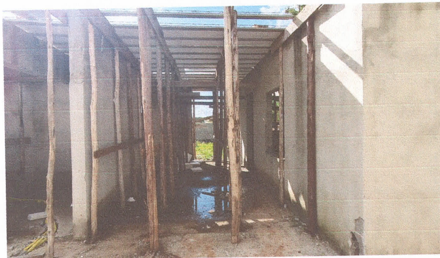
Imagem 02: Escoramento de madeira para as vigotas treliçadas, para as lajes.
