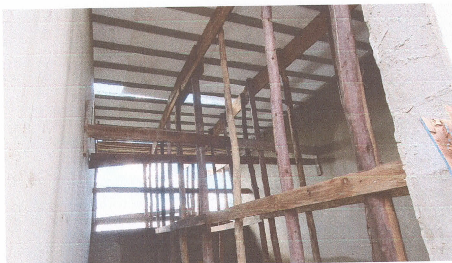
Imagem 09: Colocação dos Eps (isopor) para preenchimento e escoramento de madeira para as vigotas treliçadas, para as lajes.
