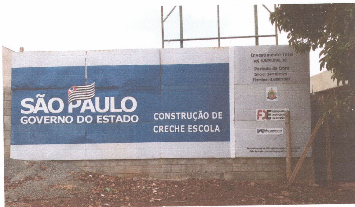
Imagem 01: Placa de obra.
