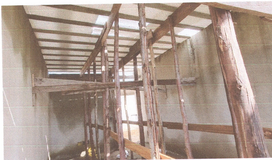
Imagem 08: Colocação dos Eps (isopor) para preenchimento e escoramento de madeira para as vigotas treliçadas, para as lajes.
