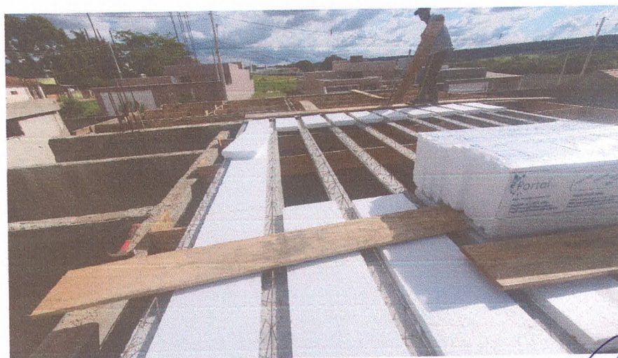
Imagem 07: Colocação dos Eps (isopor) para preenchimento de laje.
