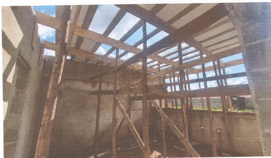
Imagem 03 Escoramento de madeira para as vigotas treliçadas, para as lajes.
