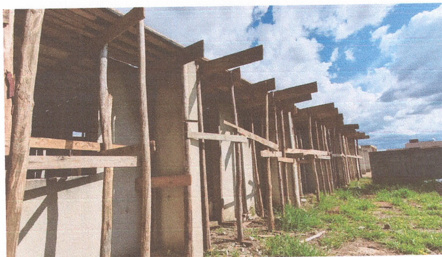
Imagem 06: Formas de madeiras e Escoramento de madeira para as lajes maciças.
