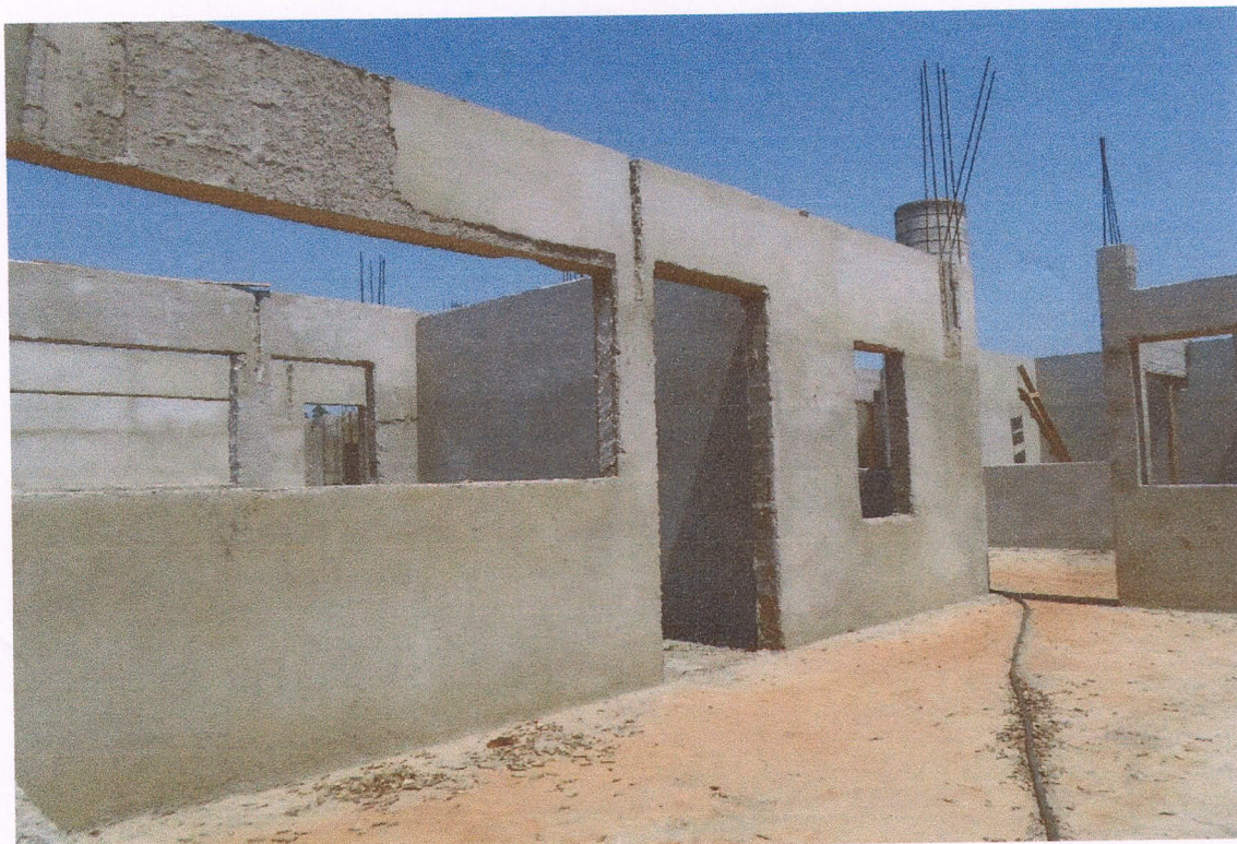
Foto 3 – Vista parcial interna
