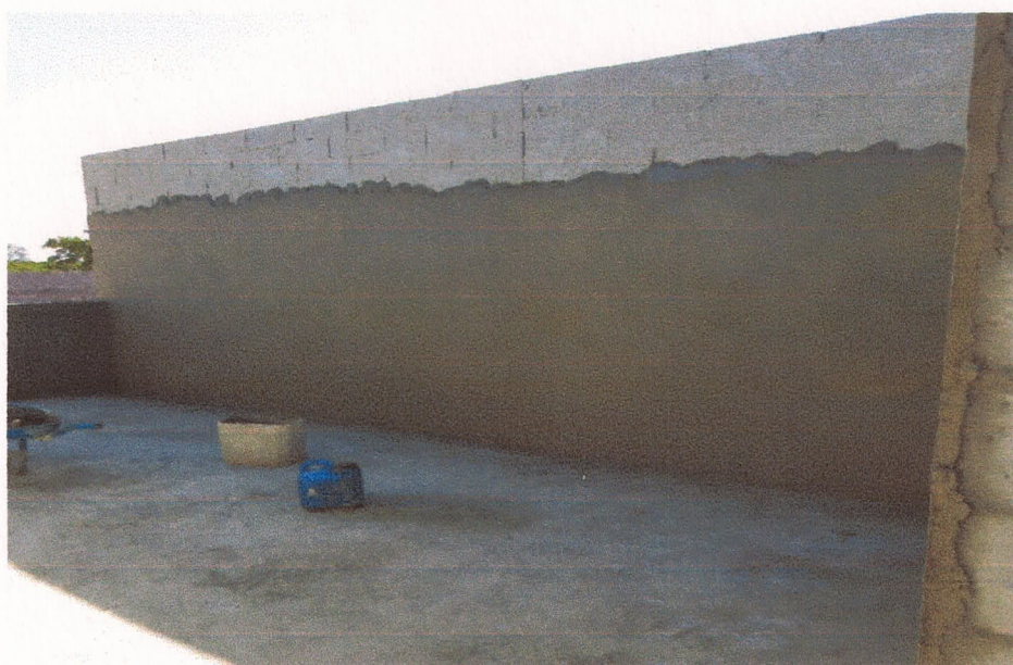
REVESTIMENTO TETO E PAREDE
