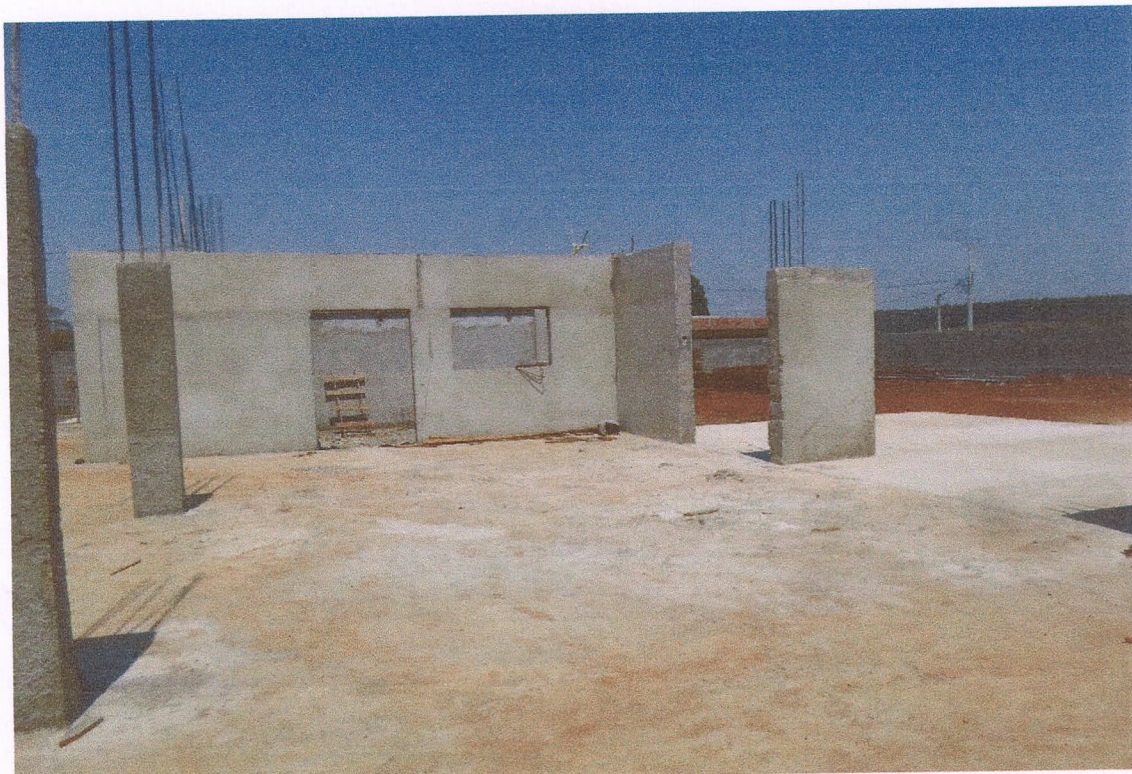
Foto 7 – Vista parcial externa
