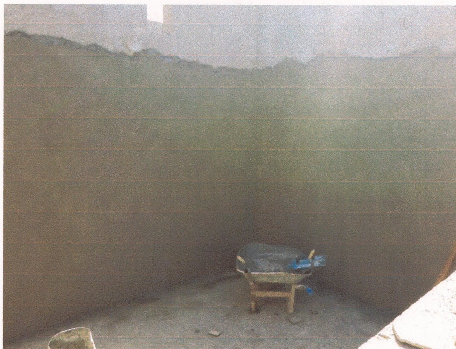
REVESTIMENTO TETO E PAREDE
