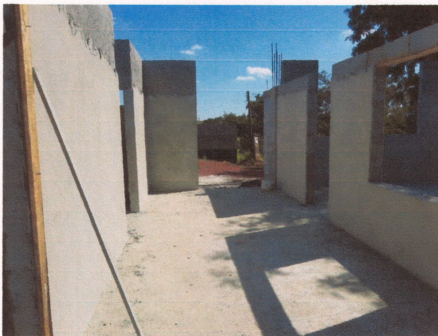
REVESTIMENTO TETO E PAREDE
