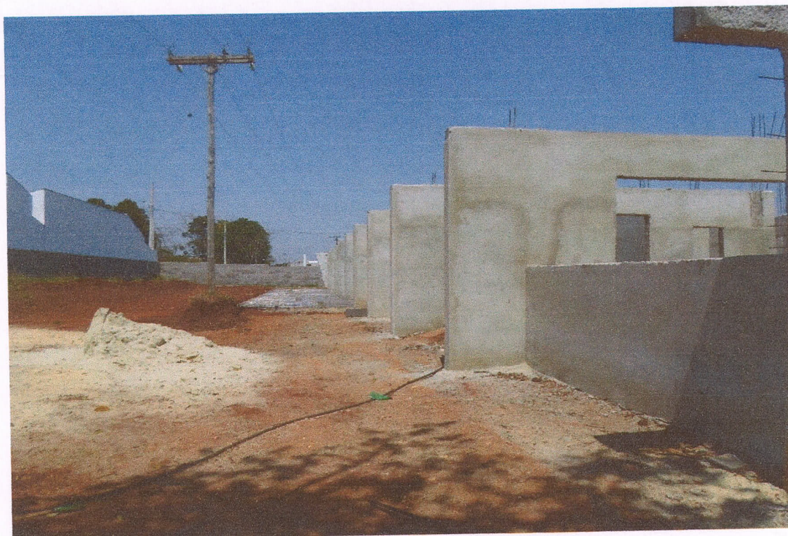
Foto 2 – Vista da Lateral Esquerda.
