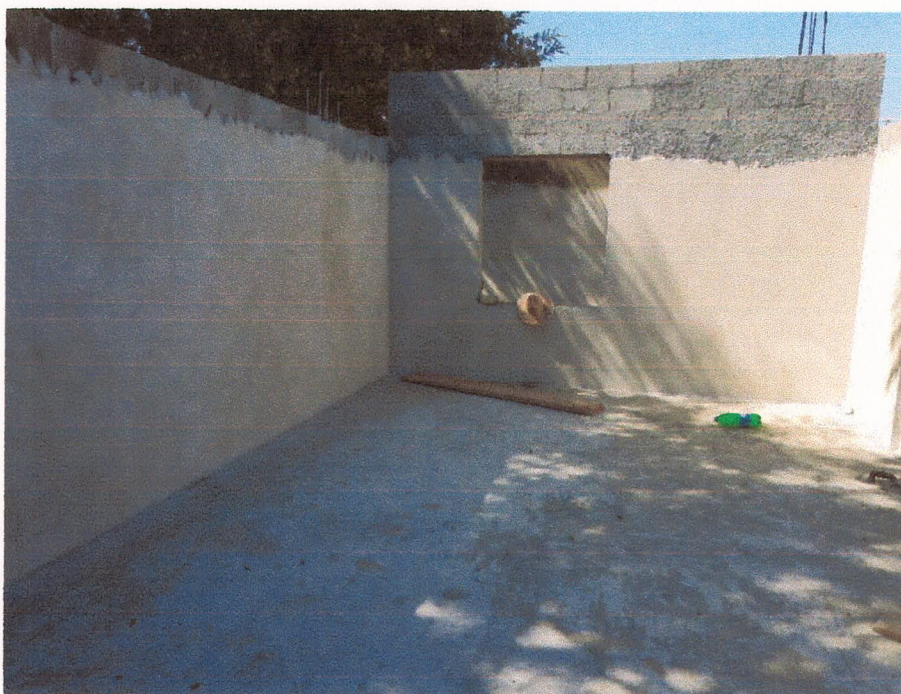
REVESTIMENTO TETO E PAREDE
