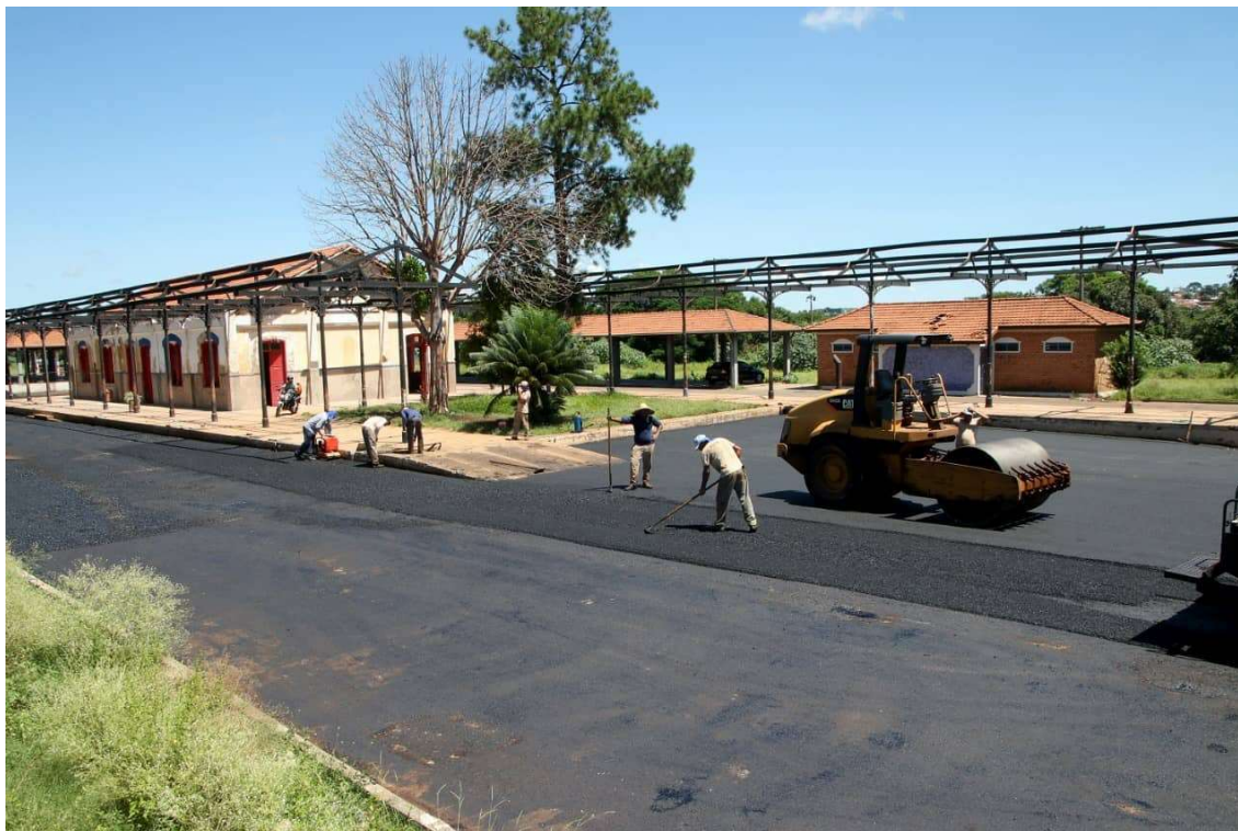
Figura 62 - Entorno da antiga Estação Ferroviária recebe recapeamento asfáltico dentro de projeto de revitalização
