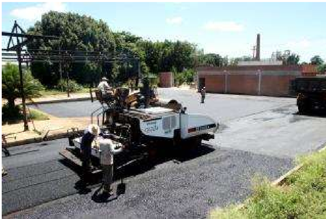
Figura 67 - Entorno da antiga Estação Ferroviária recebe recapeamento asfáltico dentro de projeto de revitalização
