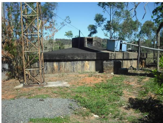
Vista do Reservatório R1
