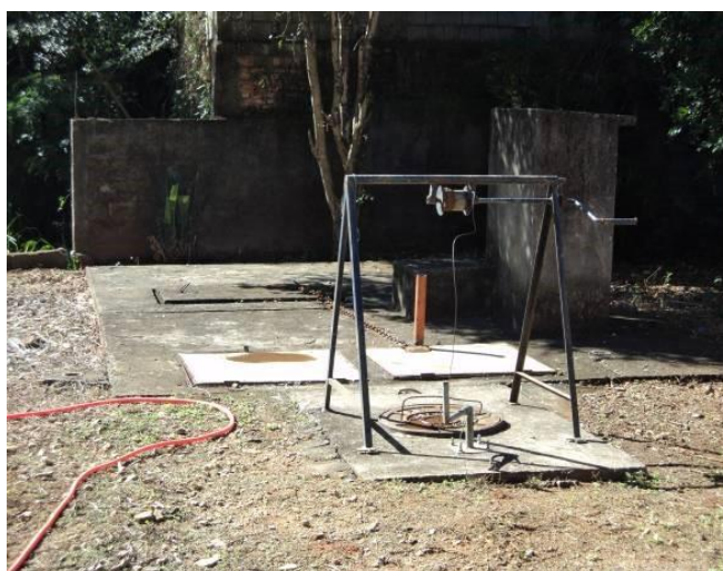
Vista geral da elevatória Ida Corsi
