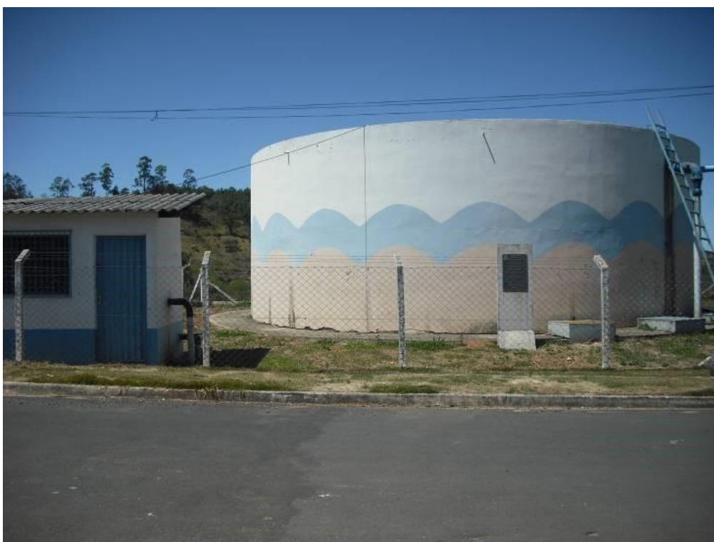
Vista do reservatório R3
