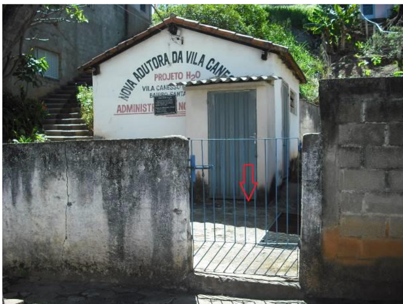
Vista do Estação Elevatória de Água e Reservatório Vista do Reservatório R1
