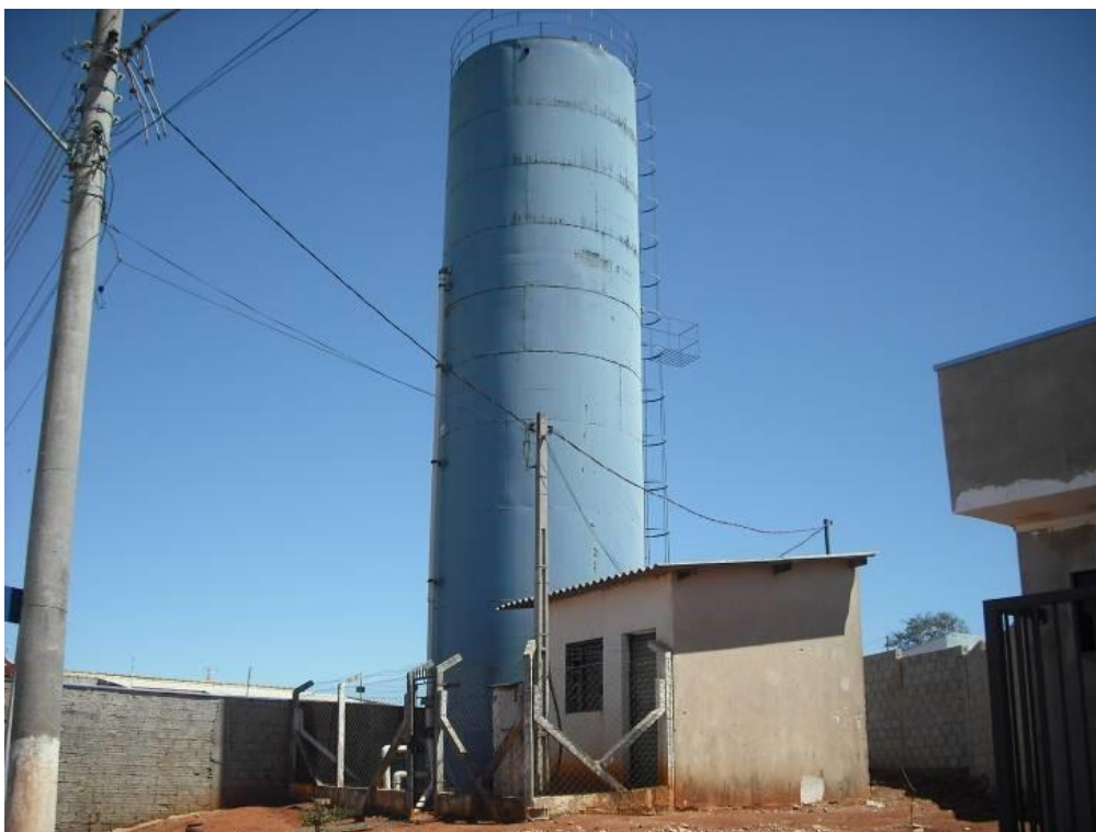
Vista do reservatório R02
