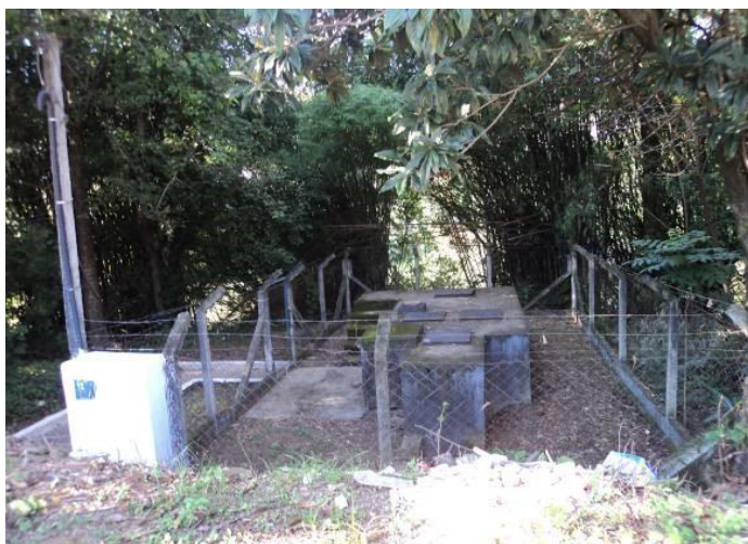
Vista geral da elevatória Av. Wanderley J. Vicentin
