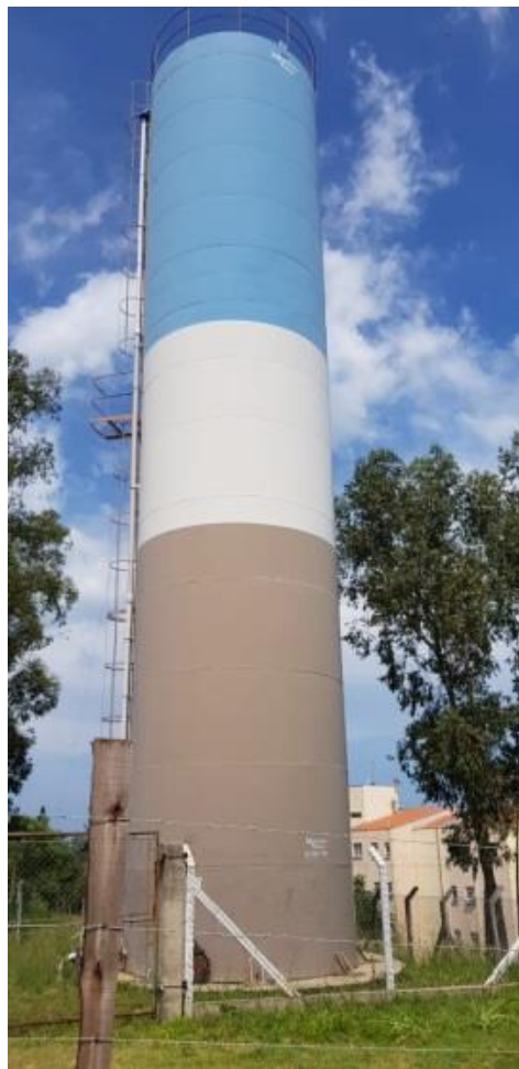
Vista do reservatório R1
