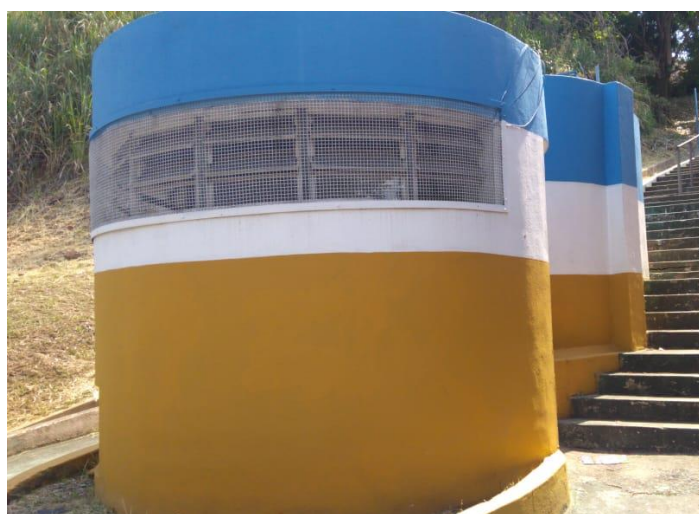
Vista do Reservatório R2
