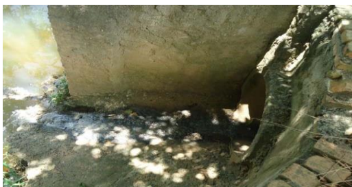
Galeria pluvial com esgoto sanitário sendo lançado irregularmente.
