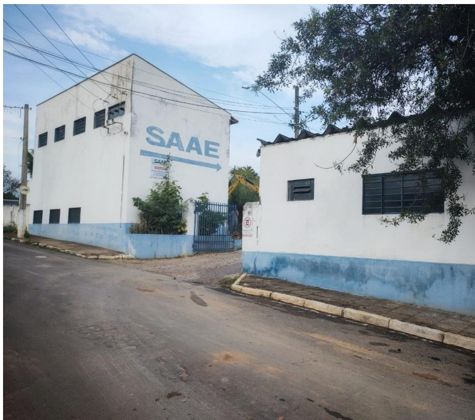
Entrada da Administração Operacional do SAAE
