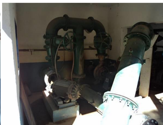
Conjunto moto-bomba de 100 cv captação de água bruta
