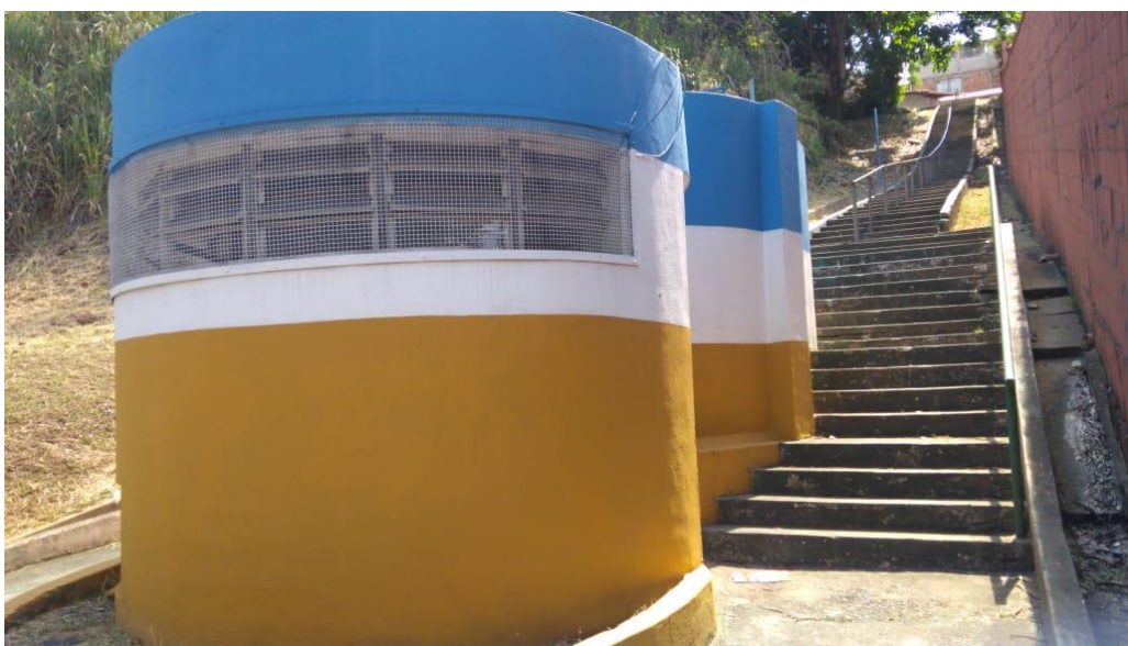
Elevatória à margem esquerda do Rio Jaguarí
