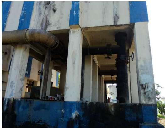
Vista da ETA III
