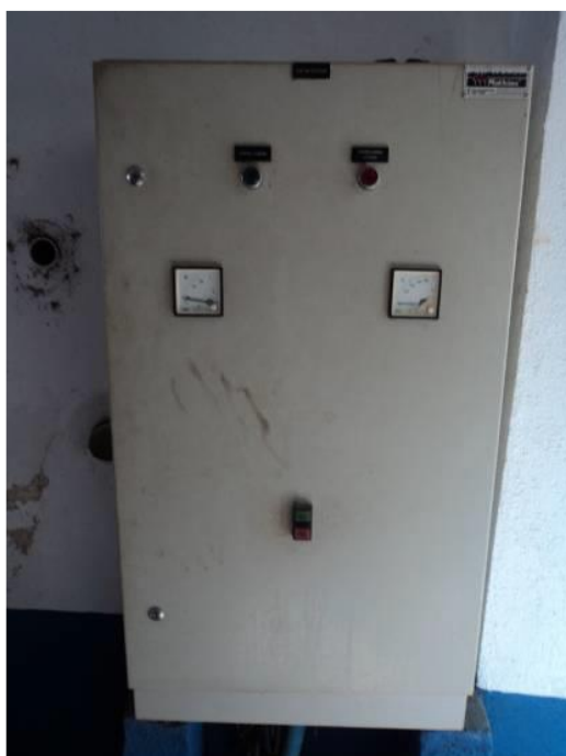
Painel elétrico de um conjunto moto-bomba da captação de água bruta
