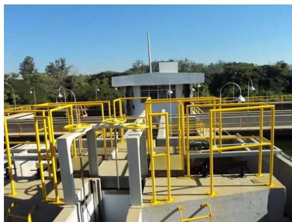
Vista geral da ETE
