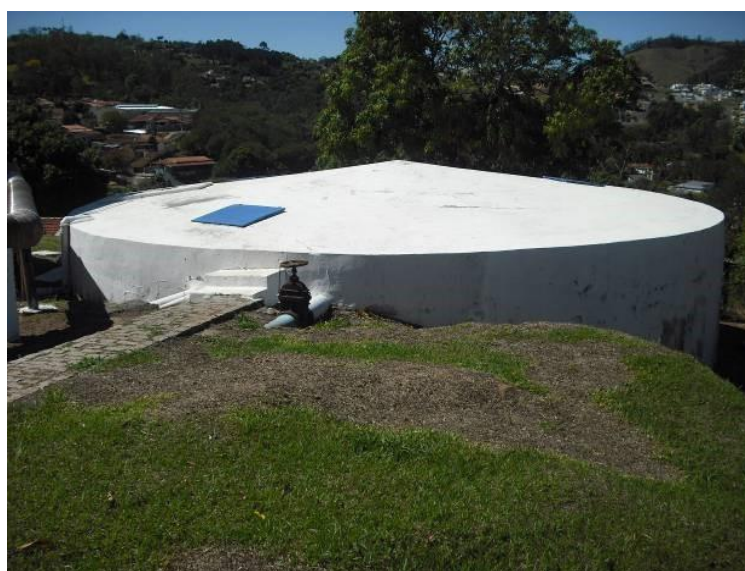
Vista do Reservatório R3
