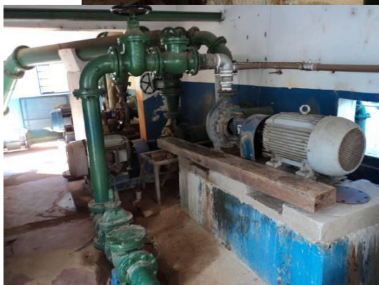
Conjunto motor-bomba de 100cv na captação de água bruta
