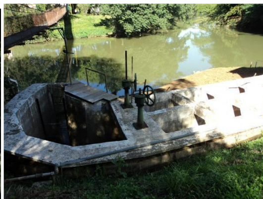
Vista da tomada de água do Rio Jaguari para captação de água bruta
