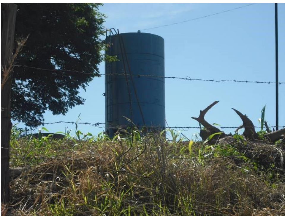
Vista do Reservatório R1
