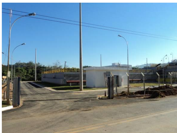
Vista geral da ETE
