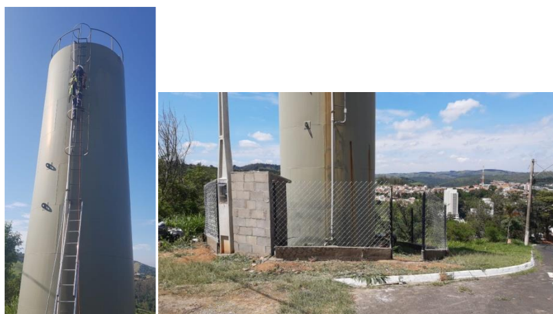
Vista do reservatório R1
