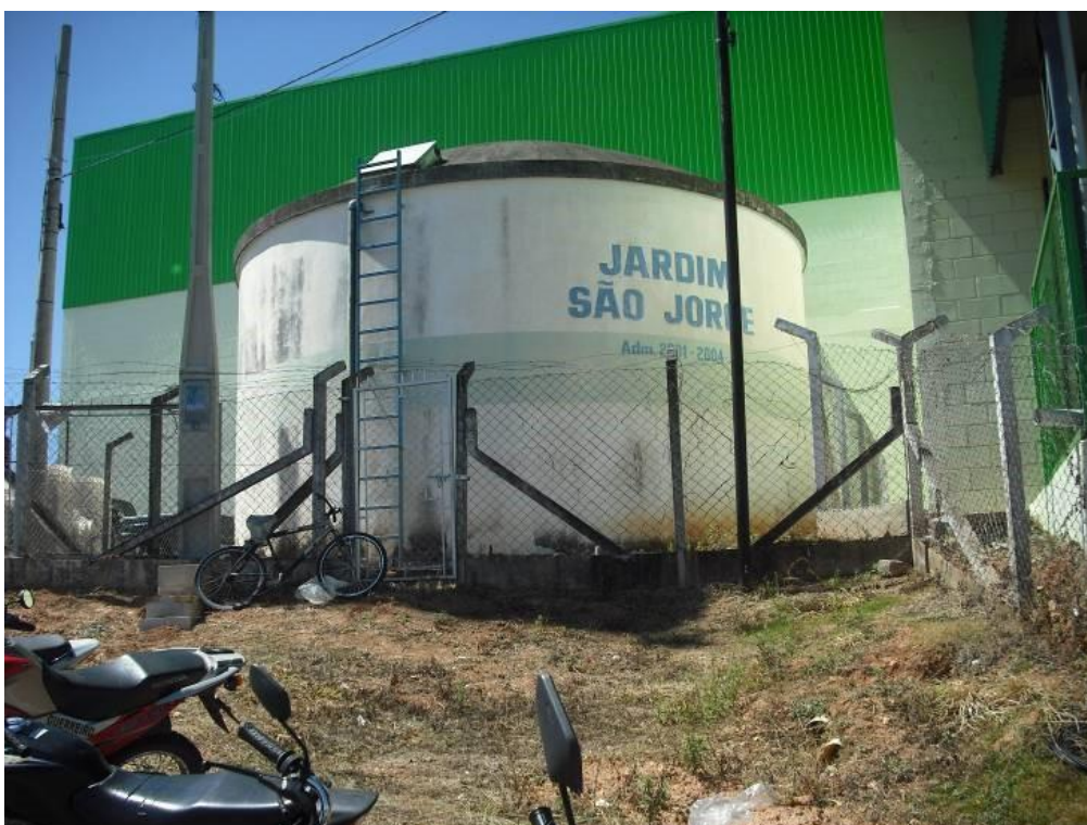
Vista do reservatório R1
