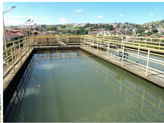
Vista da ETA III
