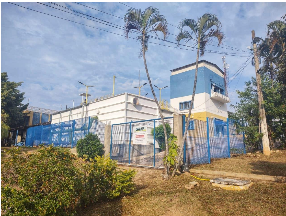
Acesso às Estações de Tratamento de Água do SAAE
