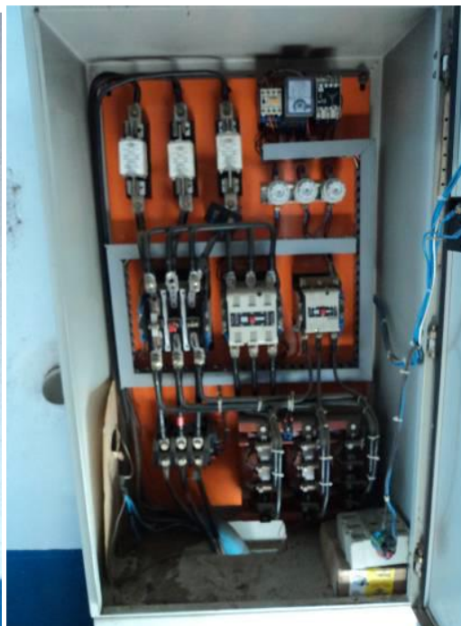
Painel elétrico de um conjunto moto-bomba da captação de água bruta
