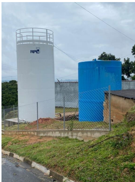
Vista dos Reservatórios R1 e R2
