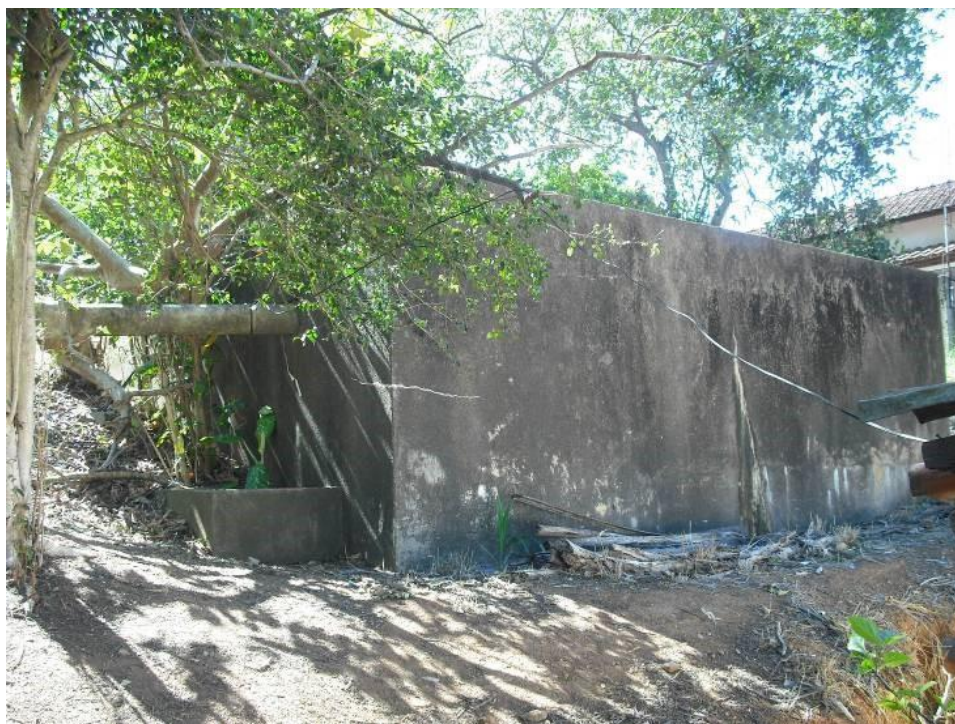
Vista do reservatório R1
