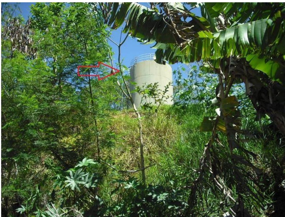
Vista do Reservatório R1
