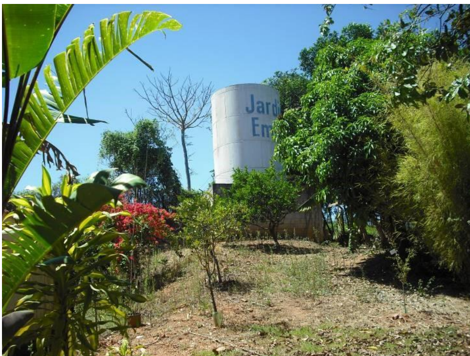
Vista do Reservatório R1
