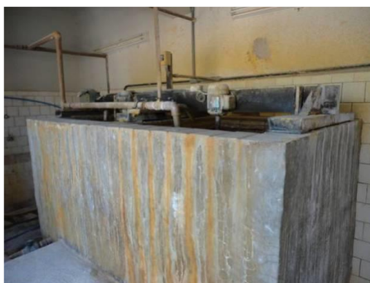
Tanque de preparo do Sulfato de Alumínio
