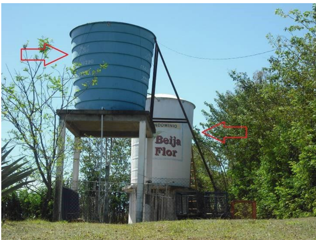
Vista dos Reservatórios R1 e R2 do Condomínio Beija Flor
