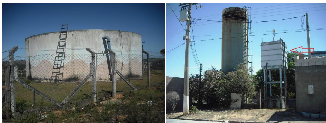
Vista do reservatório R1 Vista do reservatório R2
