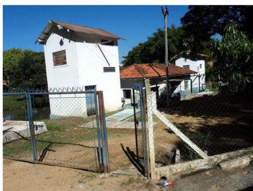
Vista da captação de água bruta do município de Pedreira
