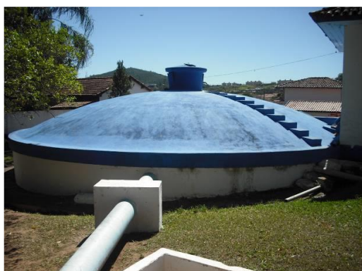
Vista do Reservatório R1
