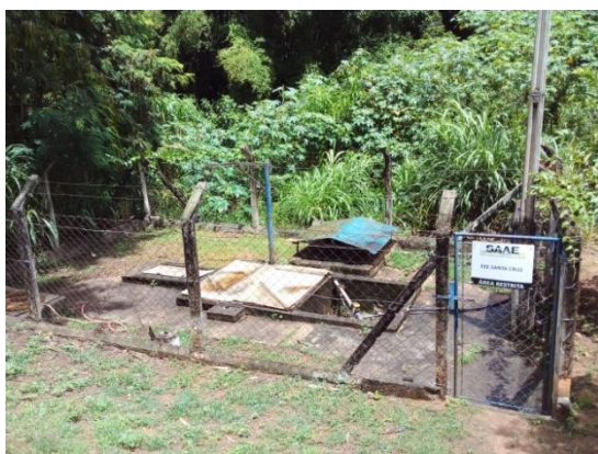
Vista geral da elevatória Santa Cruz
