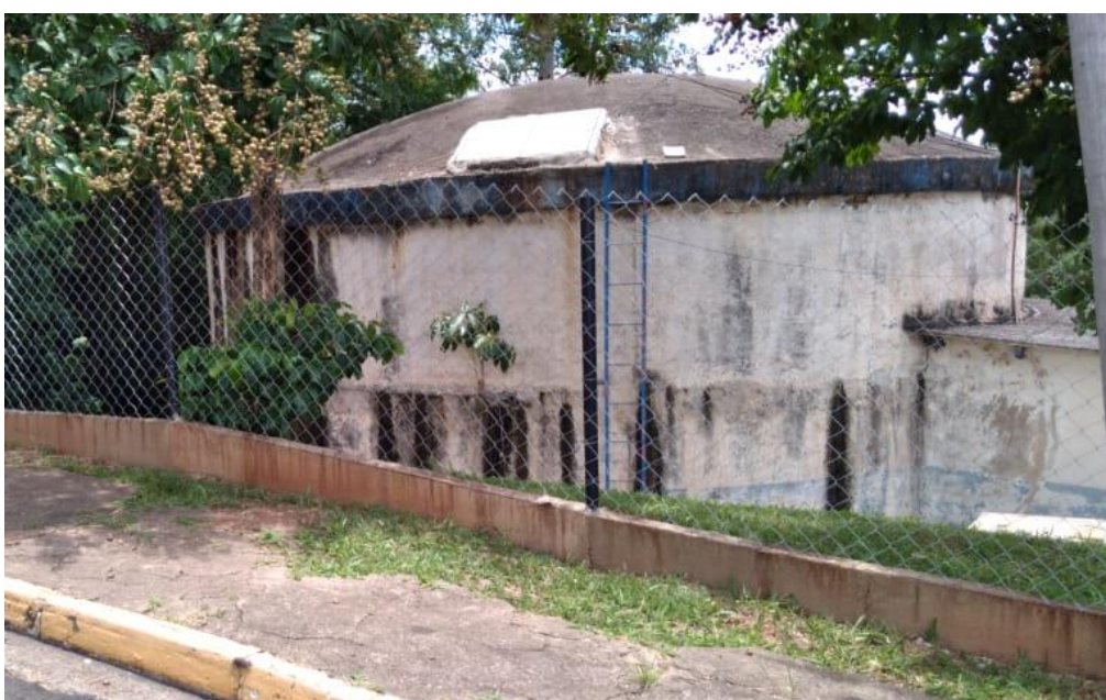
Vista dos reservatórios R1
