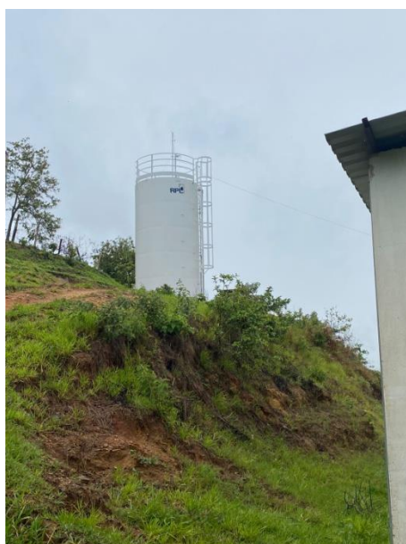
Vista do Reservatório R1
