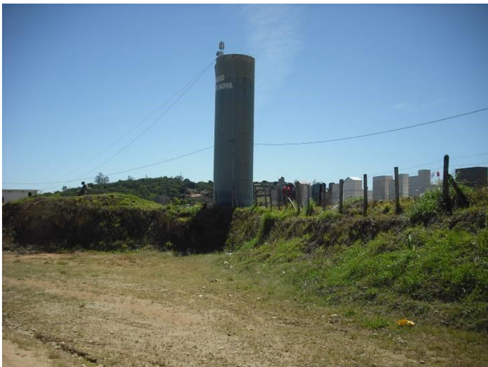
Vista do Reservatório R1
