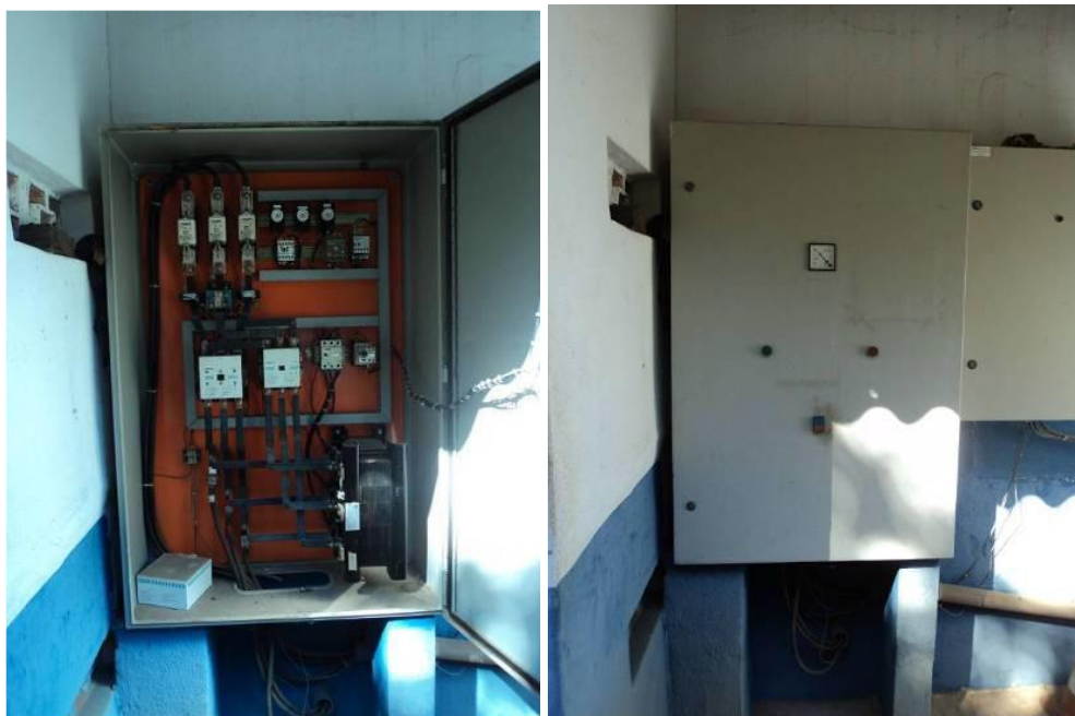
Painel Elétrico de um conjunto moto-bomba da Captação.
