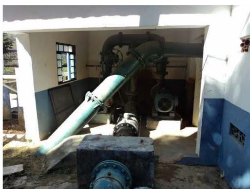
Conjunto moto-bomba de 100 cv captação de água bruta
