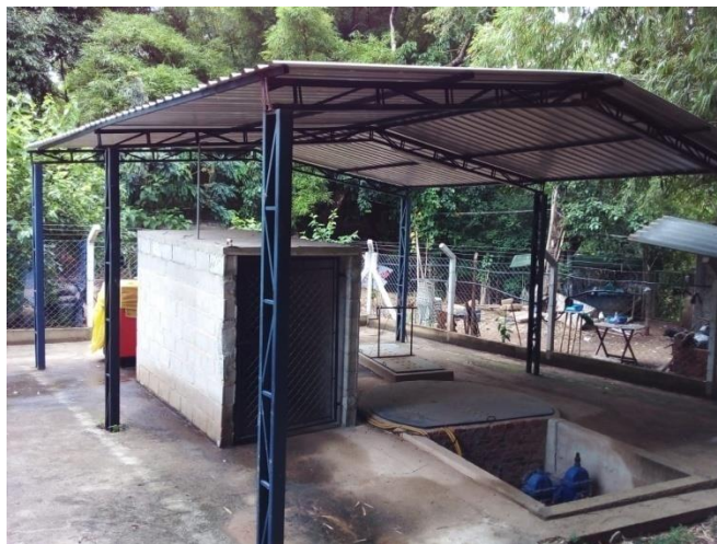
Vista geral da elevatória Ricci
