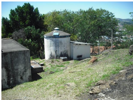
Vista do Reservatório R1
