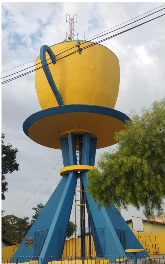
Vista do reservatório Monte Alegre
