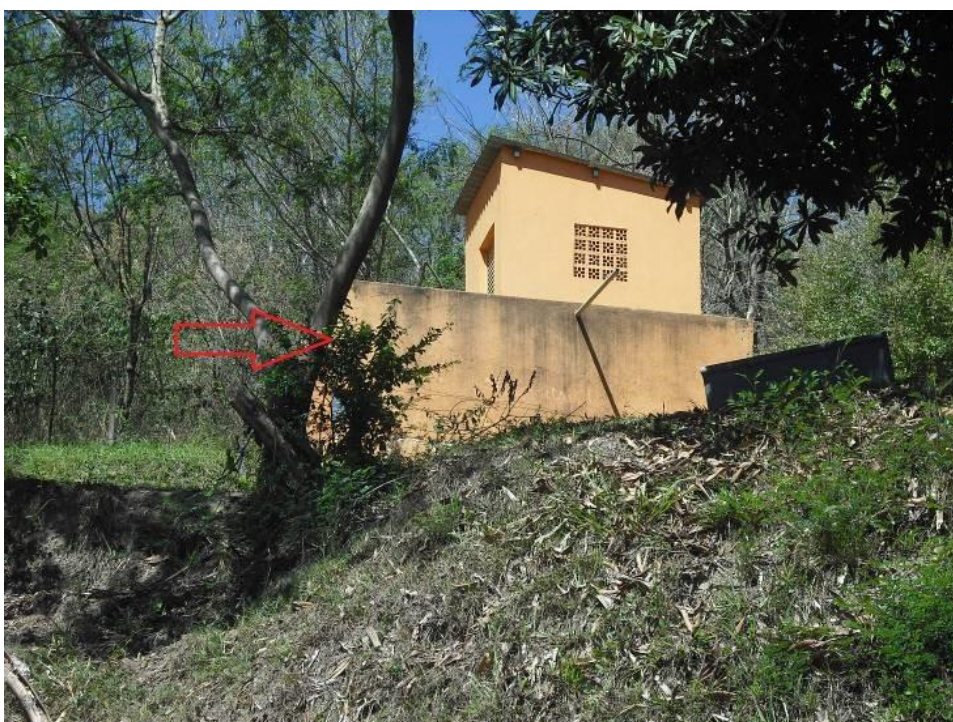
Vista do Reservatório R1
