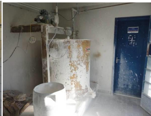
Tanque de preparo da Cal
