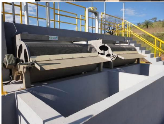
Vista da Calha Parshal e Medidor Ultrassônico
