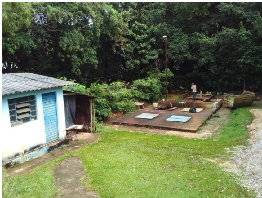
Estação Elevatória Final com recalque para a ETE
