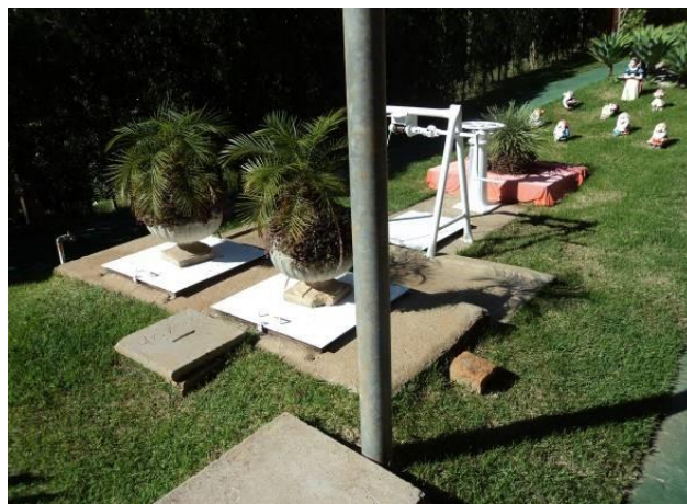
Vista geral da Elevatória Joaquim Carlos
