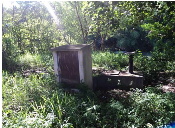
Vista geral da elevatória Creche Rotary Clube
