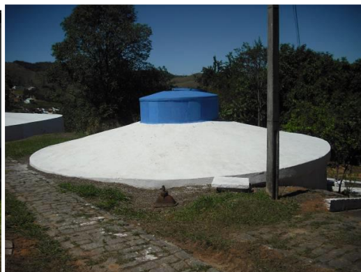
Vista do Reservatório R2
