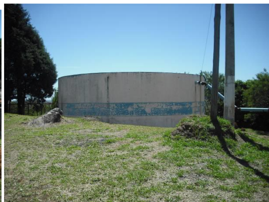
Vista do Reservatório R3
