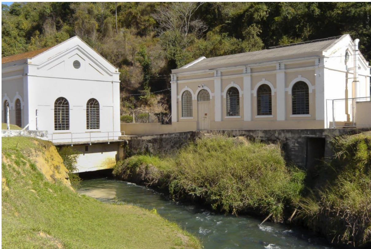
Usina Macaco Branco
