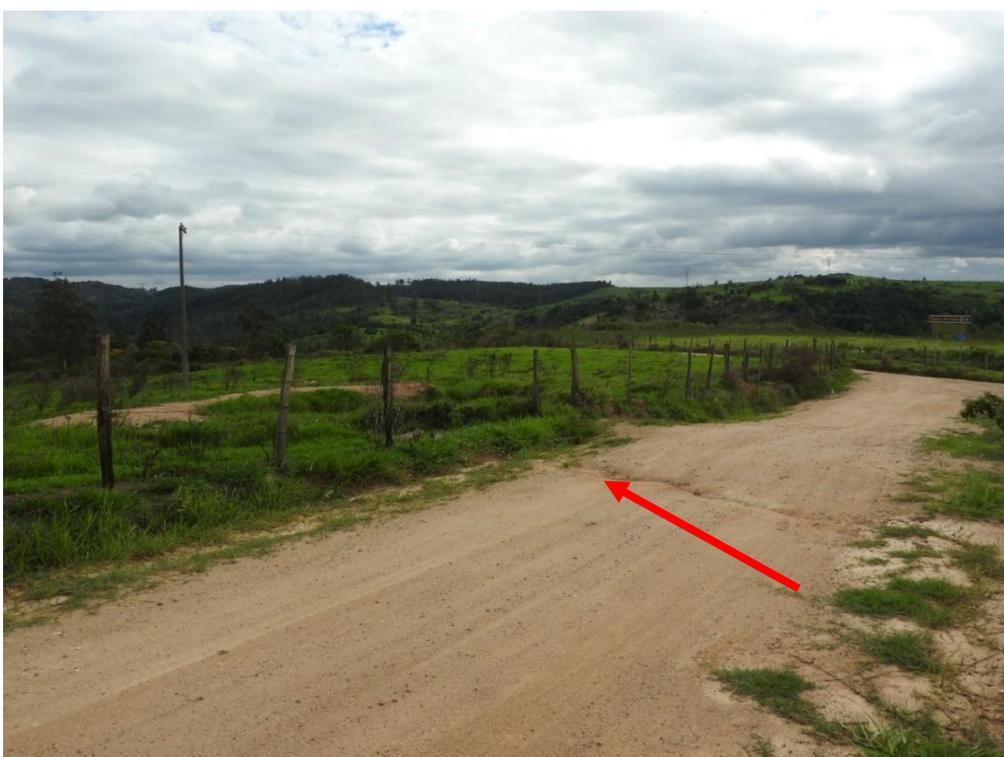
*Figura 8. Lombada direcionando a água para o bigode e por consequência para a caixa.*
