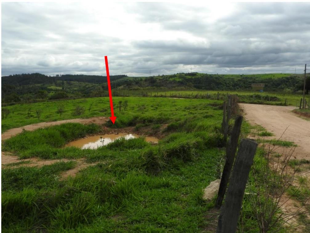
*Figura 9. Exemplo de caixa com vegetação na borda, associada a lombada e bigode.*
