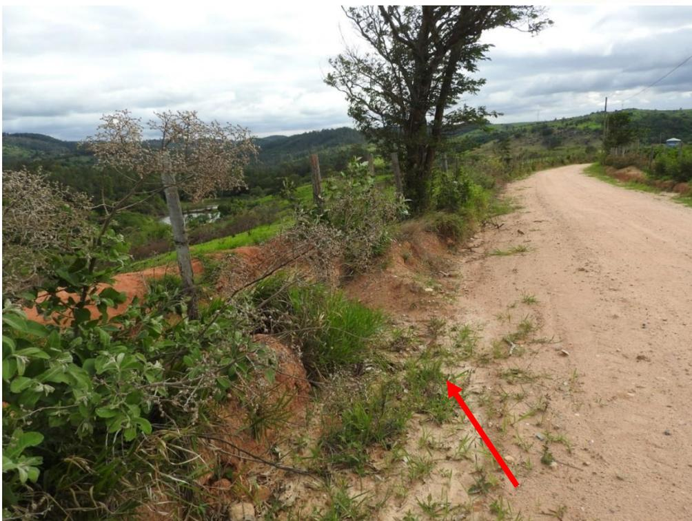
*Figura 7. Bigode que drena água do leito para a caixa*
