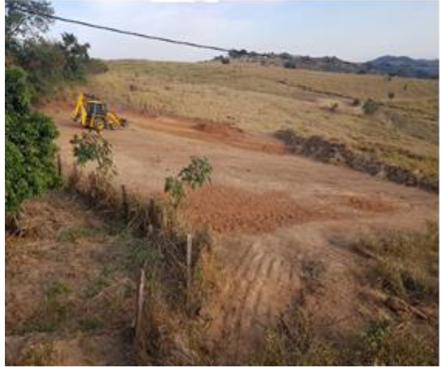
Platô para implantação de painéis fotovoltaicos
