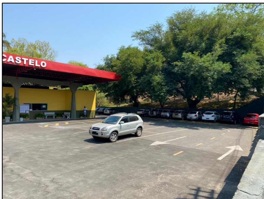
FIGURA 69 - Terminal Rodoviário Vereador João Castelo
