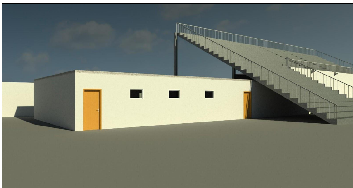
FIGURA 77 - Banheiro praça de eventos
