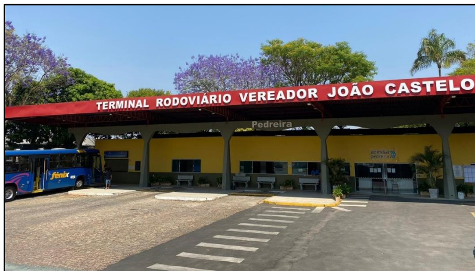
FIGURA 68 - Terminal Rodoviário Vereador João Castelo
