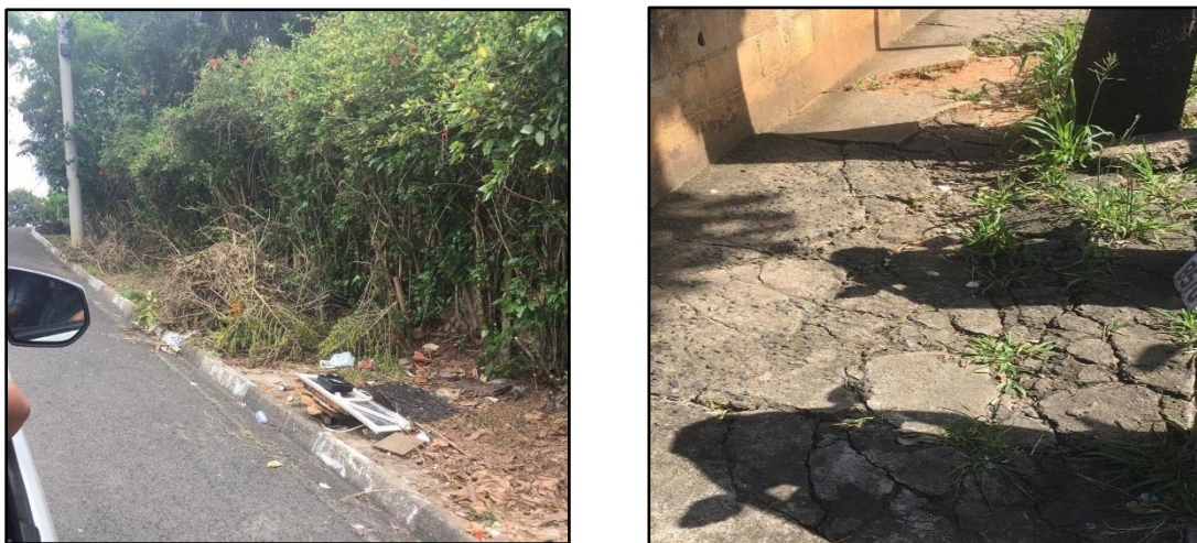
FIGURA 17 - Má conservação dos passeios e presença de entulho.
