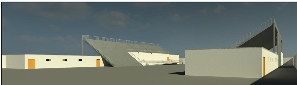
FIGURA 76 - Banheiro praça de eventos
