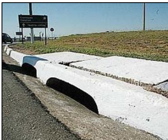
FIGURA 47 – Boca de lobo de guia.
