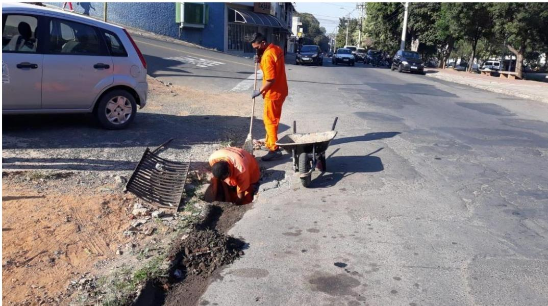
*Figura 3. Imagem mostrando os funcionários realizando limpeza do bueiro com pá e enxada e vassoura.*
