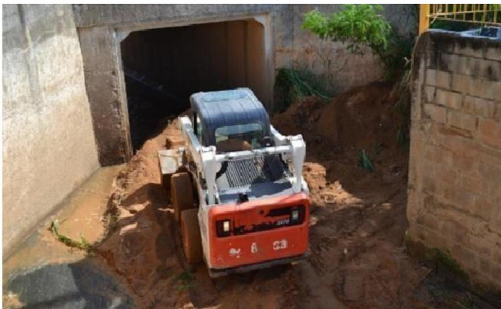
*Figura 6. Desassoreamento do Córrego com uso de máquinas.*
