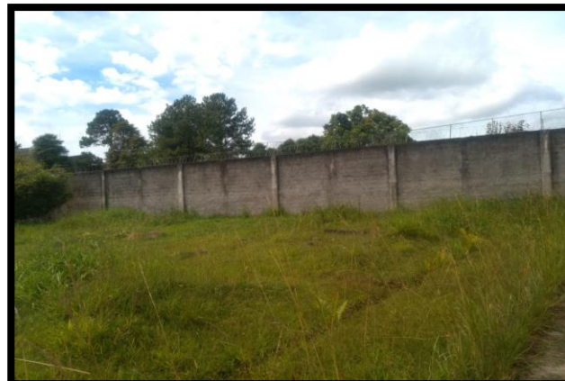
Foto 0.6 Pintura do muro.
