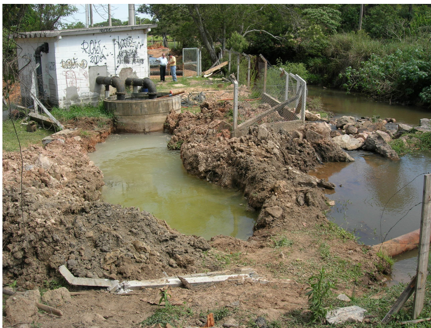
Figura 14 – Local da captação no córrego Caxambú
