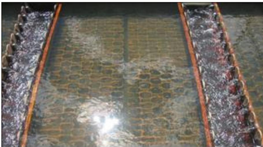
**Figura 19 – Decantador e canaleta de coleta de água decantada**
