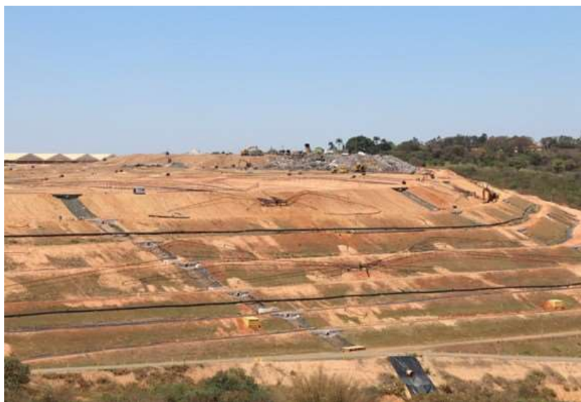
Figura 5.3-1: Aterro sanitário Orizon, no município de Paulínia/SP
