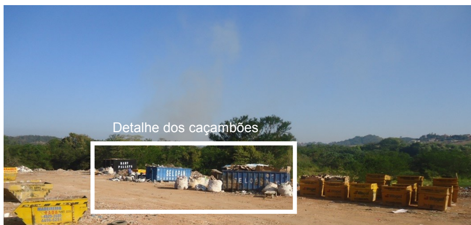
Figura 40 - Área destinada à triagem dos resíduos de construção civil: detalhe dos caçambões.
