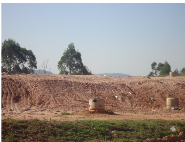
Figura 30 - Queima de gases no Aterro Sanitário Municipal, em Itupeva.
