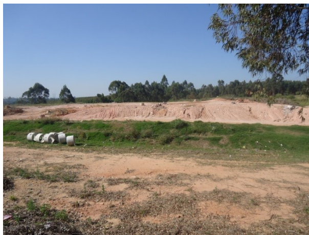
Figura 27 - Vista do Aterro Sanitário Municipal, em Itupeva.
