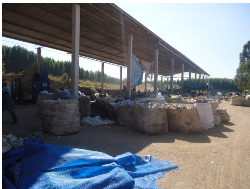
Figura 34 - Visão lateral da Cooperativa de Reciclagem de Itupeva – CRI.
