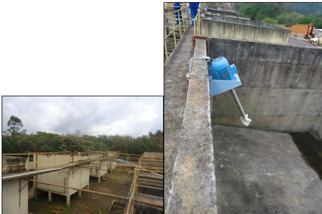
Figura 36 - Decantadores Secundários (Esquerda) Decantador Secundário Vazio (Direita)
