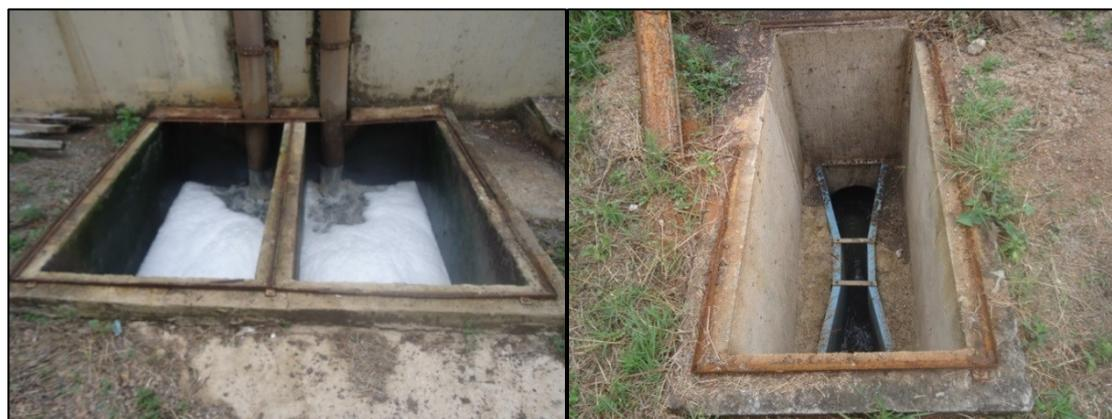
Figura 37 - Saída do Esgoto Tratado (Esquerda) e Calha Parshall de saída (Direita) – ETE
