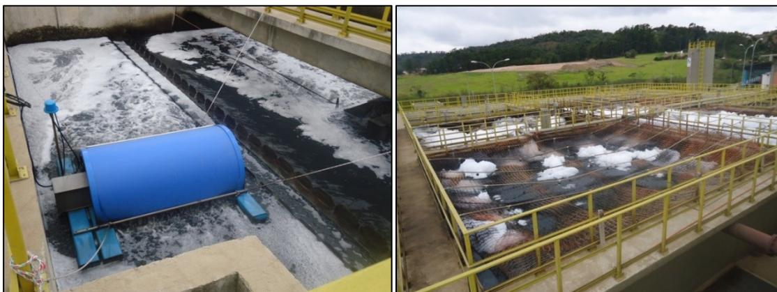
Figura 29 - Vista superior do filtro anaeróbio com aerador superficial (Esquerda). Filtro aeróbio submerso (Direita) – ETE Nica Preta
