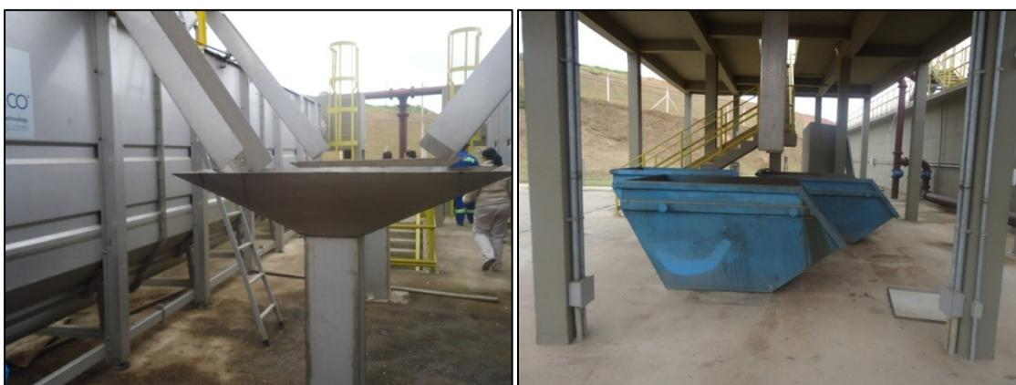
**Figura 27 - Canaleta de resíduos da peneira e caixa de areia (Esquerda). Caçamba de coleta dos resíduos sólidos (Direita) – ETE Nica Preta**
