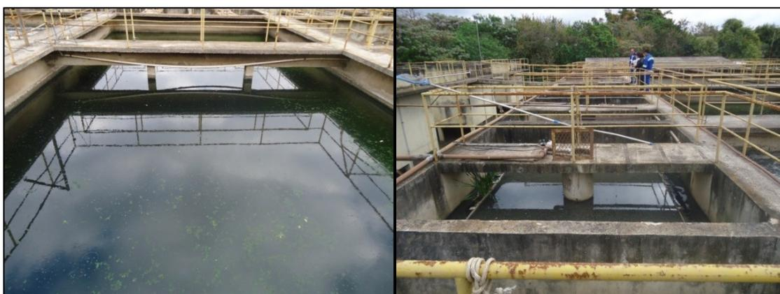
Figura 35 - Tanque de Aeração – sem aerador – ETE Rio das Pedras
