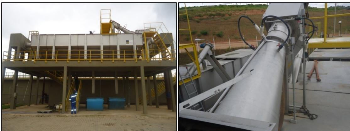
**Figura 26 - Vista Geral do Peneiramento e caixa de areia mecaniza (Esquerda). Vista parcial da peneira e caixa de areia (Direita) – ETE Nica Preta**
