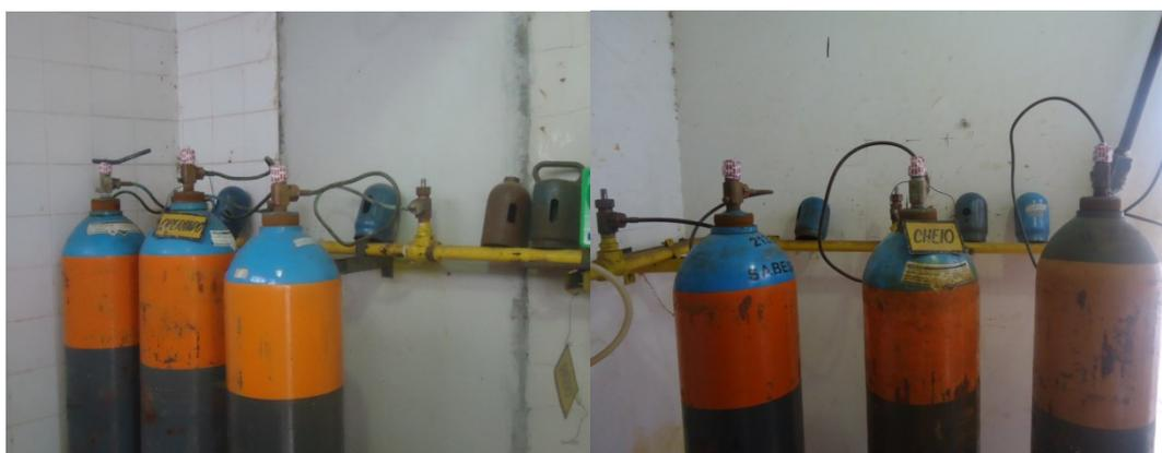
**Figura 43 - Cilindros de gás cloro**
