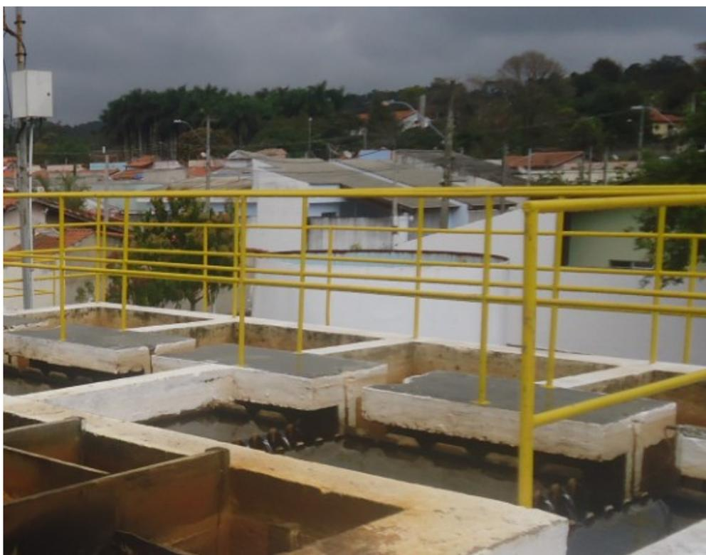
Figura 36 - Filtros retangulares de 1 (um) dos módulos
