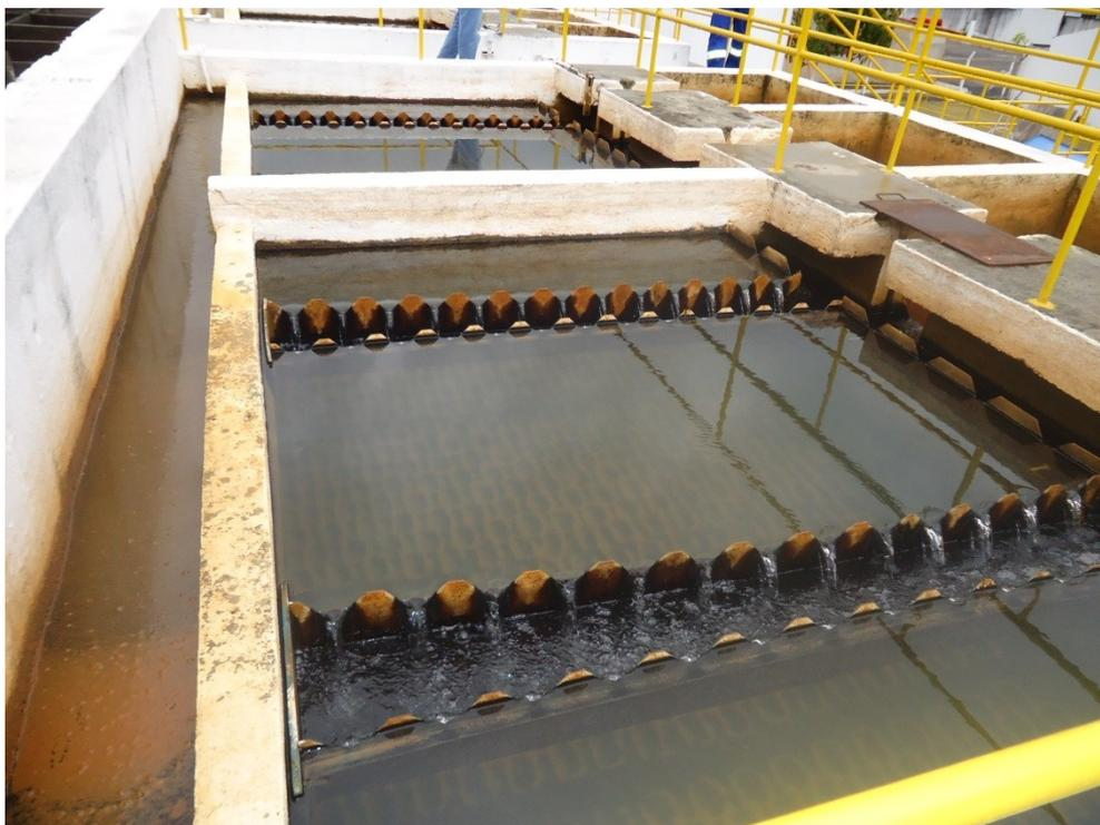
Figura 35 - Decantadores de 1 (um) dos módulos
