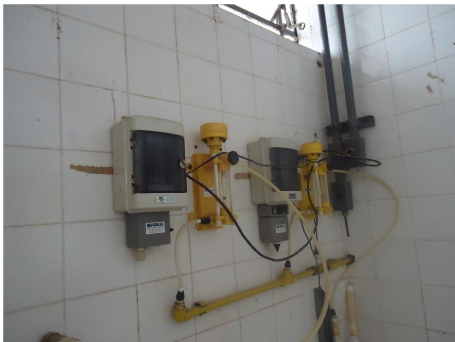
Figura 41 - Bombas de arraste de cloro em operação e reserva
