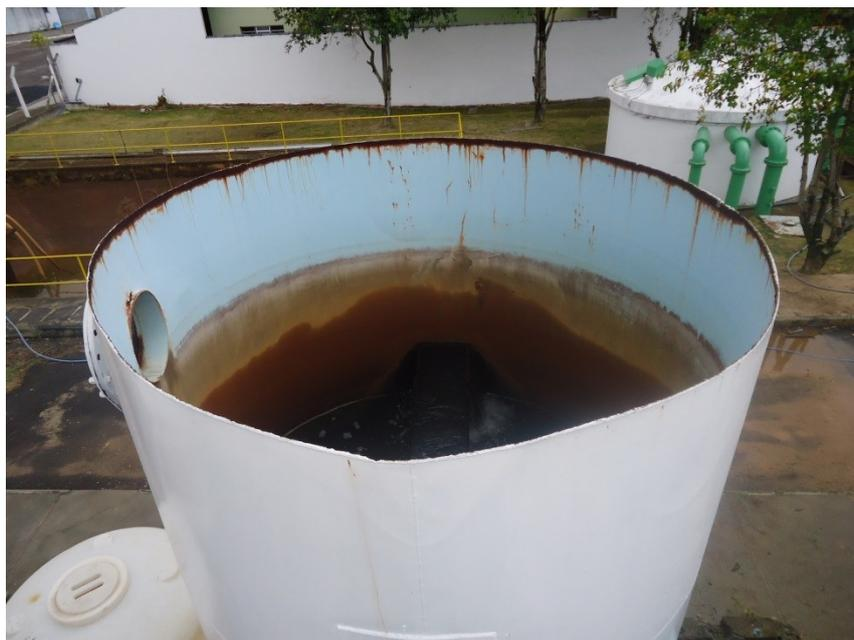
**Figura 37 - Filtro complementar de um dos módulos**
