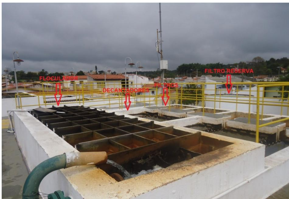
Figura 33 - Um dos módulos de tratamento de água
