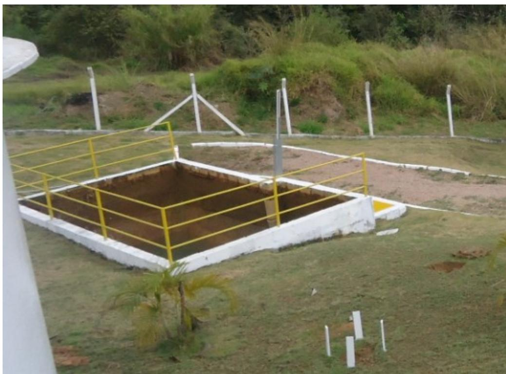
**Figura 46 - Tanques de reuso**
