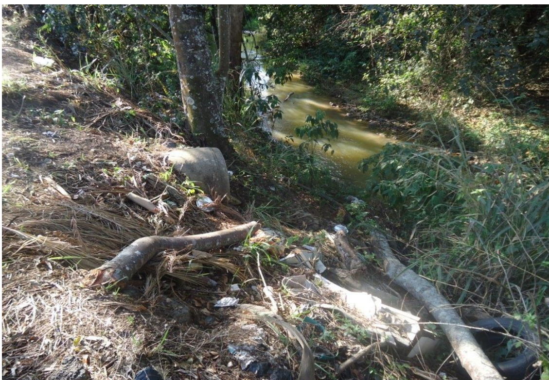
Figura 52 - Saída de água sem dissipador de energia – Ribeirão São José (Ponto O).
