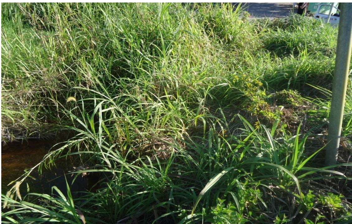
Figura 49 - Boca de lobo encoberta pela vegetação (Ponto N)
