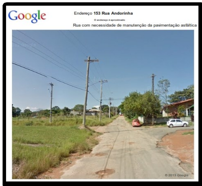
Figura 21 - Rua Andorinha - exemplo de necessidade de manutenção da pavimentação
