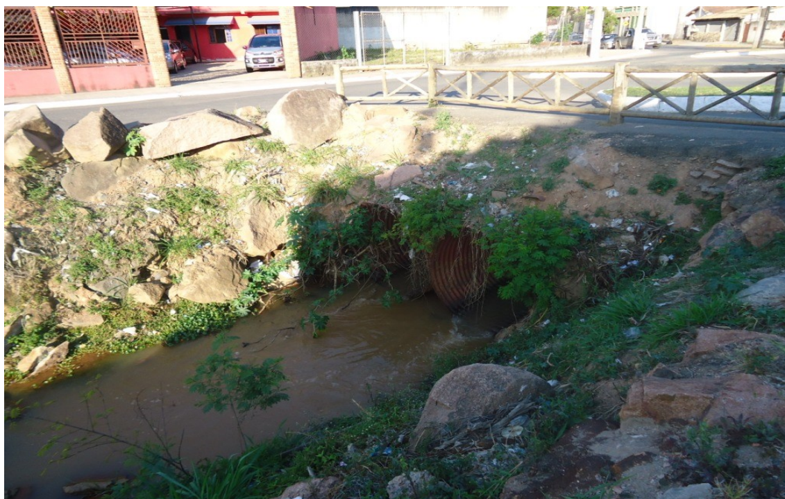
Figura 28 - Ponto de alagamento do Córrego da Lagoa (Ponto B).
