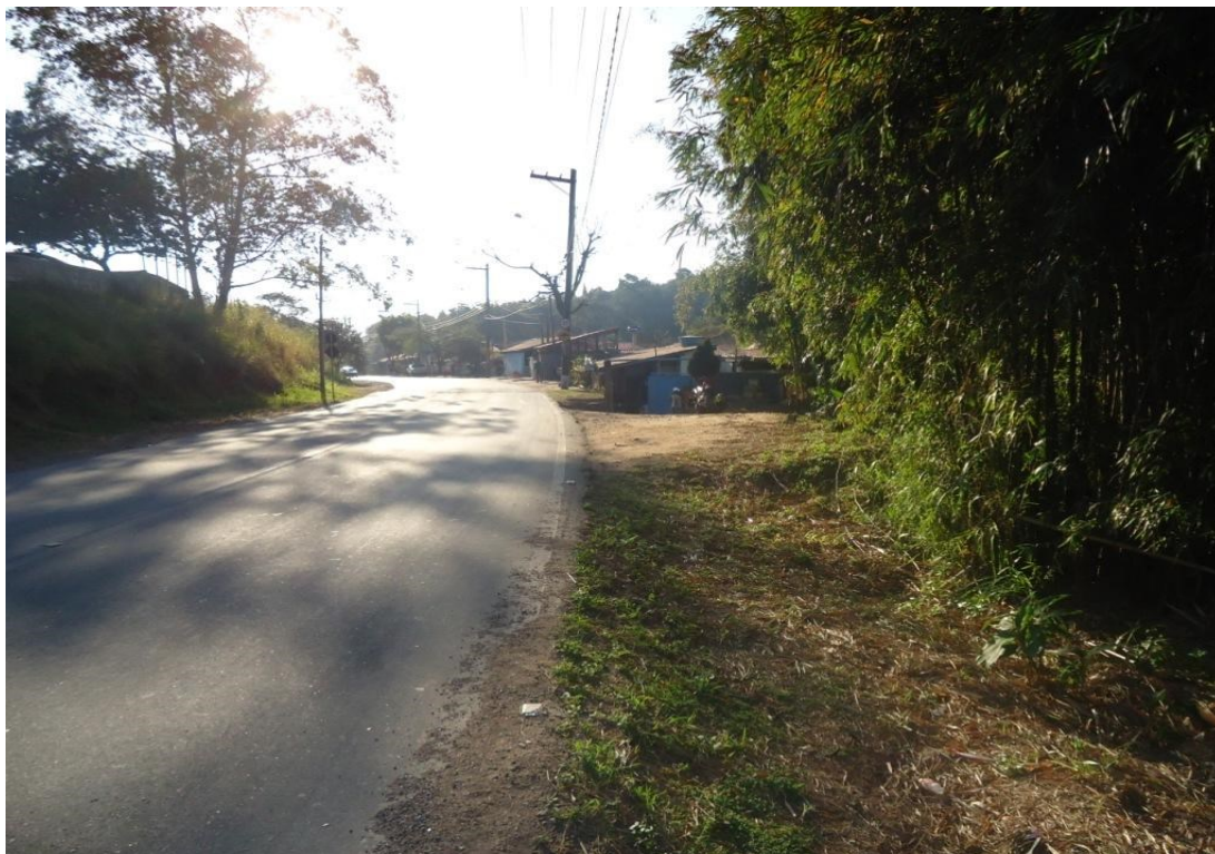
Figura 61 - Ocupação irregular de APP – Rio Jundiá (Ponto T)
