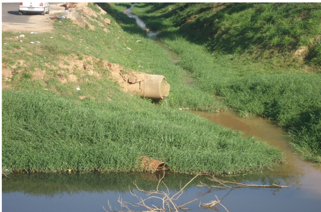
Figura 54 - Saída de água sem dissipador – Córrego da Lagoa (Ponto Q).
