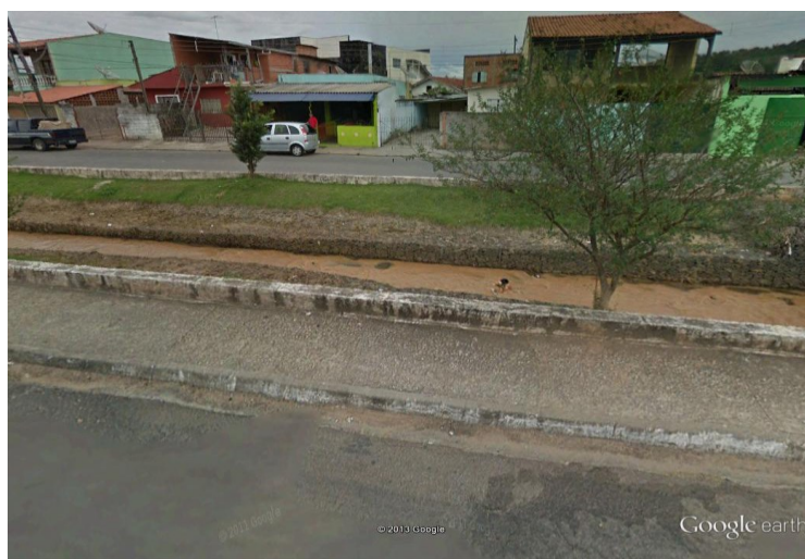
Figura 41 - Assoreamento do Córrego da Lagoa.
