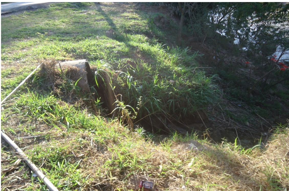
Figura 53 - Erosão causada pela saída de água sem dissipador – Rio Jundiáí (Ponto P)
