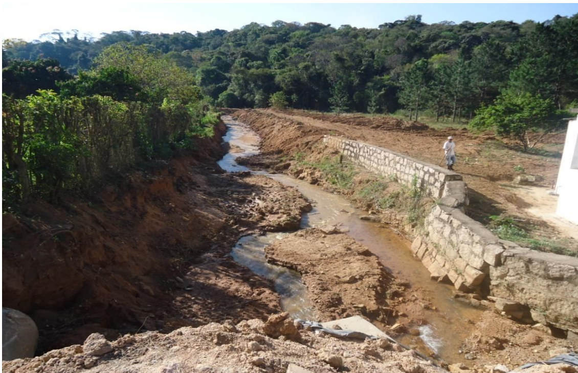
Figura 36 - Guacuri – Obra de alargamento da tubulação (Ponto J)
