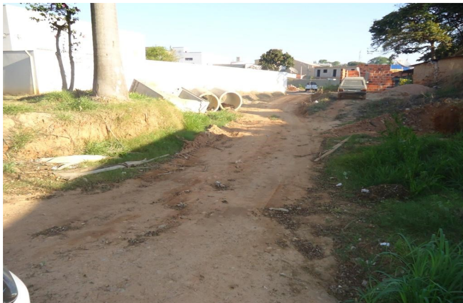
Figura 31 - Ponto alagamento do Córrego do Bonfim canalizado (Ponto E).
