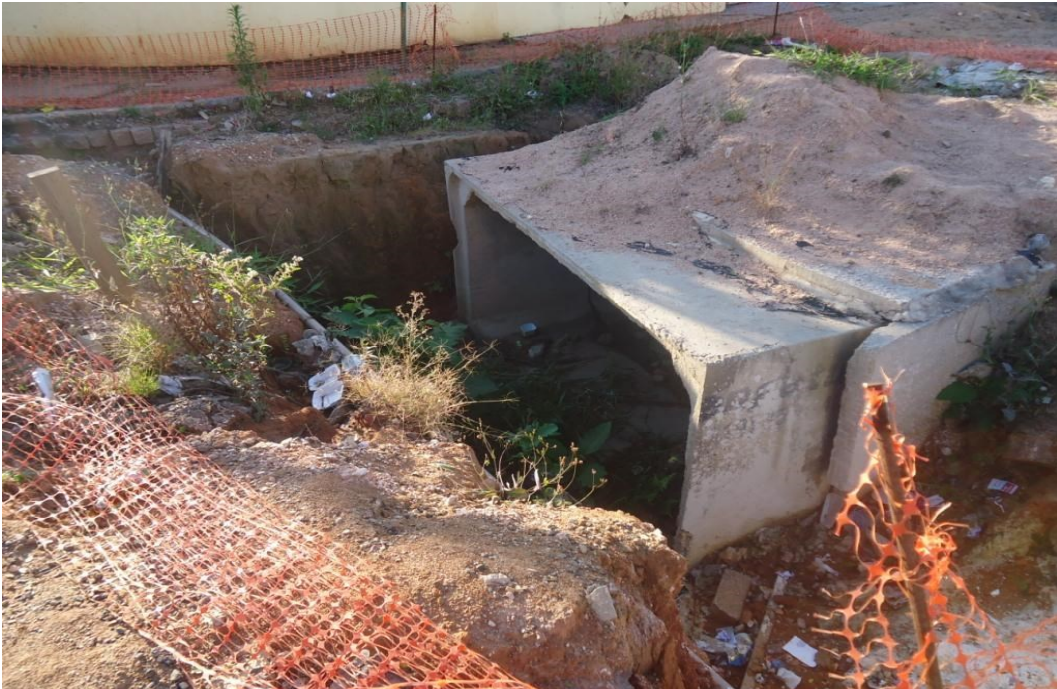
Figura 33 - Obra de alargamento do canal Córrego do Bonfim (Ponto G).
