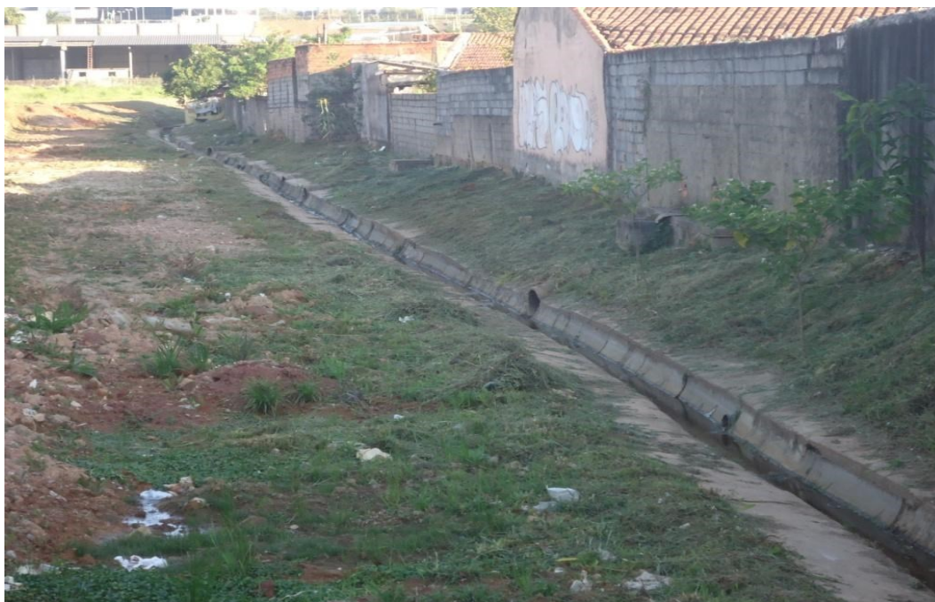
Figura 57 - Lançamentos clandestinos de esgoto – Próximo à Av. Emílio Chechinatto (Ponto R)
