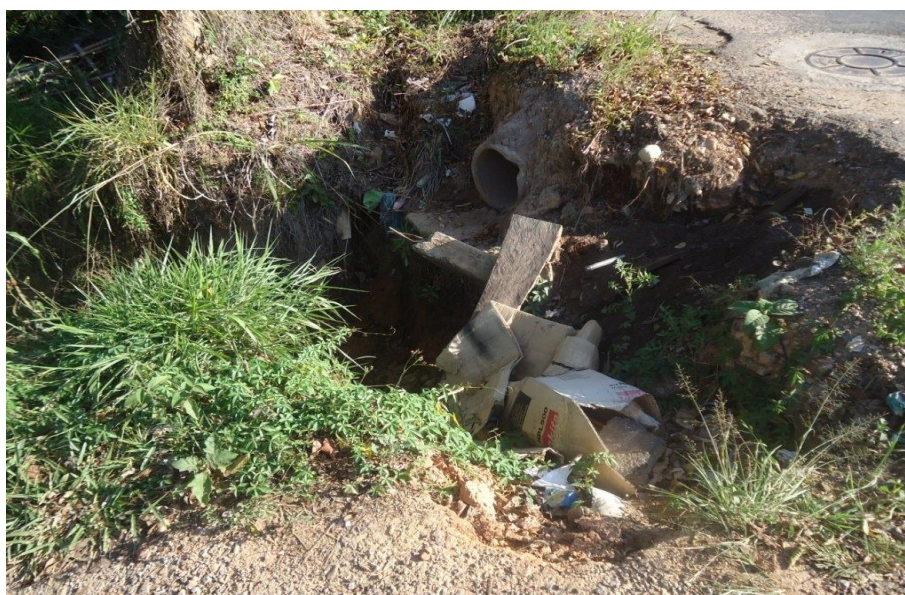
Figura 47 - Boca-de-lobo sem limpeza e manutenção (Ponto L).
