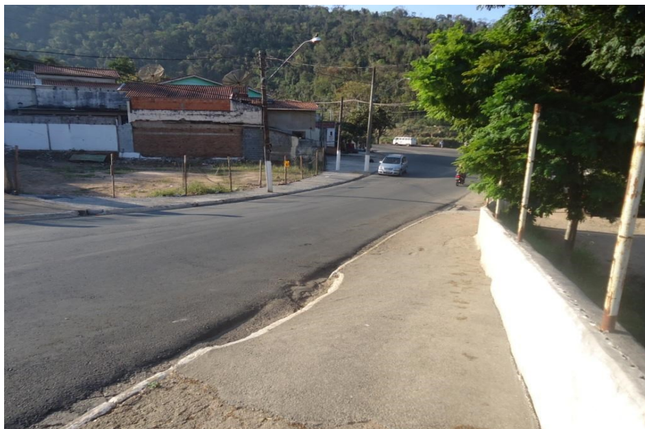
Figura 32 - Ponto alagamento do Córrego do Bonfim canalizado (Ponto F).
