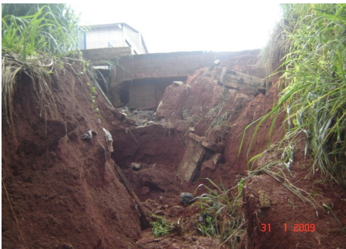
Figura 42 - Erosão na região da estrada Vale das Pedras .
