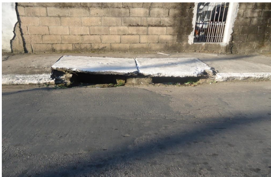
Figura 46 - Boca-de-lobo sem manutenção (Ponto K).
