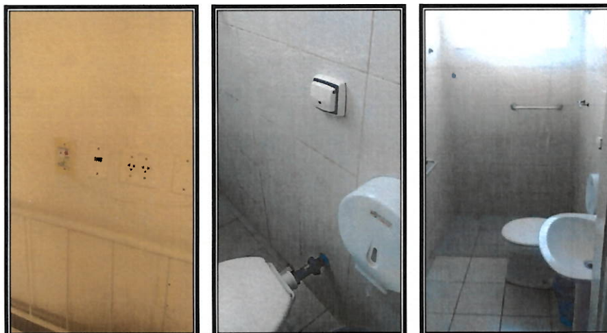
47. Ambiente, hidráulica – quarto 5, quarto 4
