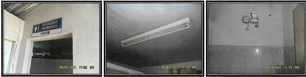
68. Instalação, ambiente – Vestiário feminino
