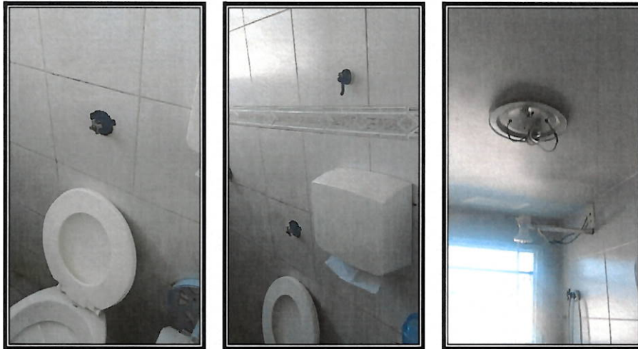
51. Ambiente, hidráulica – quarto 6
