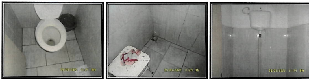
71. Ambiente, instalação – Vestiário feminino
