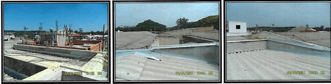
85. Instalação, SPDA – cobertura
