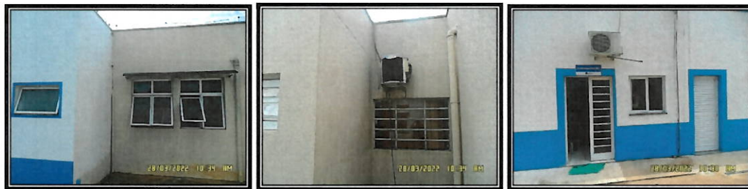
86. Ambiente, instalação – área externa
