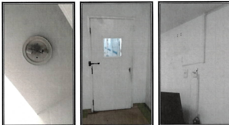
19. Iluminação, ambiente – banheiro, acesso e conforto médico
