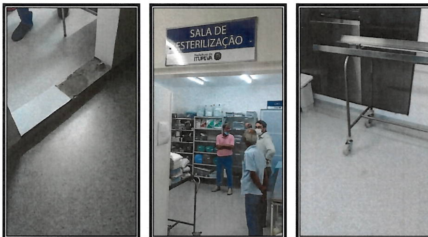
34. Ambiente, Ar condicionado – sala de materiais e equipamentos, sala de esterilização
