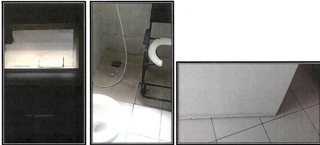
46. Ambiente, hidráulica – quarto 5
