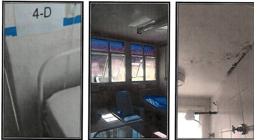
48. Ambiente, hidráulica – quarto 4, quarto 7
