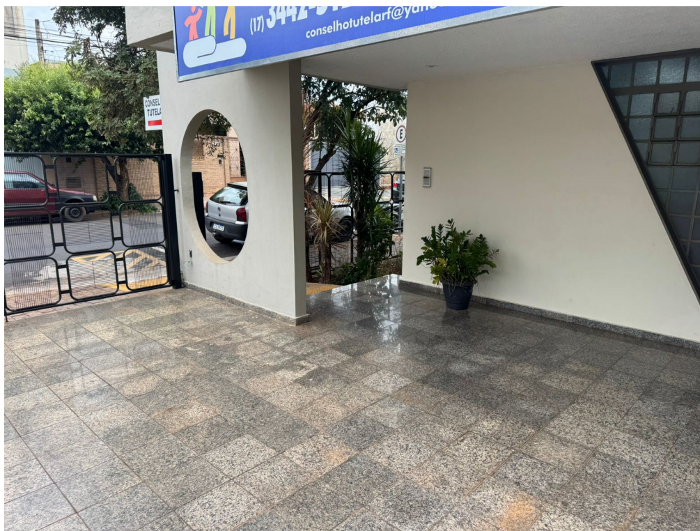
FOTO 03: Entrada do Imóvel (23/01/2026)
