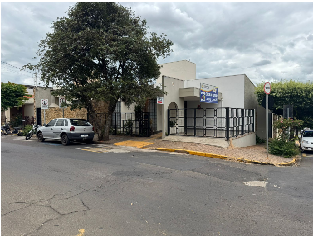
FOTO 01: Fachada do Imóvel – Rua Rio Grande do Sul (23/01/2026)
