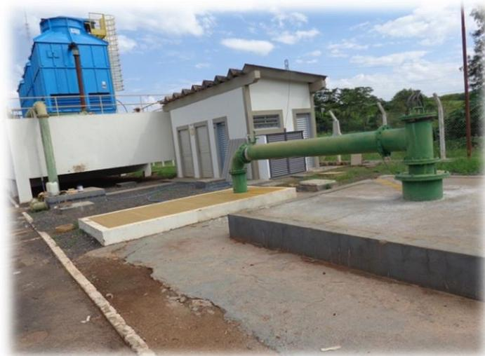
Em virtude das temperaturas de extração das Águas do Aquífero Guarani (vide Quadro 17), os quatro poços tubulares profundo possuem unidades de resfriamento que recebem água quente dos poços, e por meio de dispersão da água e através do fluxo de ar externo, ocorre a troca térmica e evaporação, retirando calor da água. Esta operação é necessária, para evitar rupturas na rede de distribuição e conseqüente paralização do sistema.
