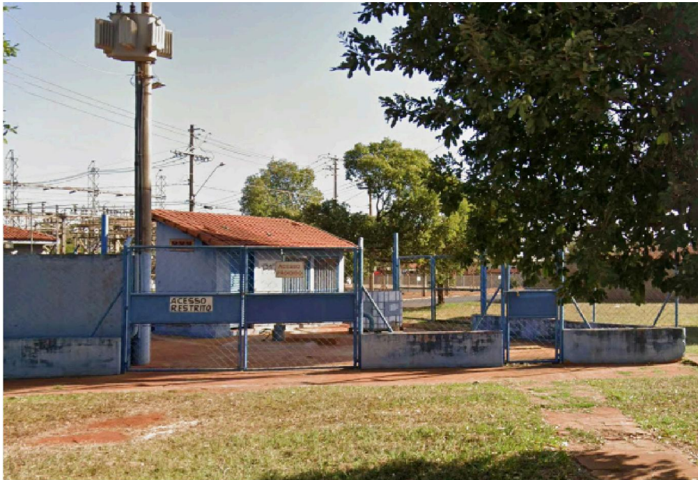
FIGURA 6 – POÇO 02 (RUA LUIS MOURA)
