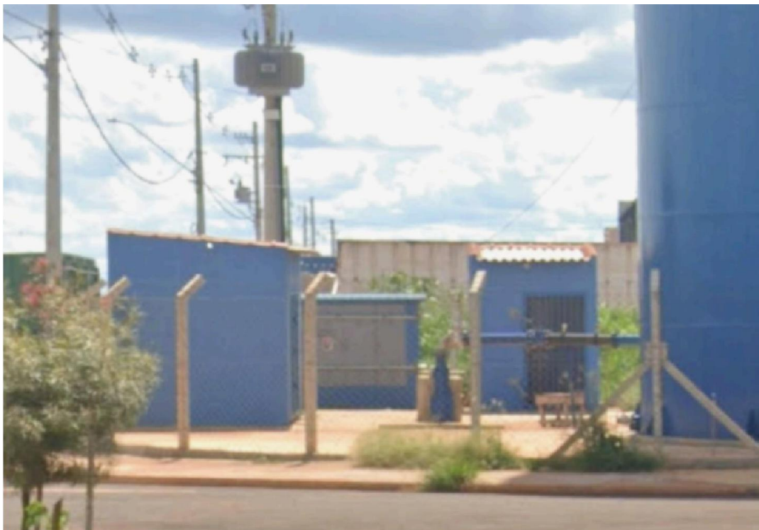
FIGURA 7 – POÇO 31(JARDIM CÉSAR RAVAGNANI)
