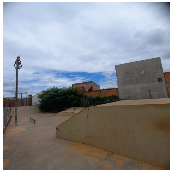
Foto 2 – Postes de Iluminação Existentes
