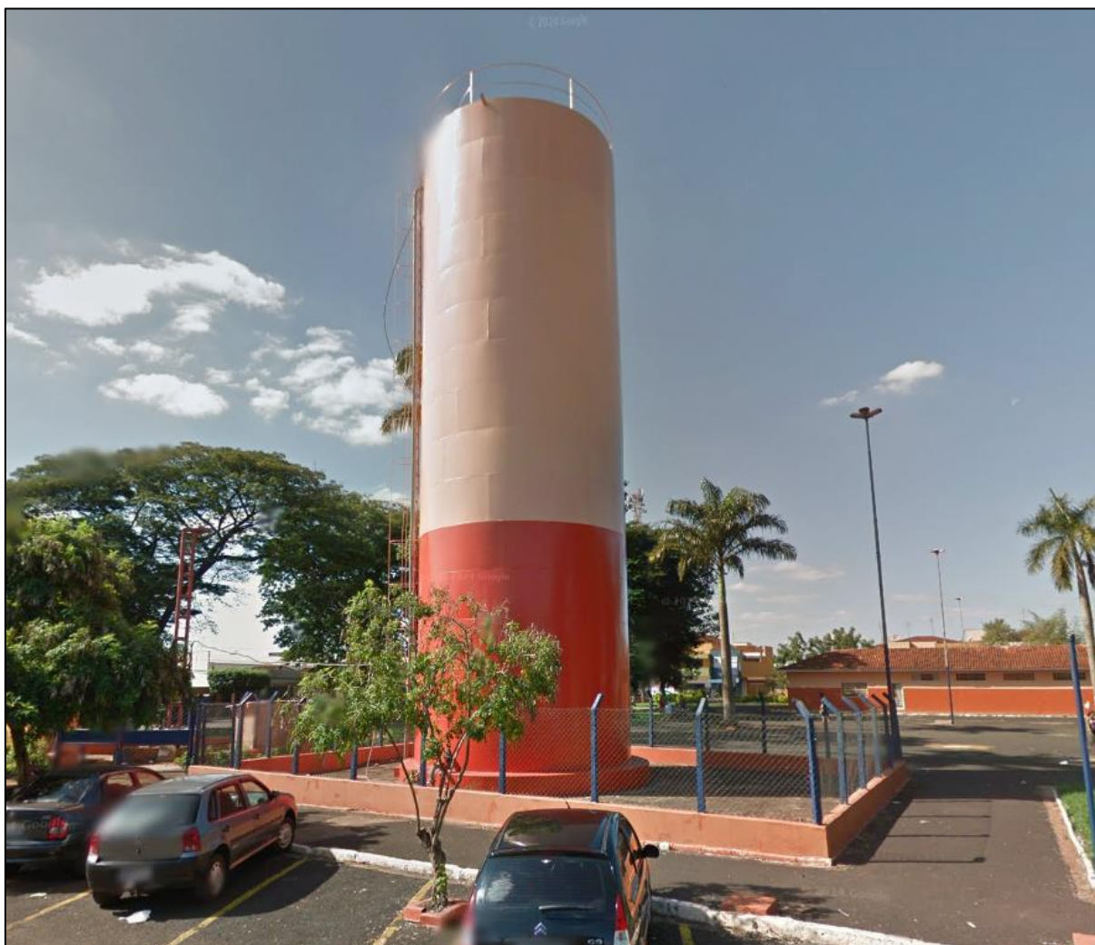
Figura 49 – Reservatório R 03 – Rua João dos Reis, s/n.
