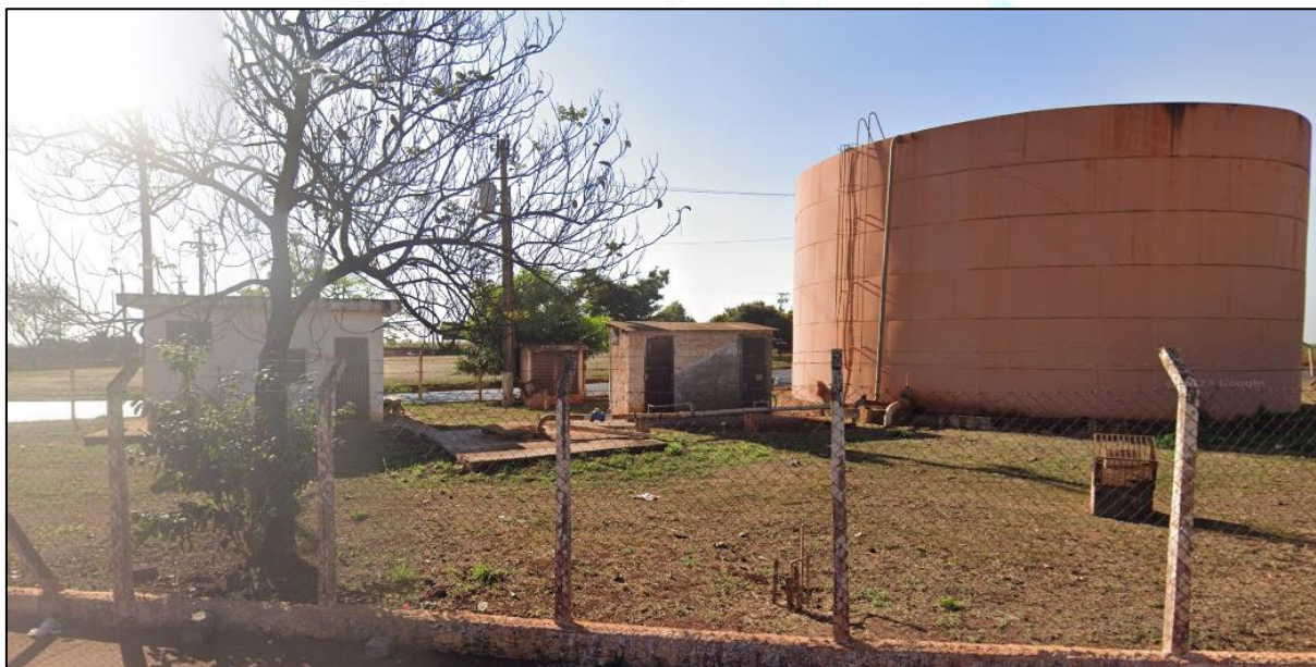
Figura 39 – Poço P 23 – Rua Rui Barbosa, s/n.
