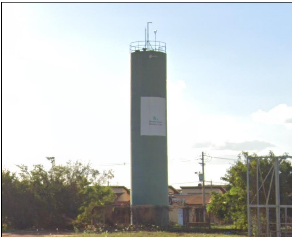
Figura 58 – Reservatório R 15 – Rua E, Bairro Morada Pontal.
