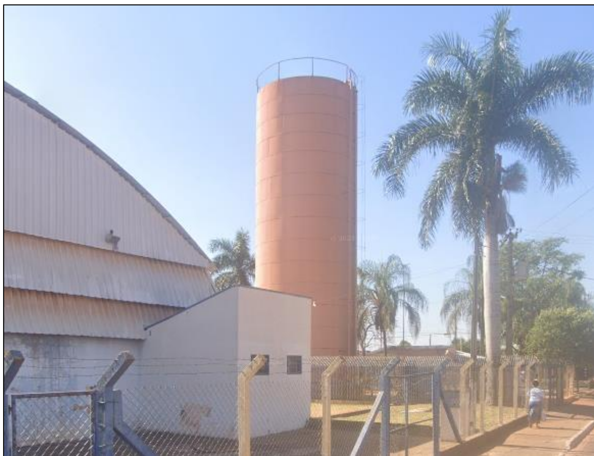
Figura 55 – Reservatório R 12 – Rua Ângelo Bazan, s/n.
