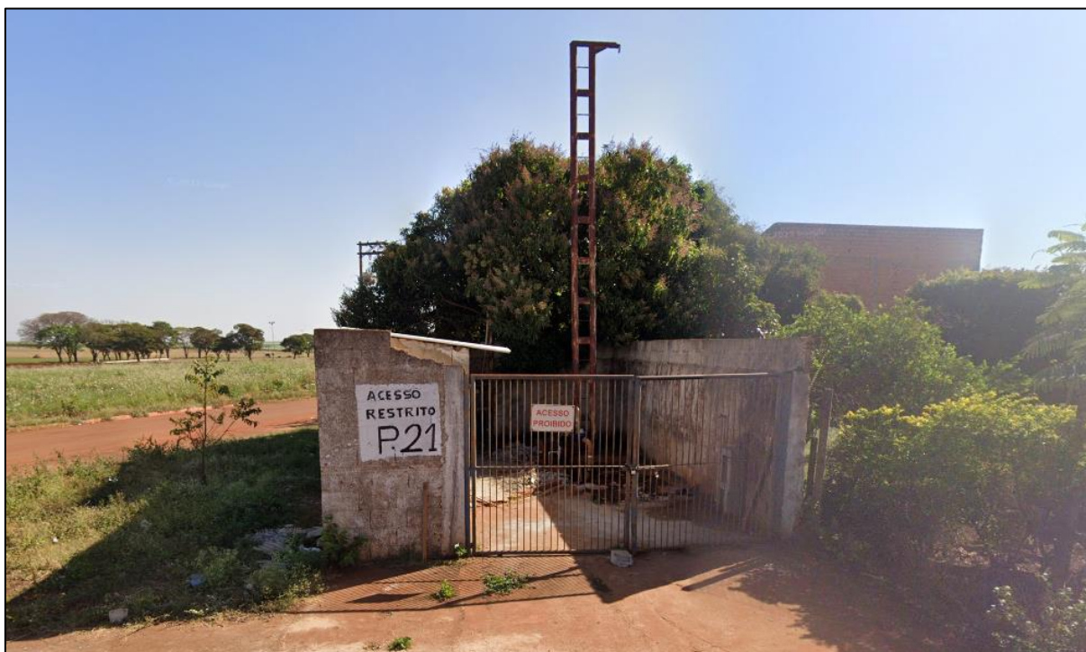
Figura 37 – Poço P 21 – Rua Caramuru, nº 1.051.
