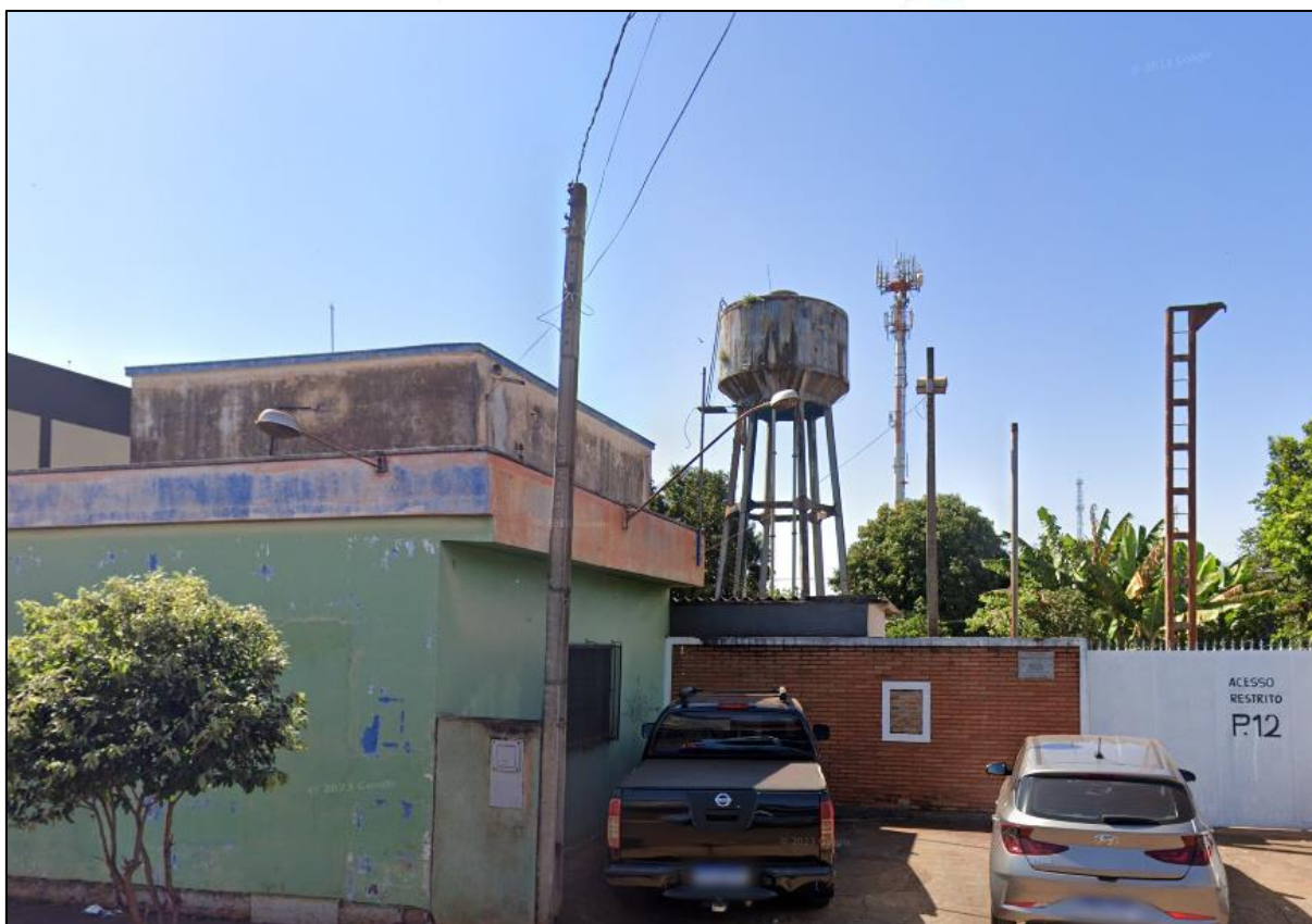
Figura 50 – Reservatório R 06 – Rua Guilherme Silva - DAE.
