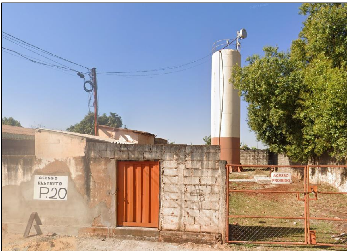
Figura 52 – Reservatório R 09 – Rua Caramuru, nº 429.
