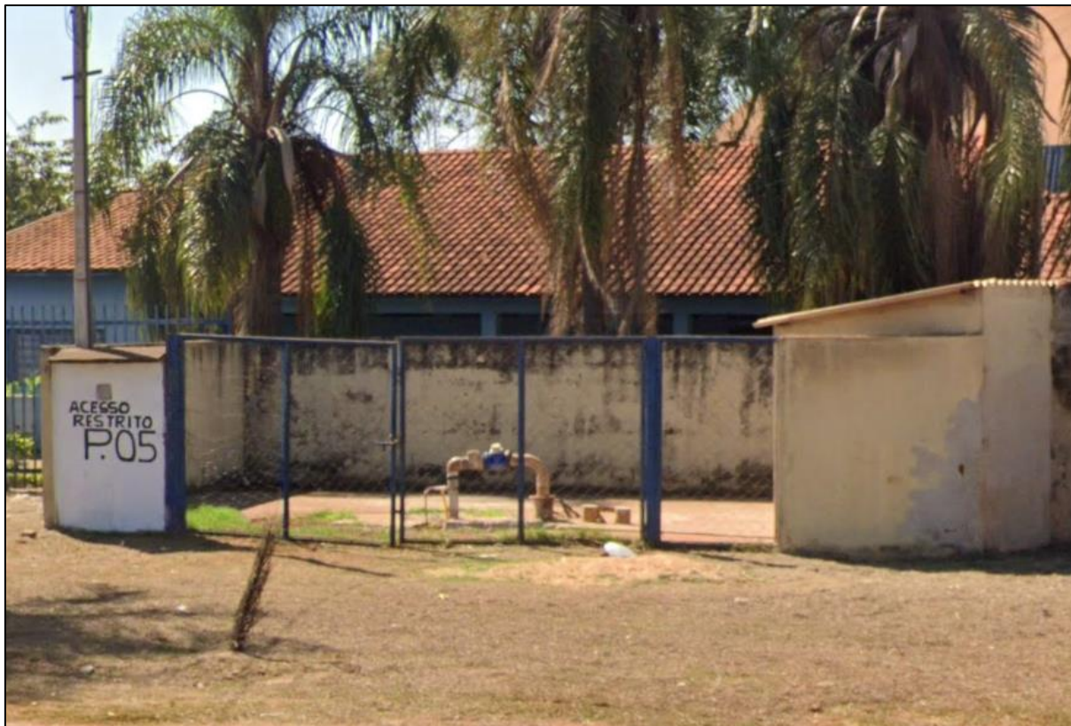
Figura 23 – Poço P 05 – Rua Henrique L. Maranhão, nº 33.
