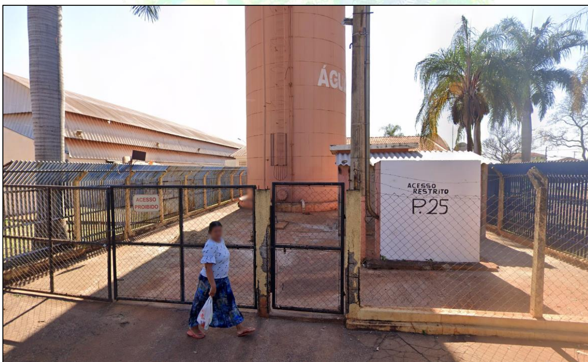
Figura 40 – Poço P 25 – Rua Ângelo Bazan, s/n.
