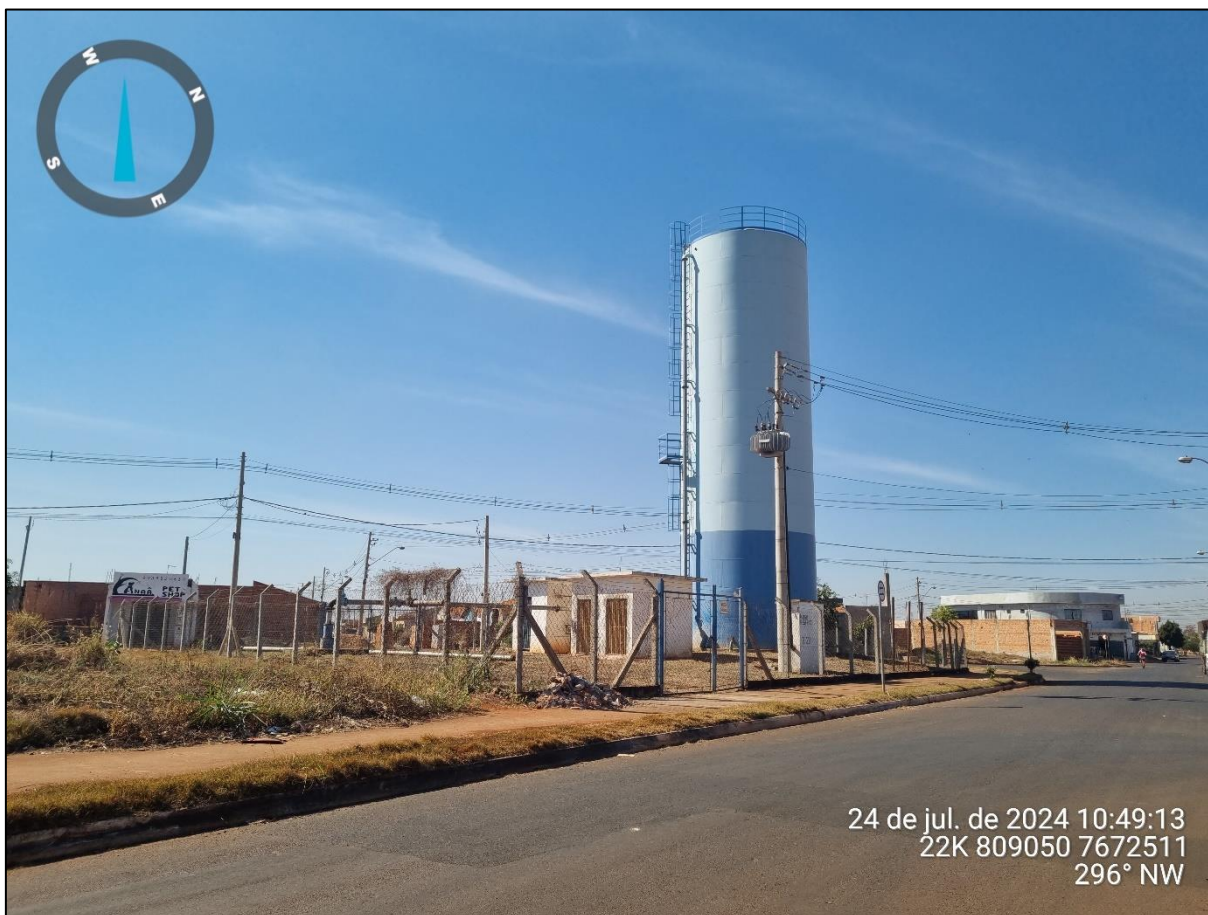
Figura 44 – Poço P 29 – Rua José P. Lourenço, s/n.
