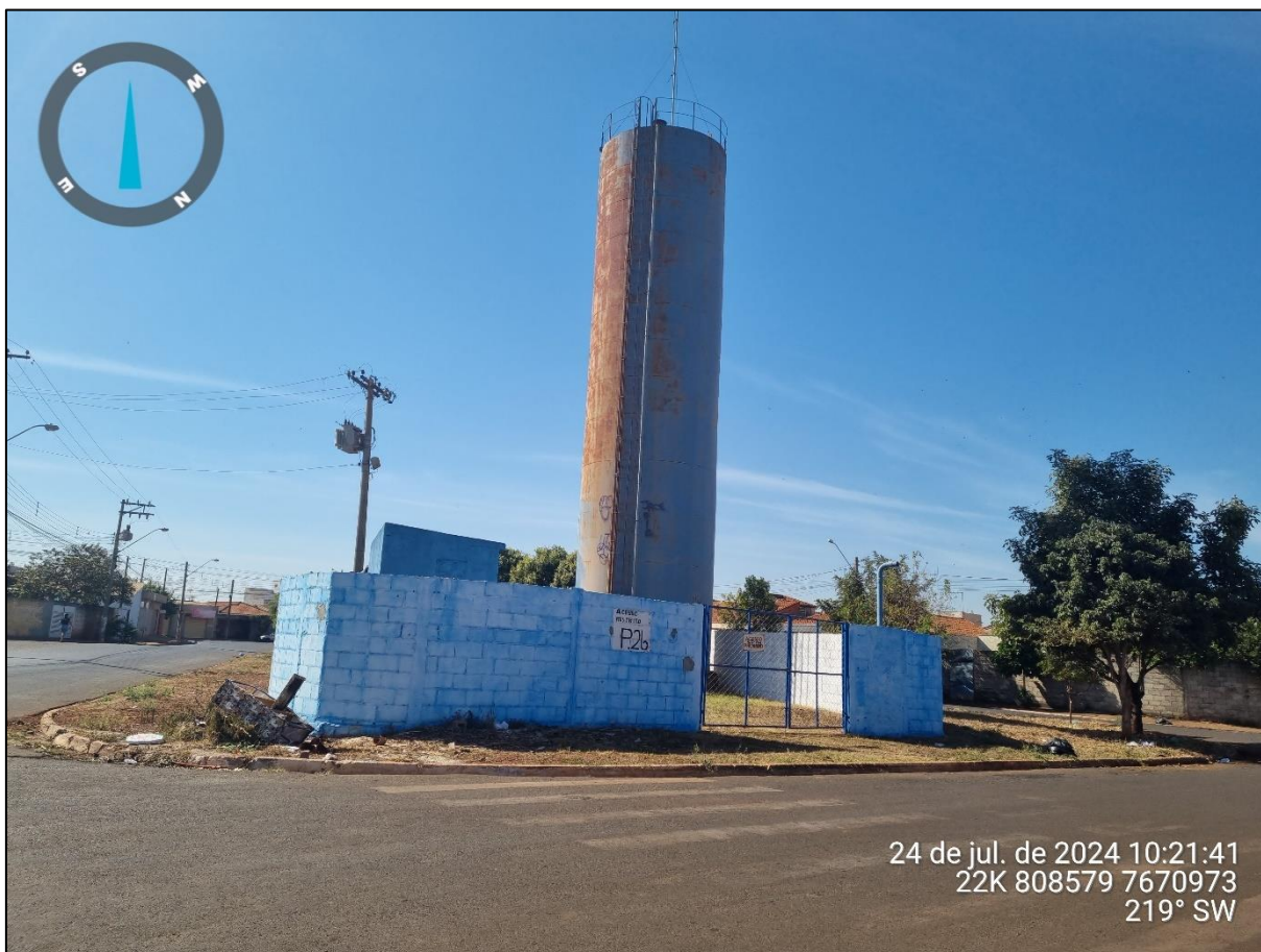
Figura 56 – Reservatório R 13 – Rua João Pugim, s/n.
