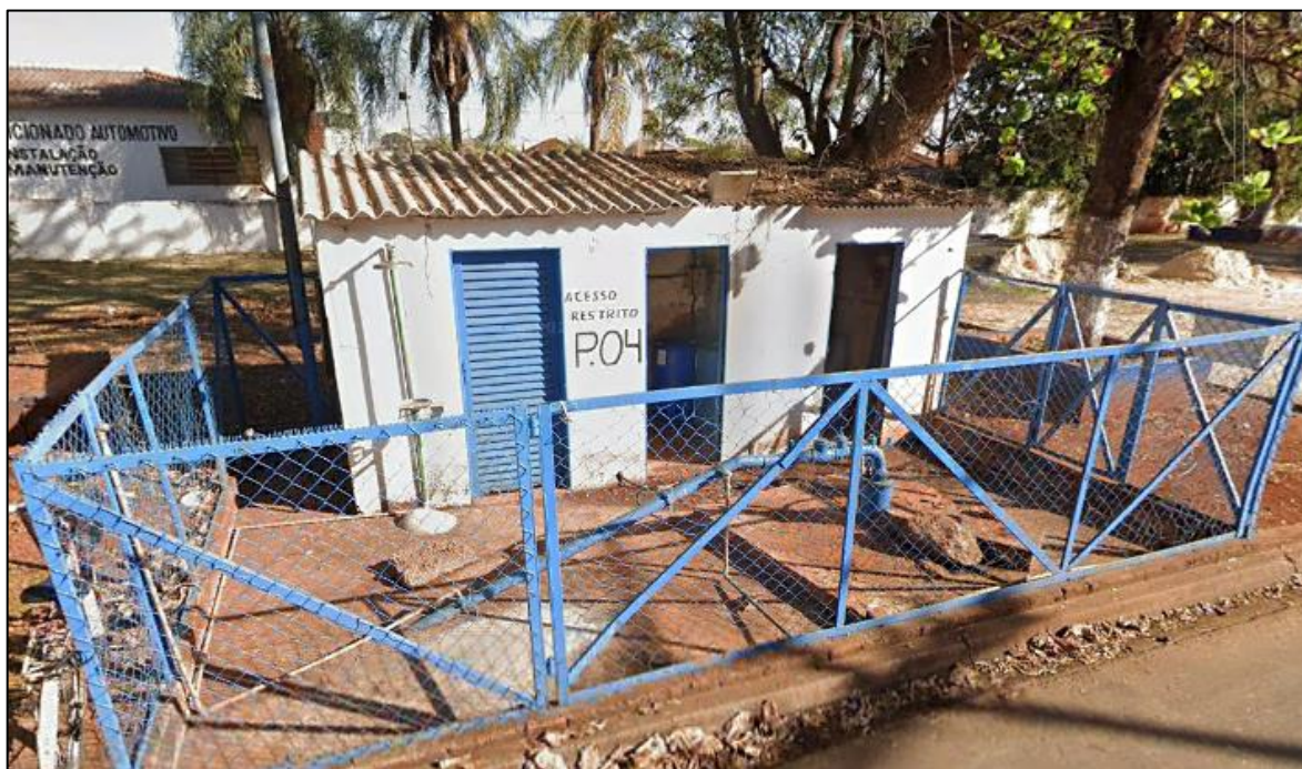
Figura 22 – Poço P 04 – Rua Vicente Venna, nº 33.
