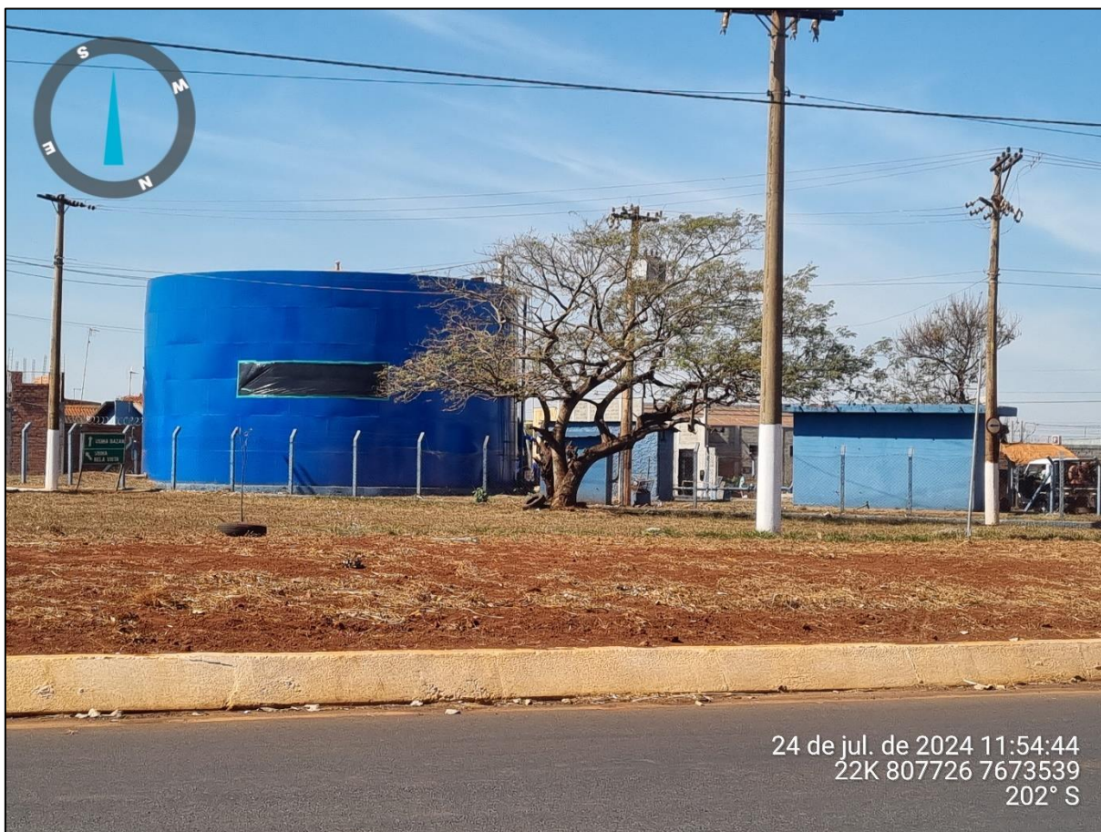
Figura 54 – Reservatório R 11 – Rua Rui Barbosa, s/n.
