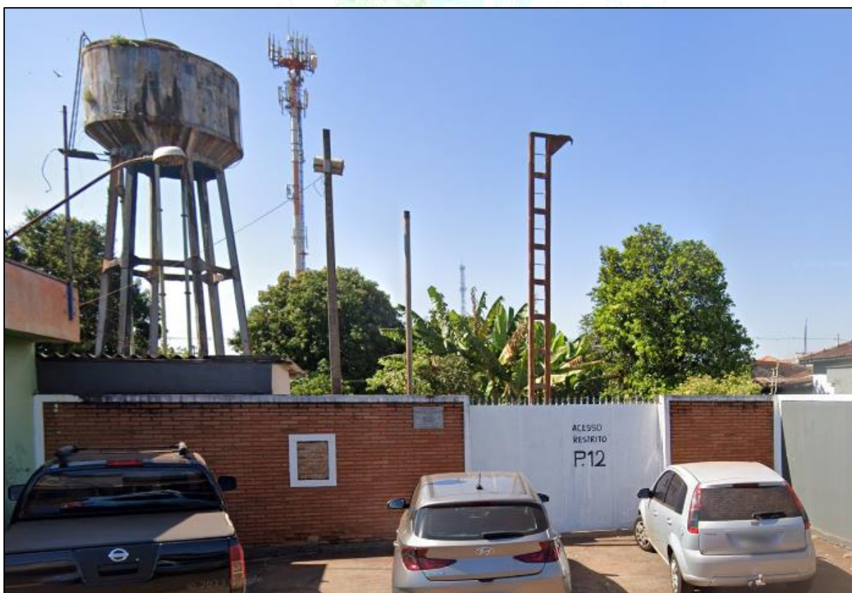
Figura 30 – Poço P 12 – Rua Ananias C. Freitas, nº 587 - DAE.
