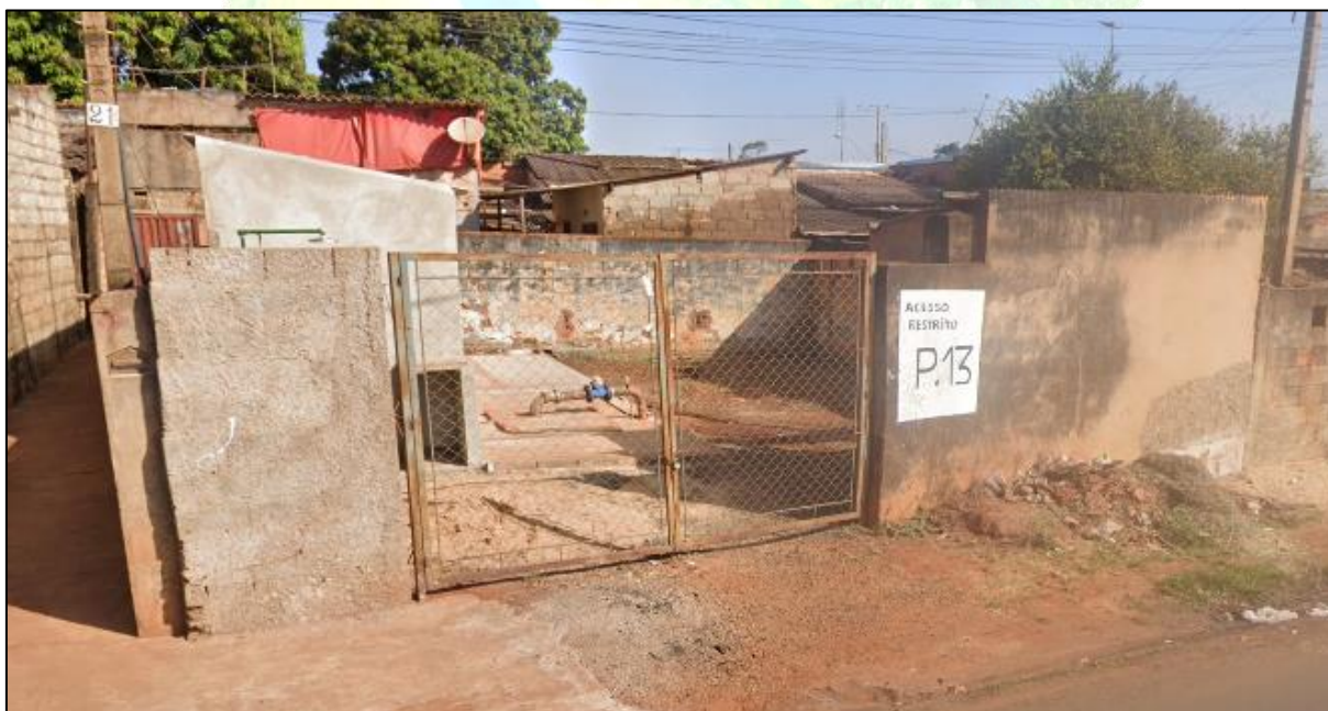
Figura 31 – Poço P 13 – Rua José Murad, s/n.
