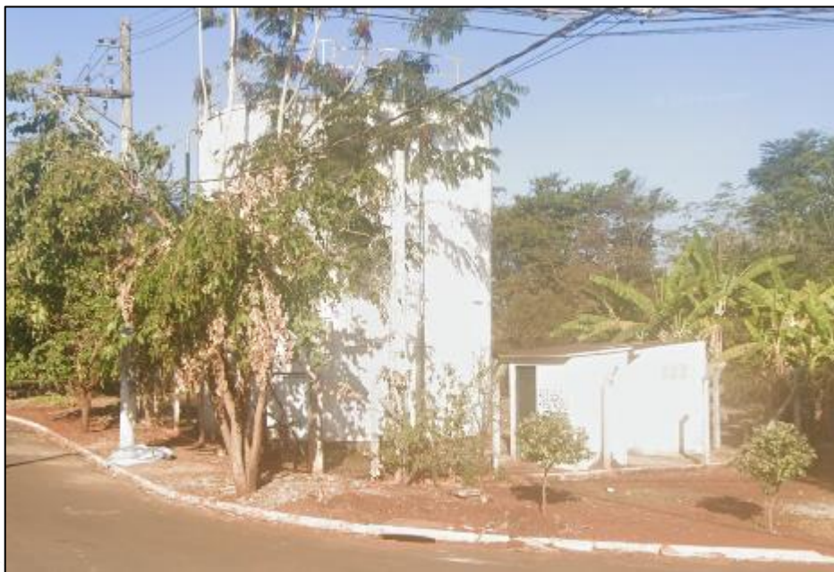
Figura 57 – Reservatório R 14 – Alameda Geraldo Isaías Ferreira, s/n.
