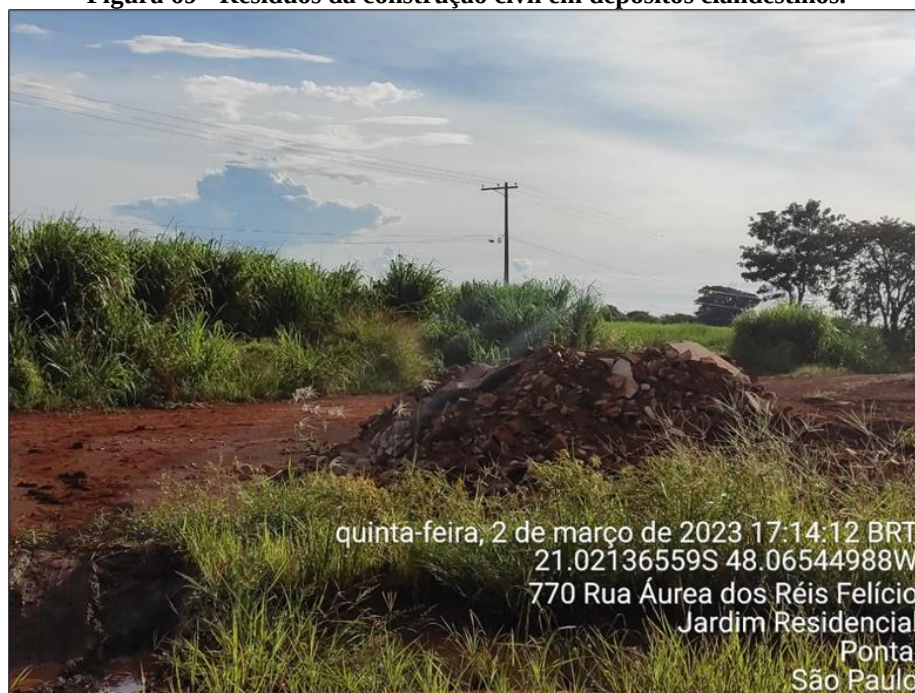
Figura 69 - Resíduos da construção civil em depósitos clandestinos.
