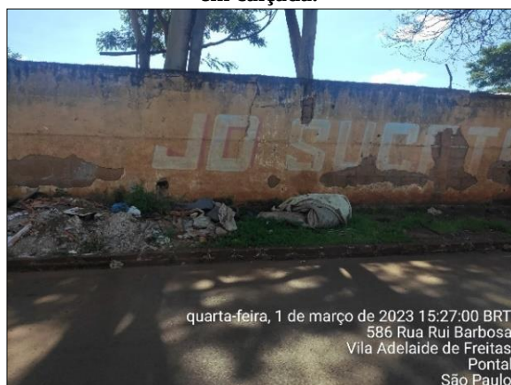
Figura 48 - Resíduos da construção civil dispostos em calçada.
