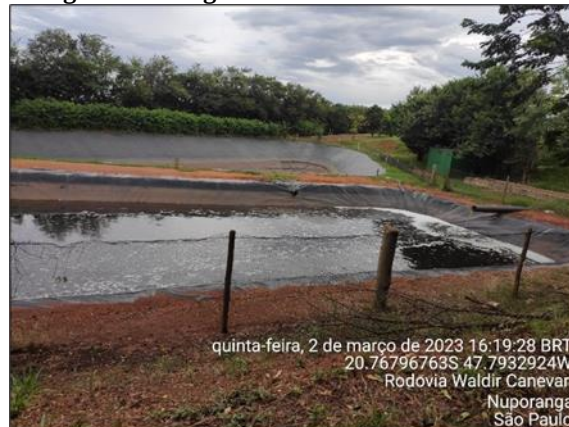
Figura 67 - Lagos de tratamento de chorume.
