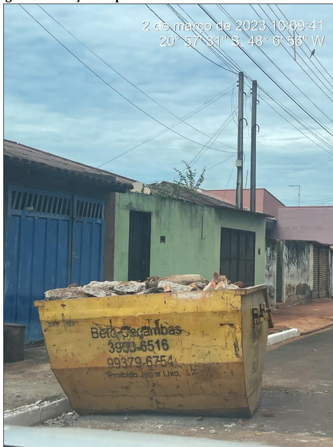
Figura 76 - Caçamba privada de coleta de RCC em Ponta – SP.
