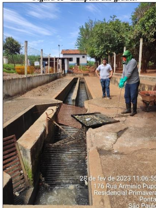
Figura 83 - Limpeza das grades.
