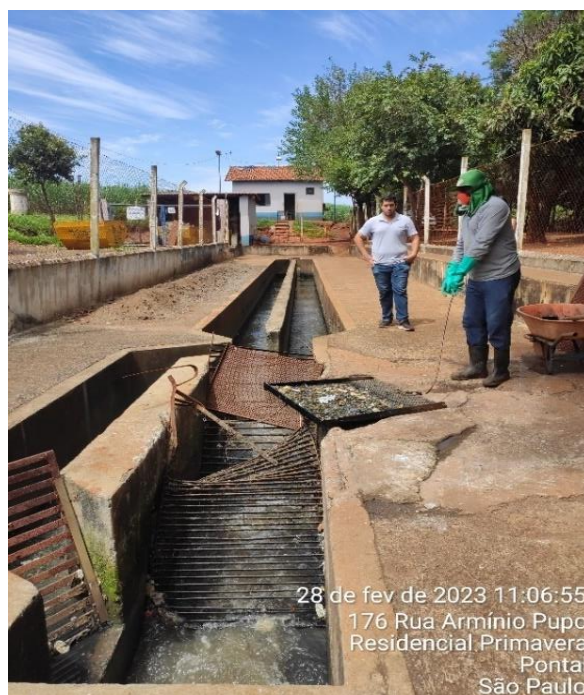
Figura 55 - LIMPEZA DAS GRADES.
