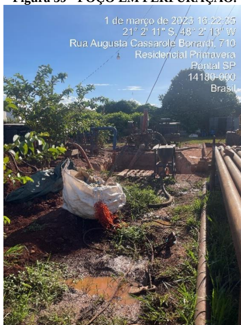
Figura 39 - POÇO EM PERFURAÇÃO.
