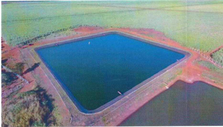
Figura 7: Lagoa Anaeróbia ETE – Pontal
