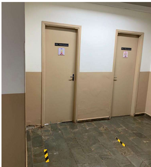
Foto 8 - Banheiro a ser reformado
