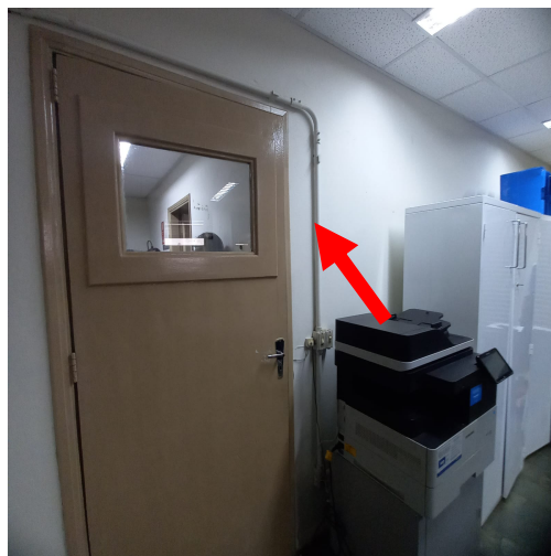
Foto 4 – Tipo de tubulação a ser removida
