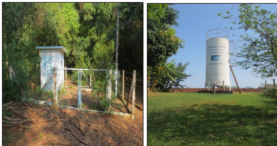
Figura 1 - Exemplo de SAC e reservatório de distribuição na zona rural de Marechal Cândido Rondon/PR.
