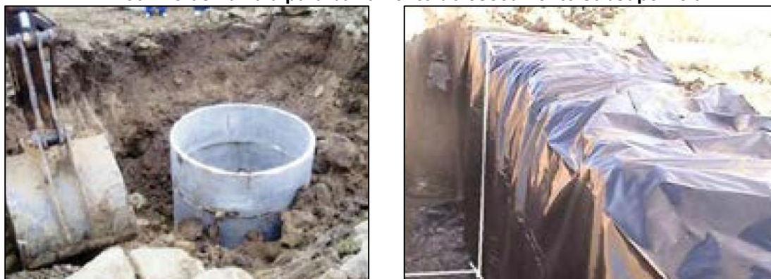
Figura 24 - Instalação de poço amazonas a montante da barragem e Fixação da lona de PVC 200 micras na vala para barramento do escoamento subsuperficial.
