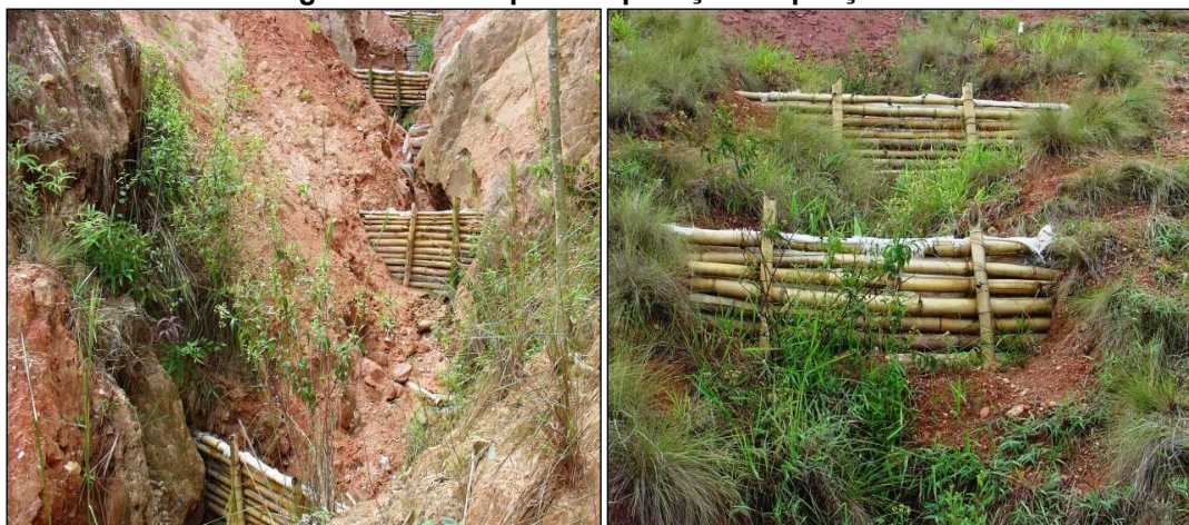
Figura 23 - Exemplo de aplicação de paliçadas.
