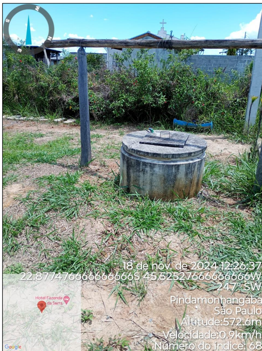
Figura 3 - Poço raso em propriedades rurais de Pindamonhangaba/SP.
