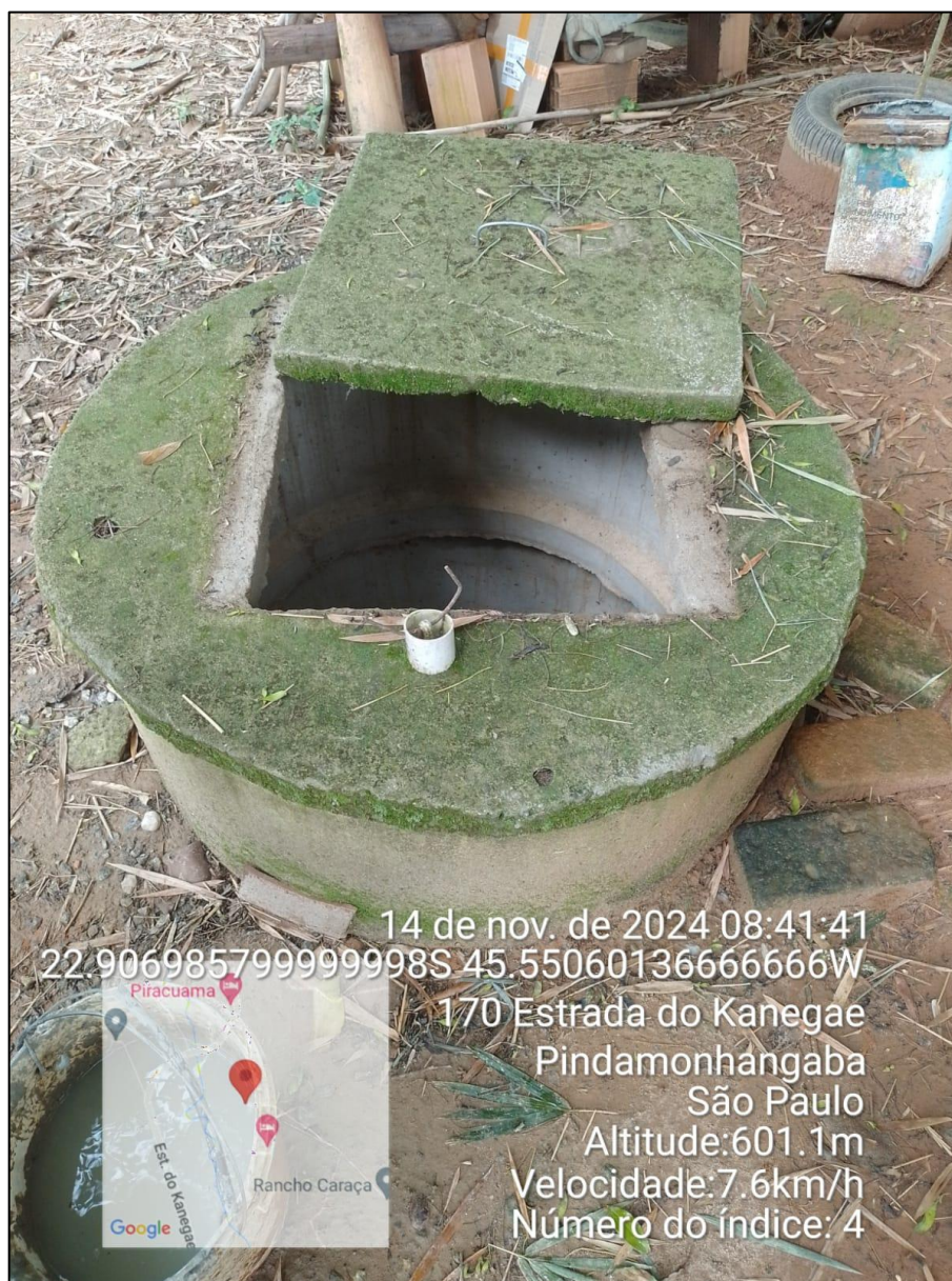
Figura 4 - Poço raso em propriedades rurais de Pindamonhangaba/SP.
