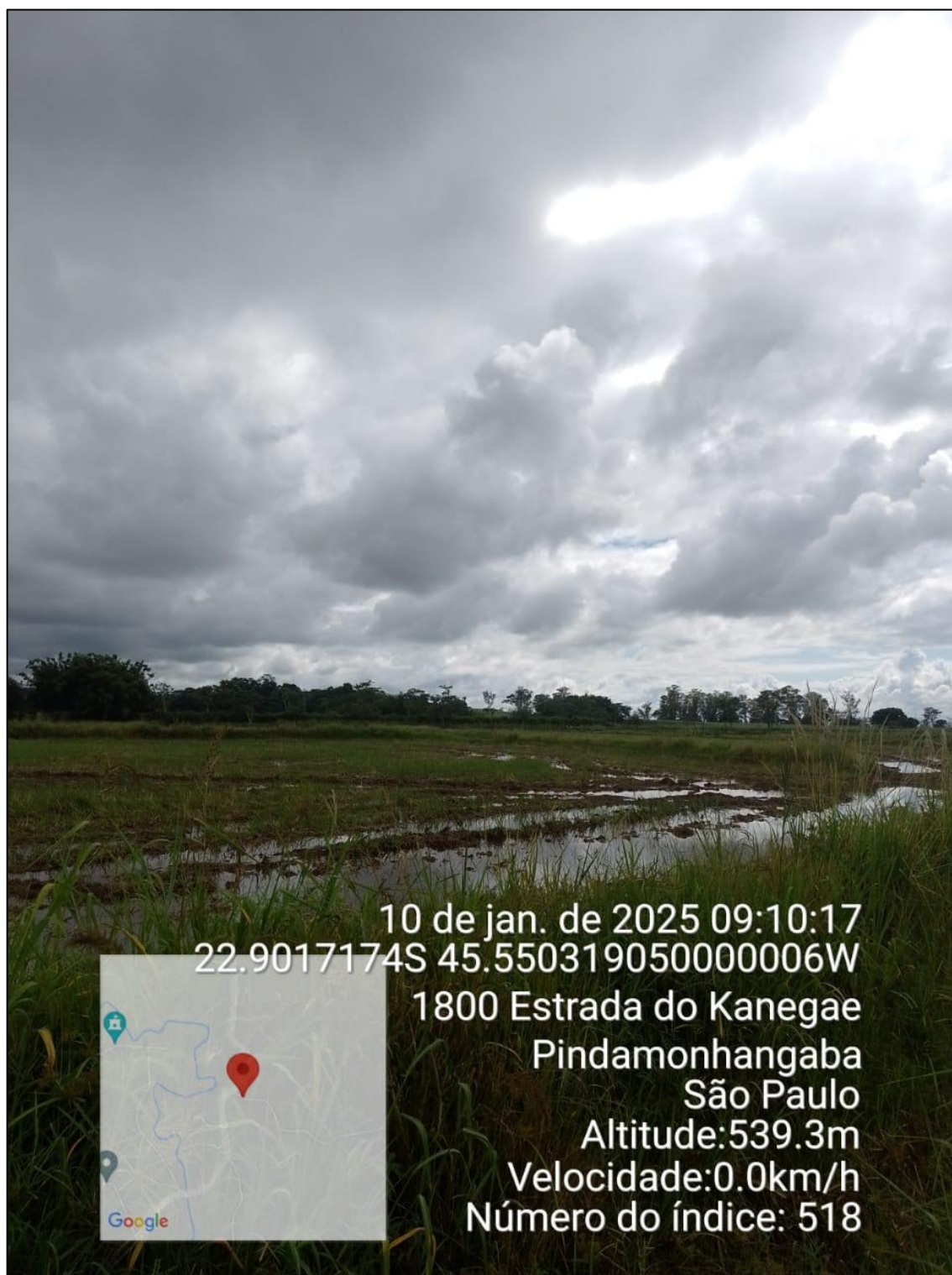
Figura 31 - Estrada rural de Pindamonhangaba com acúmulo de água.
