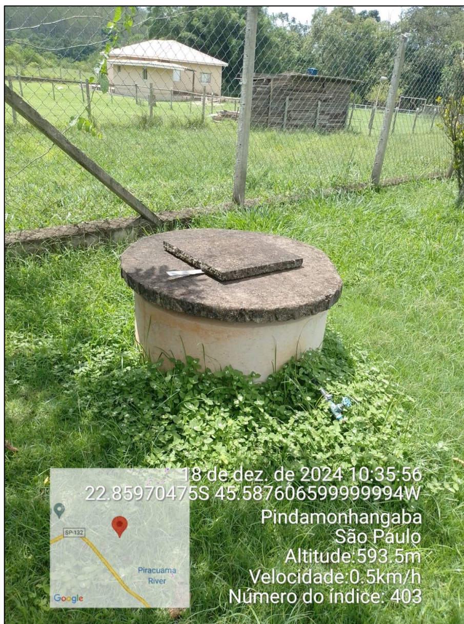
Figura 2 - Poço raso em propriedades rurais de Pindamonhangaba/SP.
