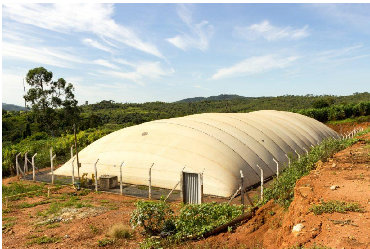
Figura 20 - Exemplo de biodigestor.
