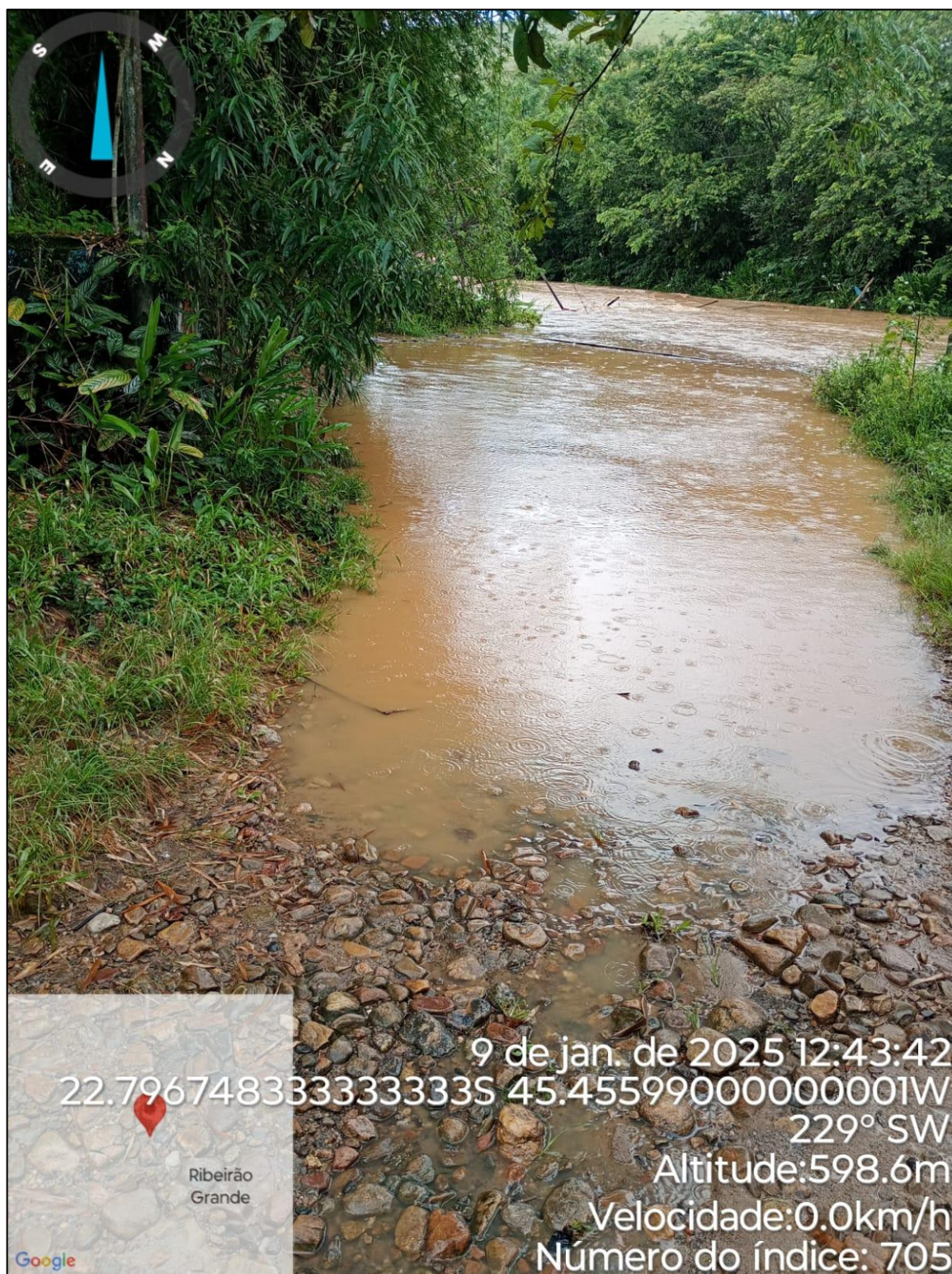
Figura 34 - Drenagem insuficiente para escoar a água.
