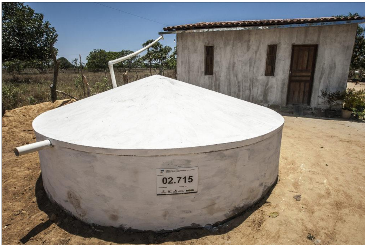
Figura 37 - Cisterna de superfície para armazenamento de águas pluviais.
