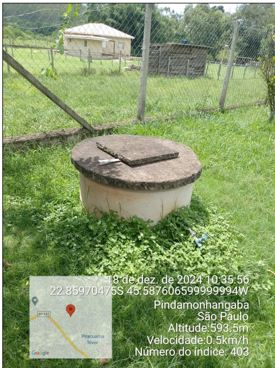
Figura 2 - Poço raso em propriedades rurais de Pindamonhangaba/SP.
