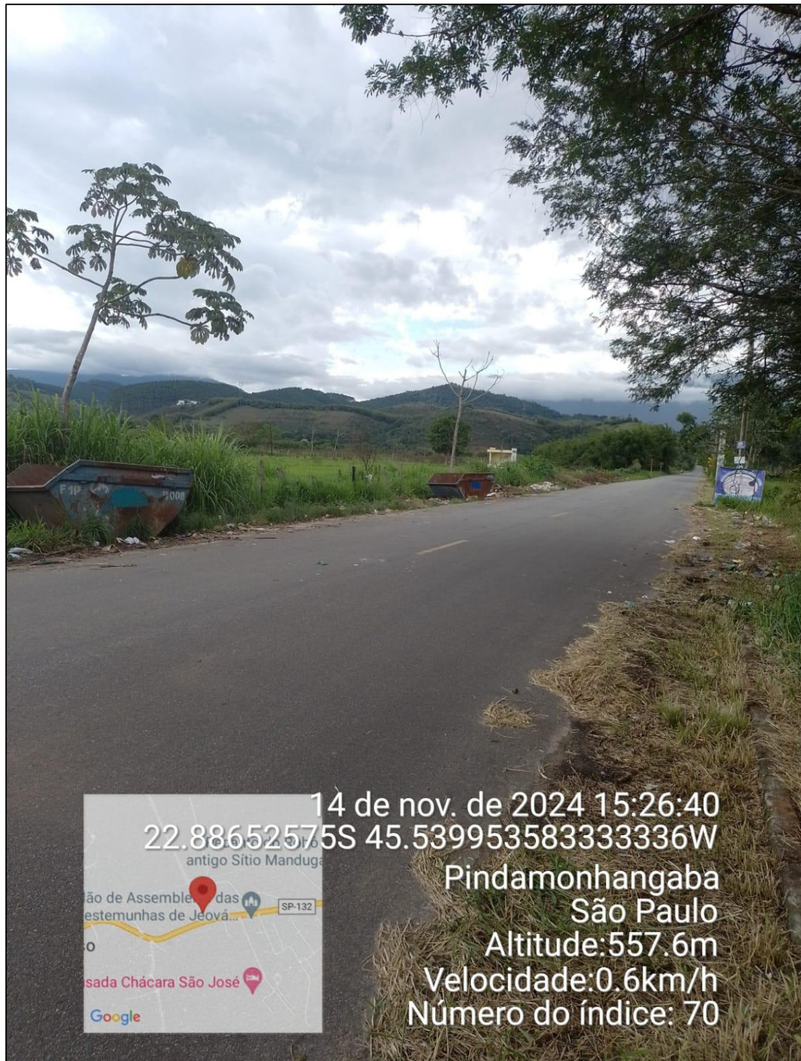
Figura 22 - Registros fotográficos de pontos de descarte irregular de resíduos sólidos. (Ponto 2: 22.8865257 S, 45.5399535 W).
