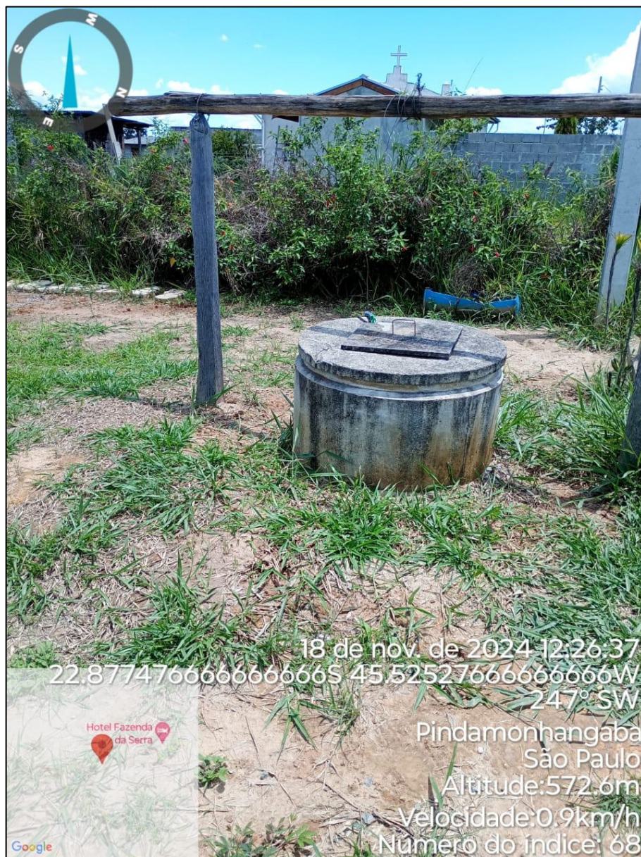
Figura 3 - Poço raso em propriedades rurais de Pindamonhangaba/SP.
