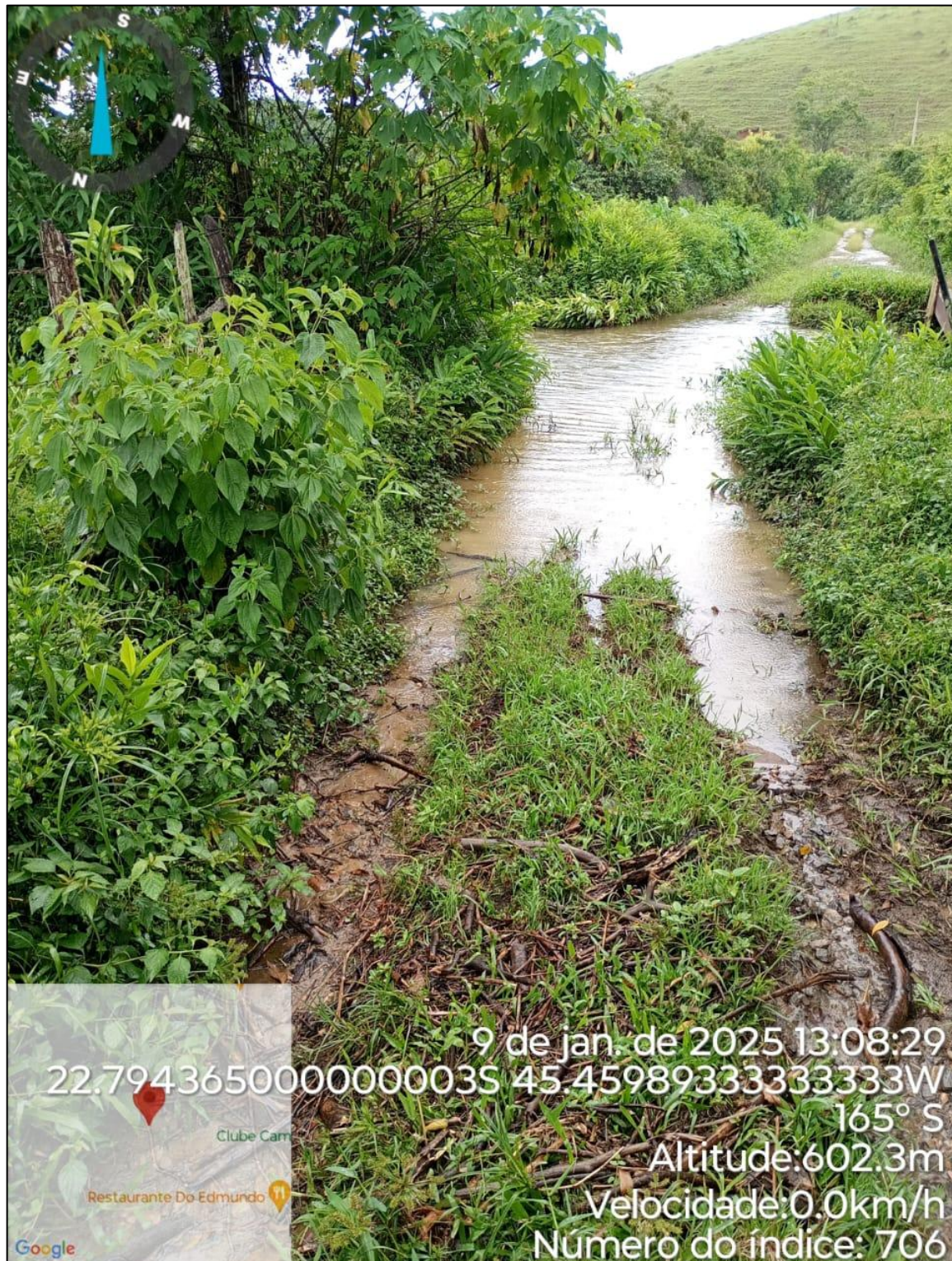
Figura 32 - Estrada rural alagada.
