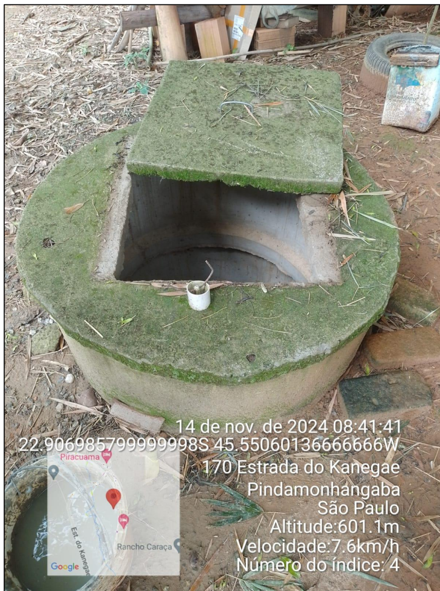
Figura 4 - Poço raso em propriedades rurais de Pindamonhangaba/SP.
