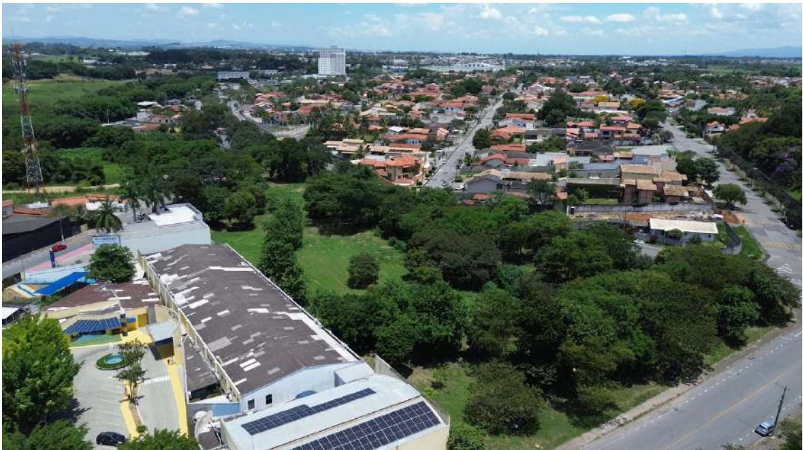
Figura 1-83 Curso d'água canalizado na área urbanizada - Sub-bacia Ribeirão da Galega
