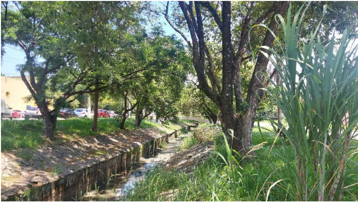
Figura 1-82 Curso d'água retificado na área urbanizada - Sub-bacia Ribeirão da Galega
