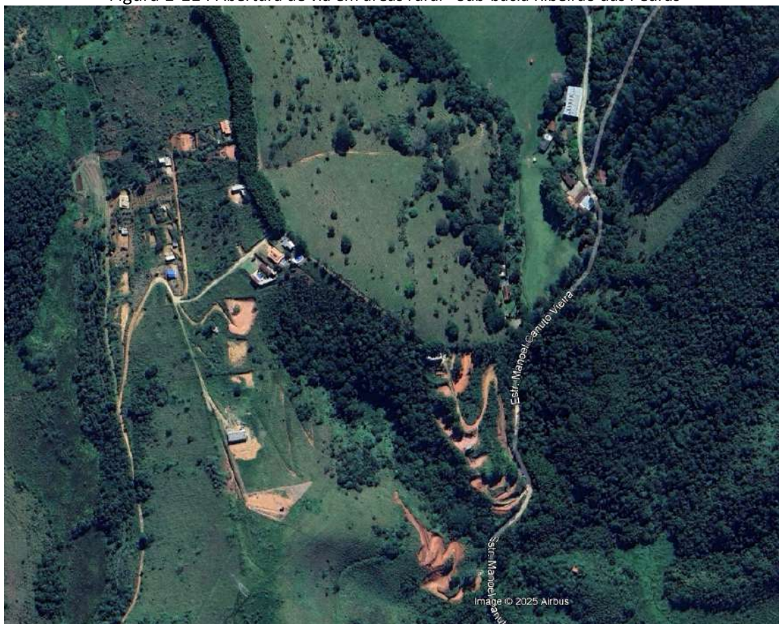
Figura 1-114 Abertura de via em áreas rural - Sub-bacia Ribeirão das Pedras
